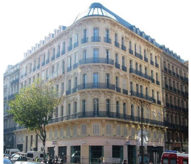
Edificio: Comisaría de Policía de Marsella Arquitecto: E. Nebout
