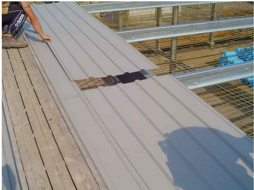
Figura 2.4 Instalación de la chapa interior apoyada sobre las correas.
