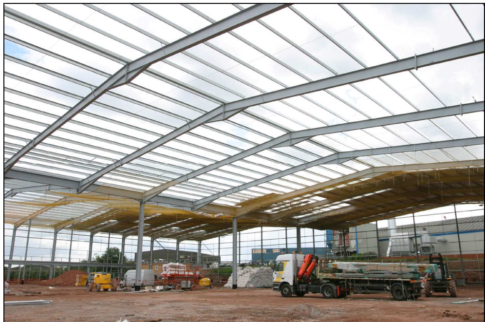
Figura 4.1 Correas posicionadas entre las vigas de la cubierta
