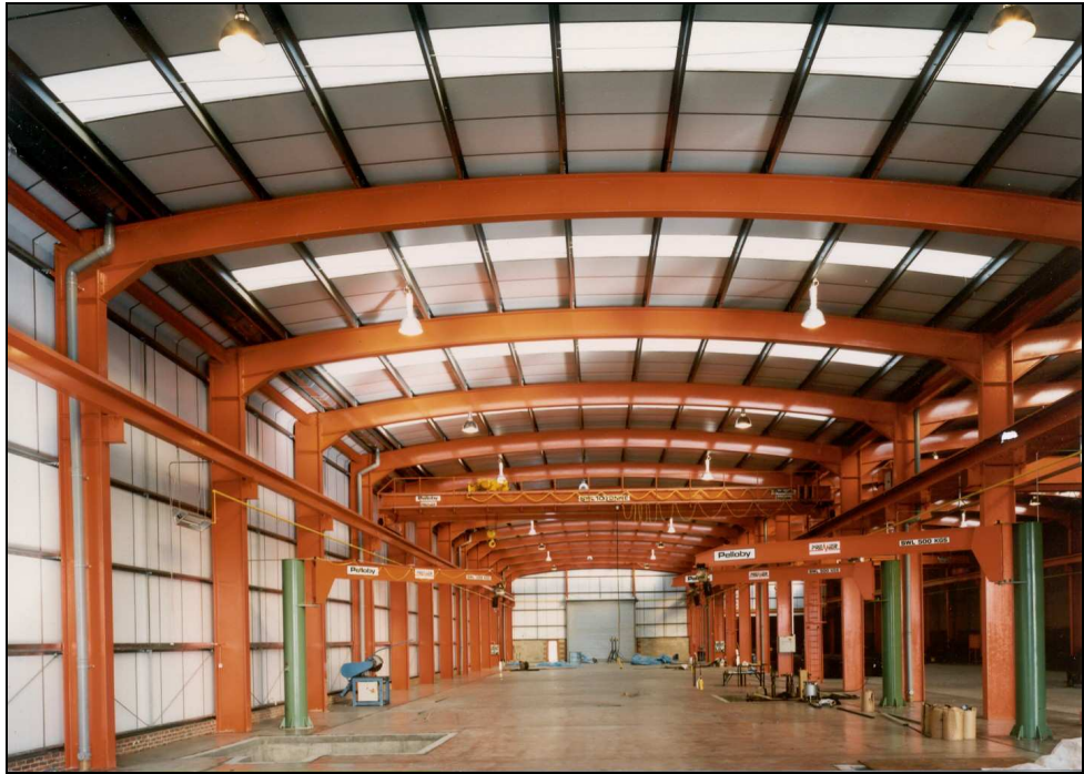
Figura 3.22 Dinteles curvos usados en pórticos-arco
