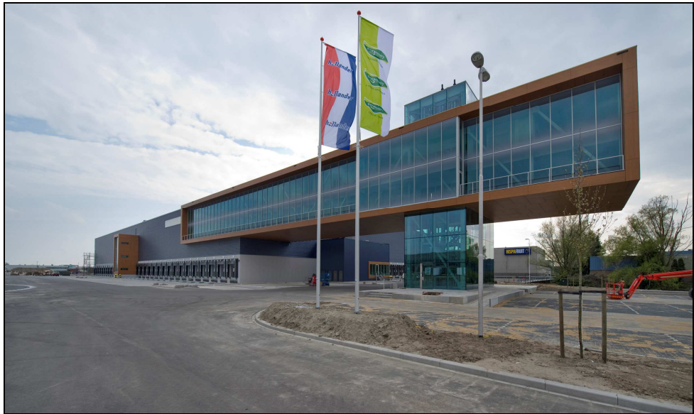
Figura 2.7 Centro de distribución, Barendrecht, Holanda, vista del voladizo y del arriostramiento de la estructura del edificio de oficinas
