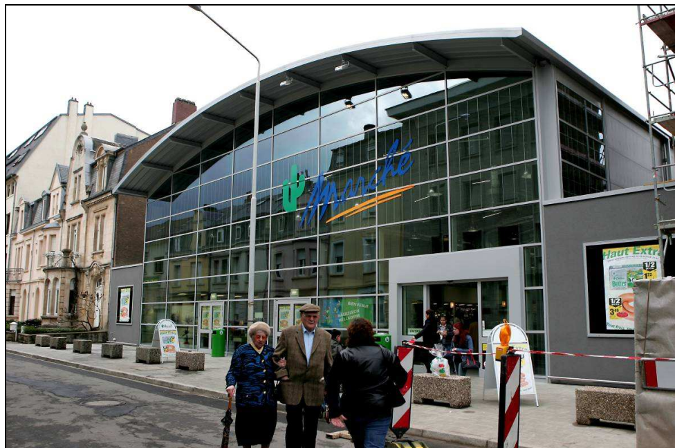
Figura 2.2 Supermercado en Esch , Luxemburgo, con vigas alveolares curvas
