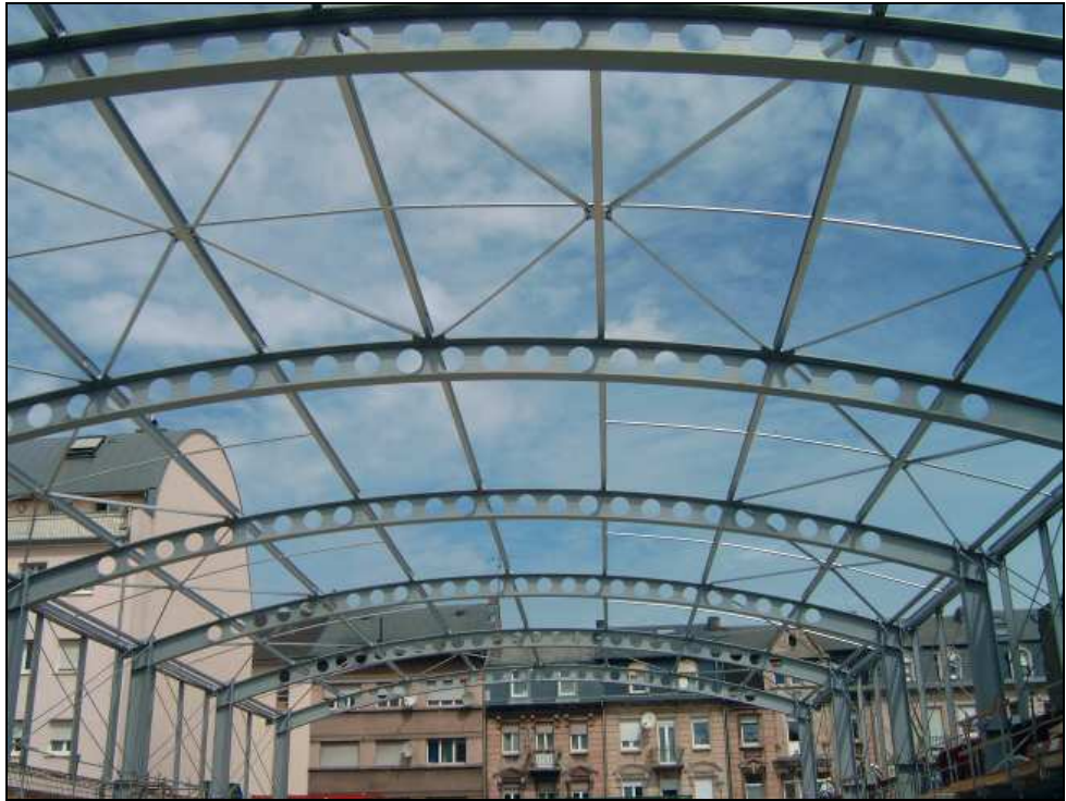
Figura 2.3 Pórtico utilizando vigas alveolares curvas
