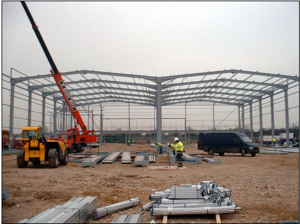
Figura 3.24 Estructura porticada de varios vanos
