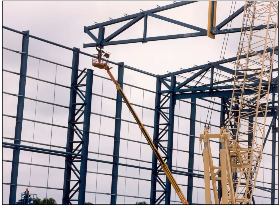
Figura 1.4 Celosías de cubierta sobre pilares compuestos
