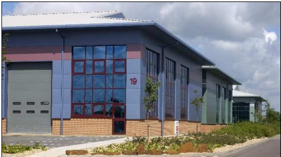
Figura 1.8 Edificios con grandes ventanas, paneles compuestos y paredes de mampostería
