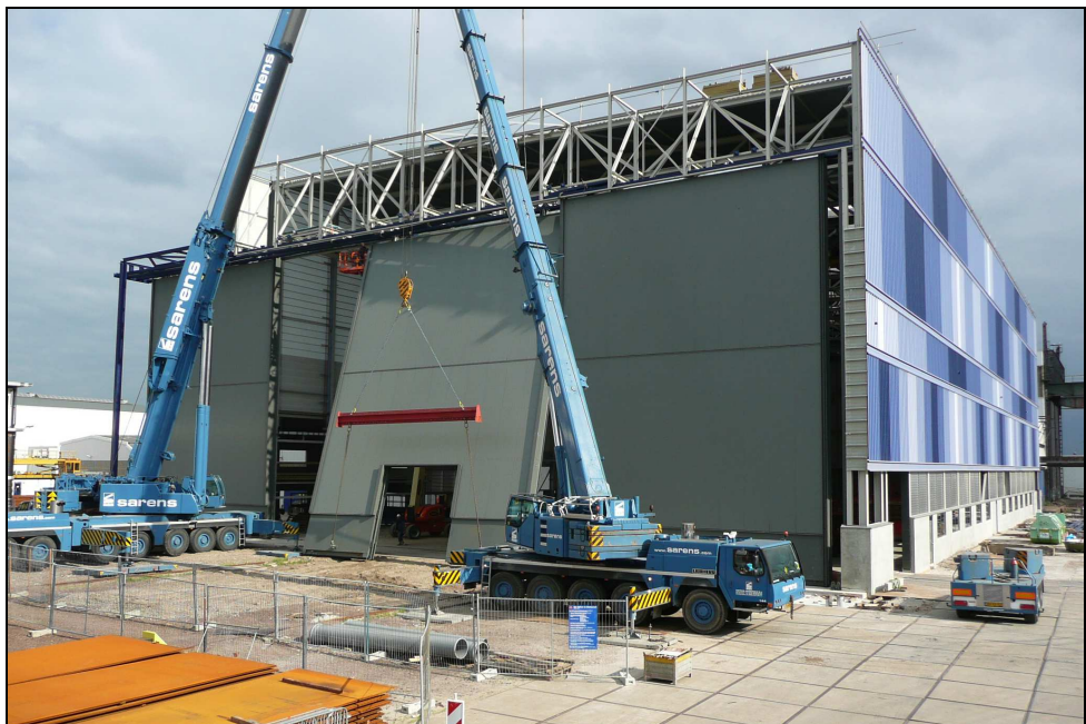
Figura 2.6 Vista de la colocación de las puertas en el edificio holandés de Krimpen aan den IJssel
