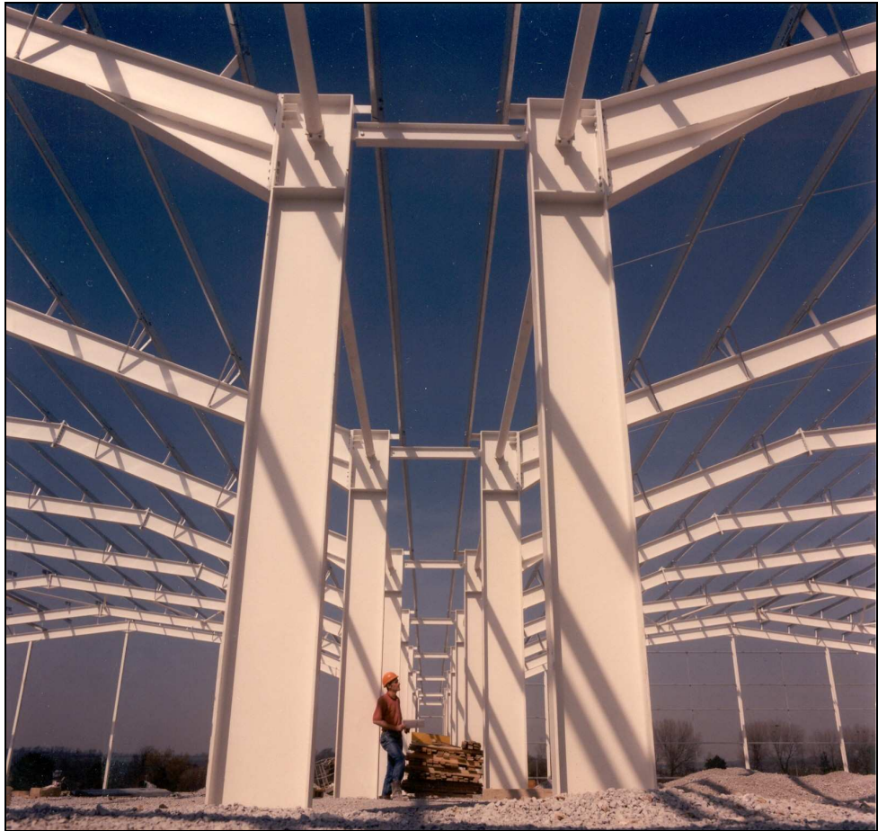
Figura 1.2 Estructura porticada de varios vanos
