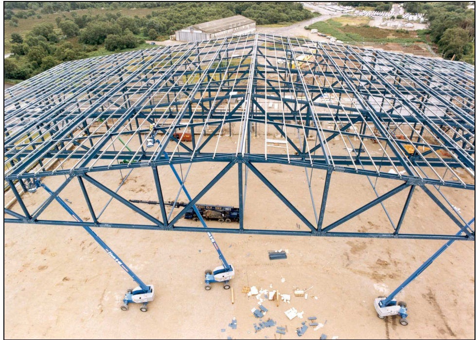
Figura 4.3 Celosía fabricada a partir de perfiles laminados
