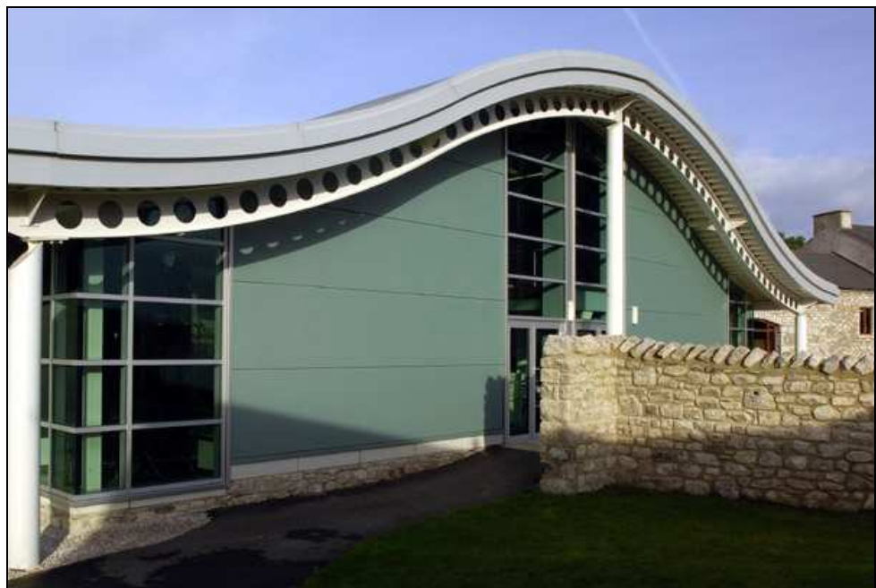
Figura 1.5 Centro de ocio construido con una cubierta curva sustentada sobre una viga alveolar
