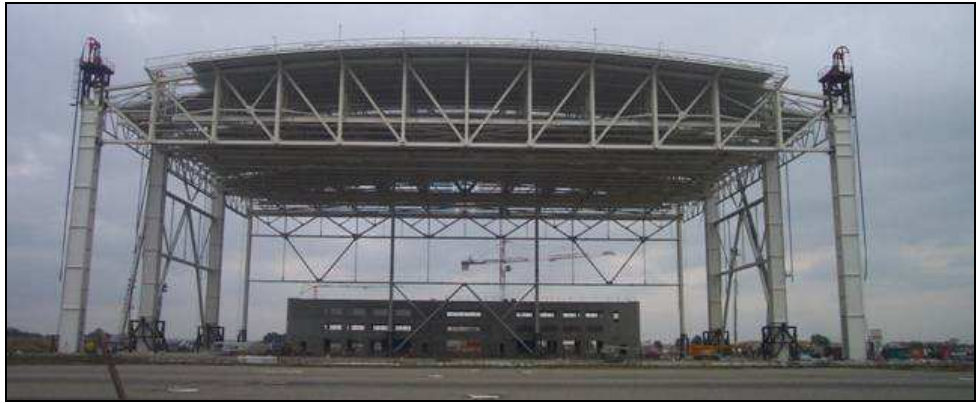
Figura 2.5 Vista del hangar de Airbus Industrie durante la construcción
