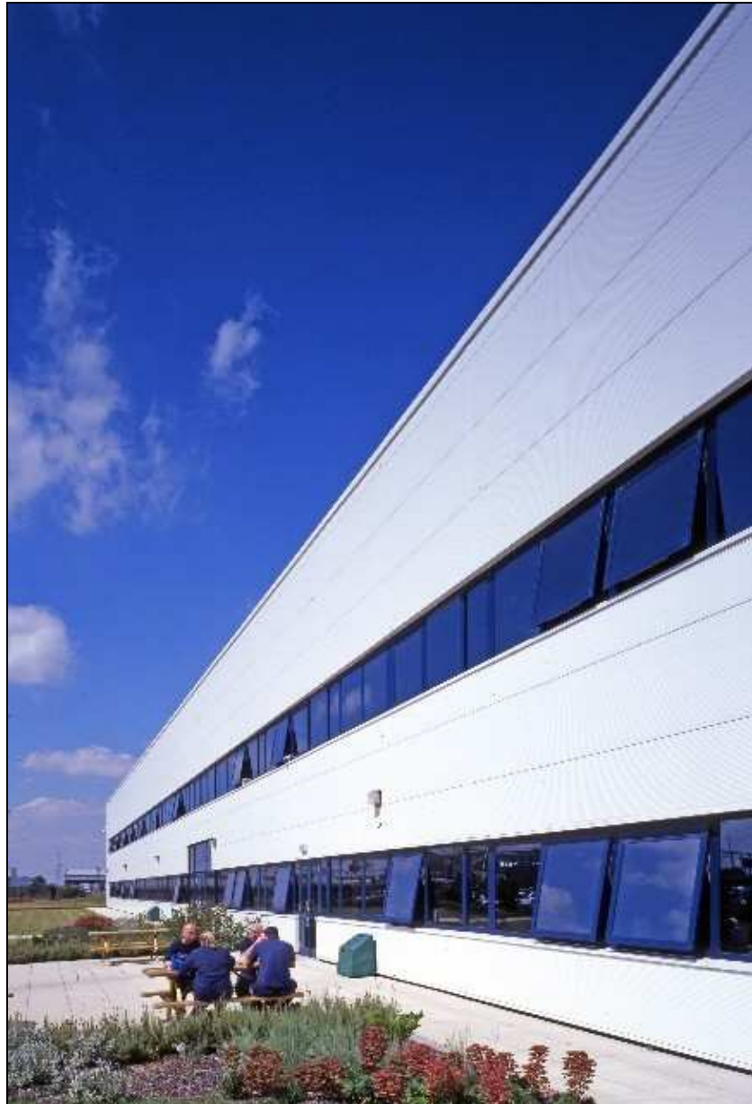
Figura 1.9 Paneles compuestos horizontales y ventanas tipo 'ribbon'
