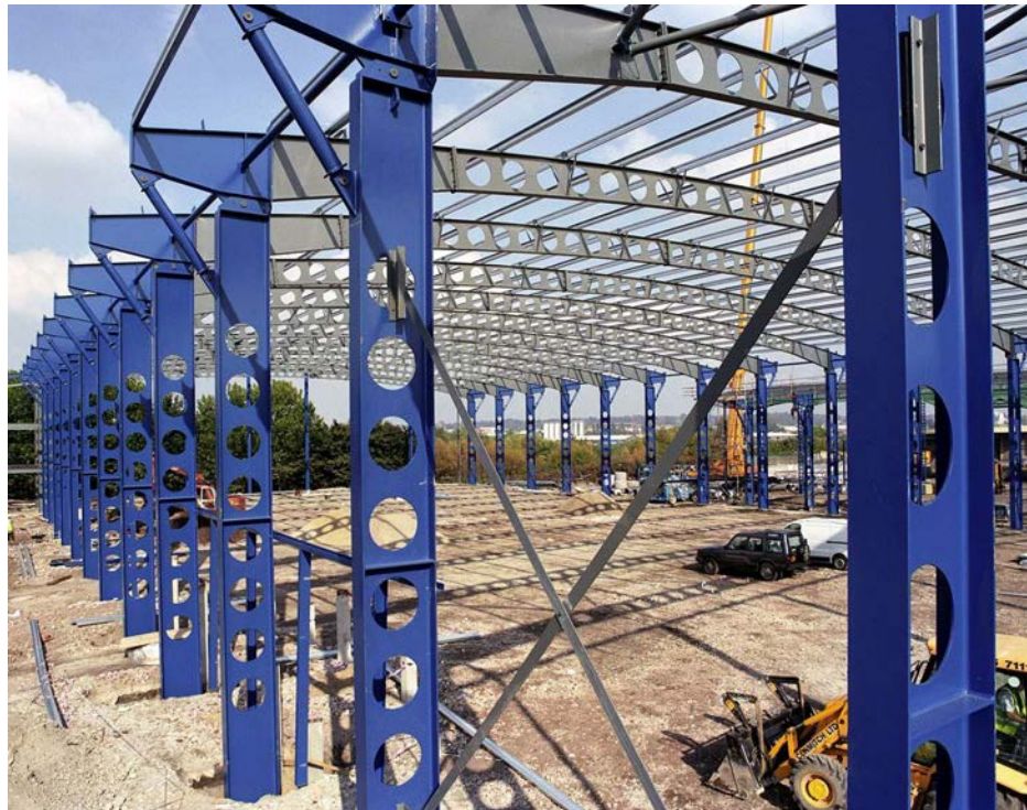
Figura 2.1 El reducido peso propio de las estructuras de acero, minimiza el transporte de material a pie de obra
