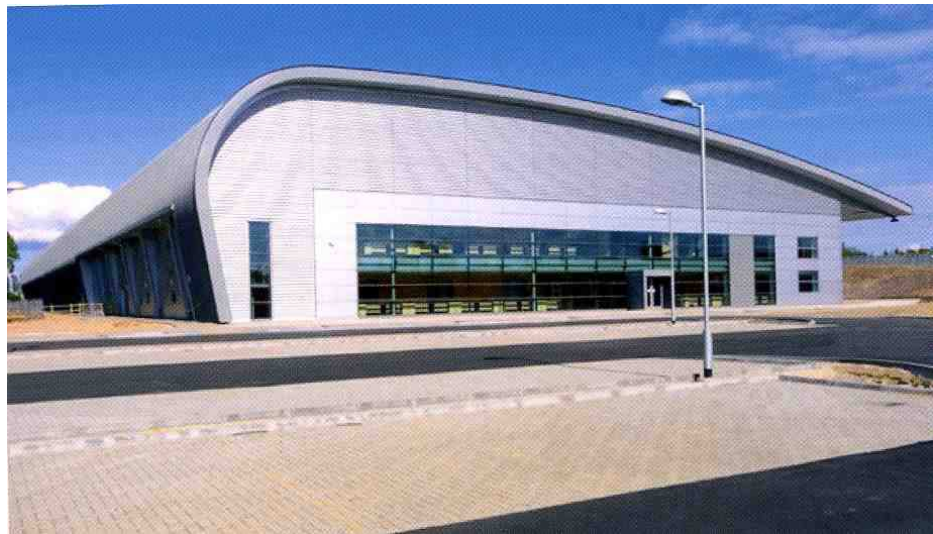
Figura 1.4 Edificio industrial moderno con cubierta curva de acero.
