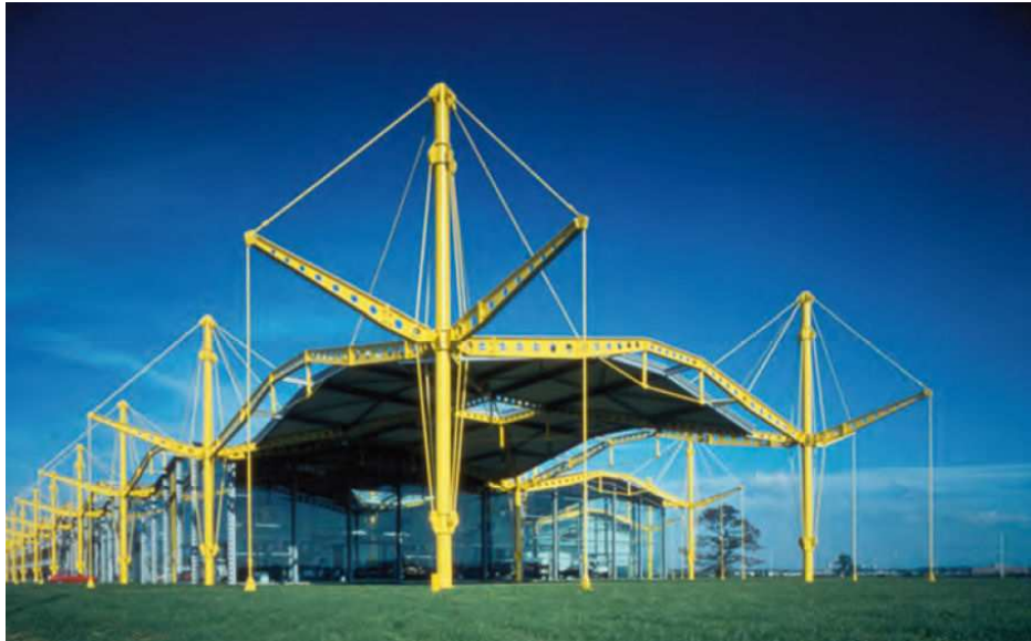
Figura 2.4 Impresionante estructura metálica
