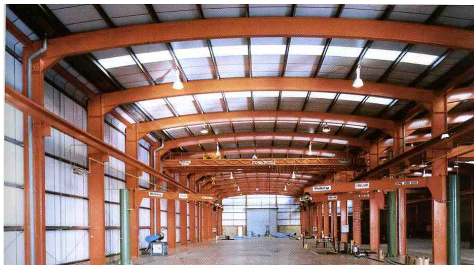
Figura 3.4 Pórtico con cubierta curva
