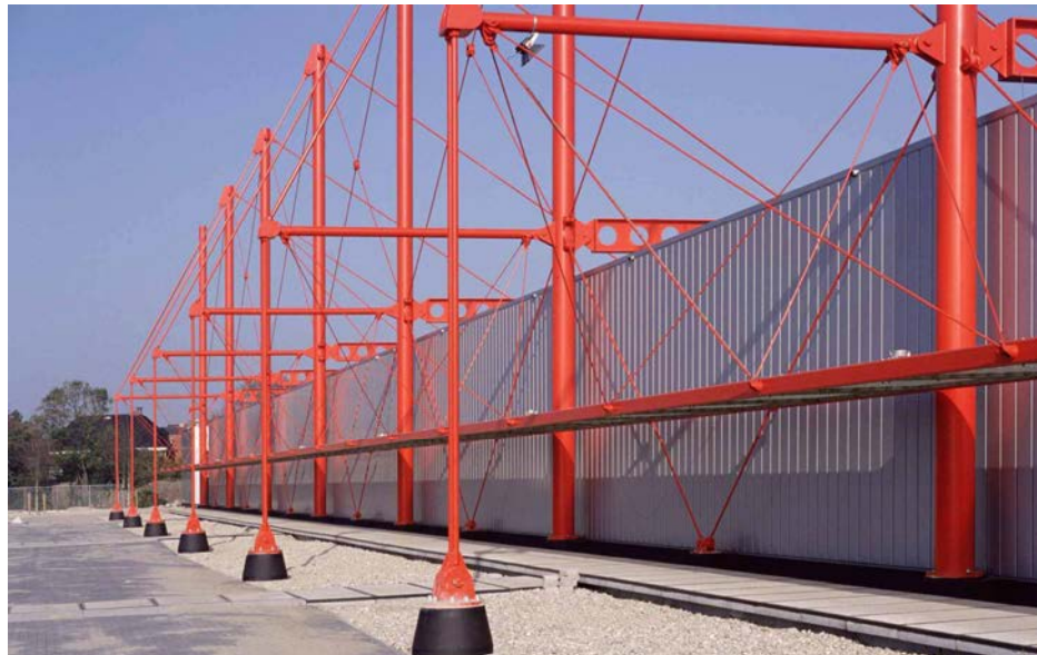
Figura 3.20 Cubierta y estructura atirantada de un almacén
