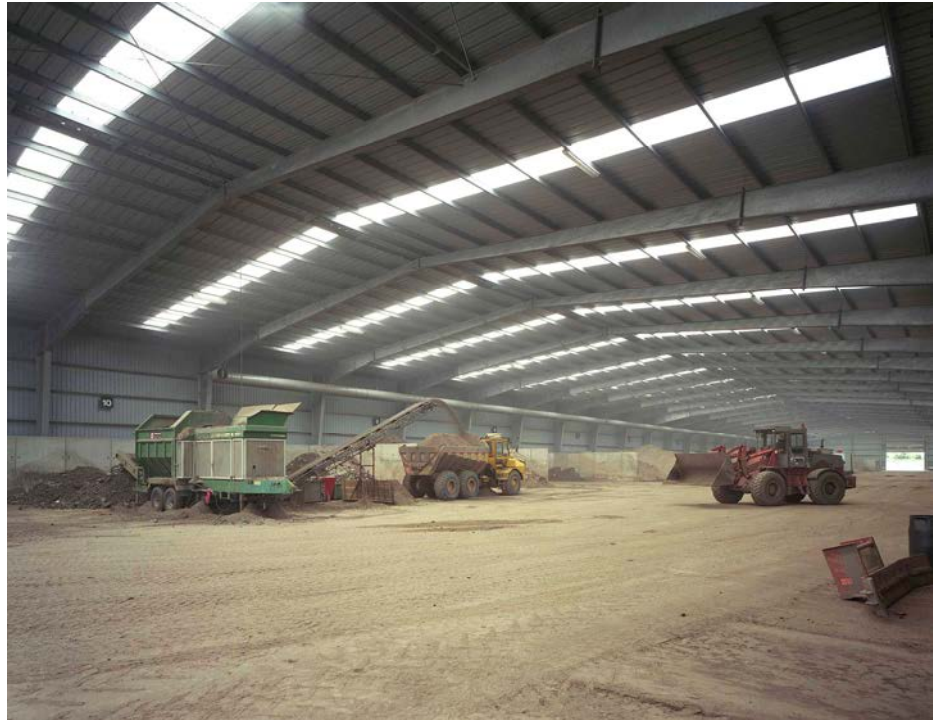
Figura 3.3 Pórtico con cubierta a dos aguas
