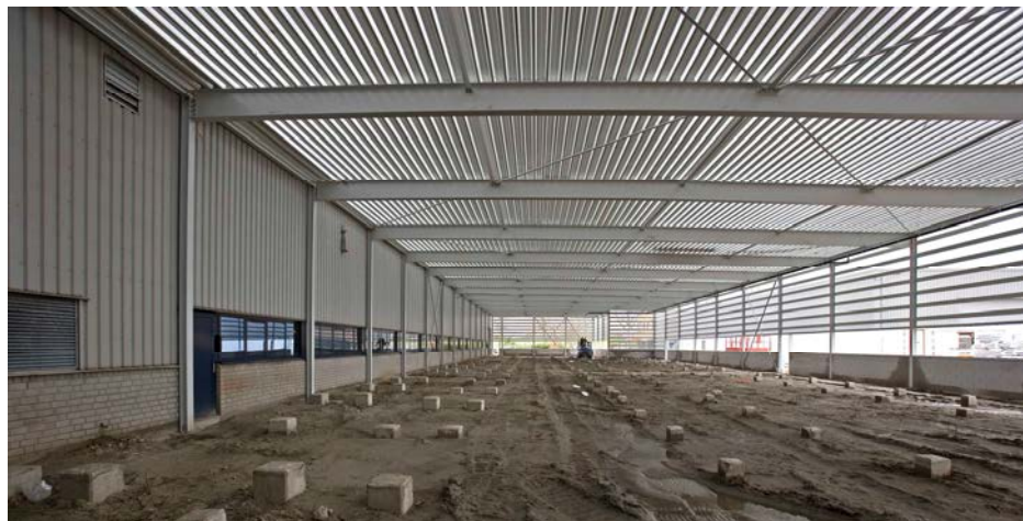
Figura 3.12 Estructura de vigas y pilares articulados
