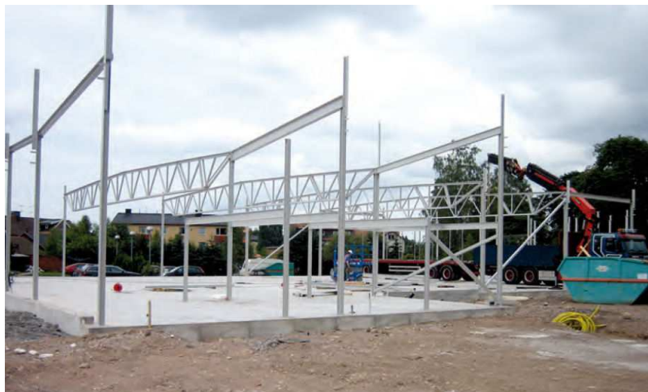
Figura 3.17 Cercha plana en una estructura con nudos articulados
