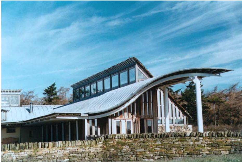
Figura 1.1 Estructura de una sola planta con cubierta curva
