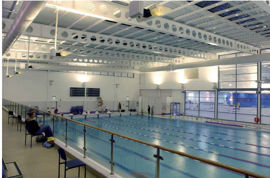
Figura 3.15 Vigas alveolares con alvéolos circulares
