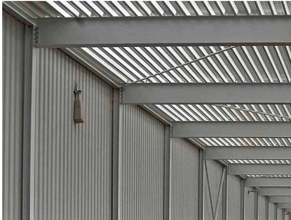
Figura 2.3 El montaje y ensamblado de los elementos prefabricados es rápido y sencillo
