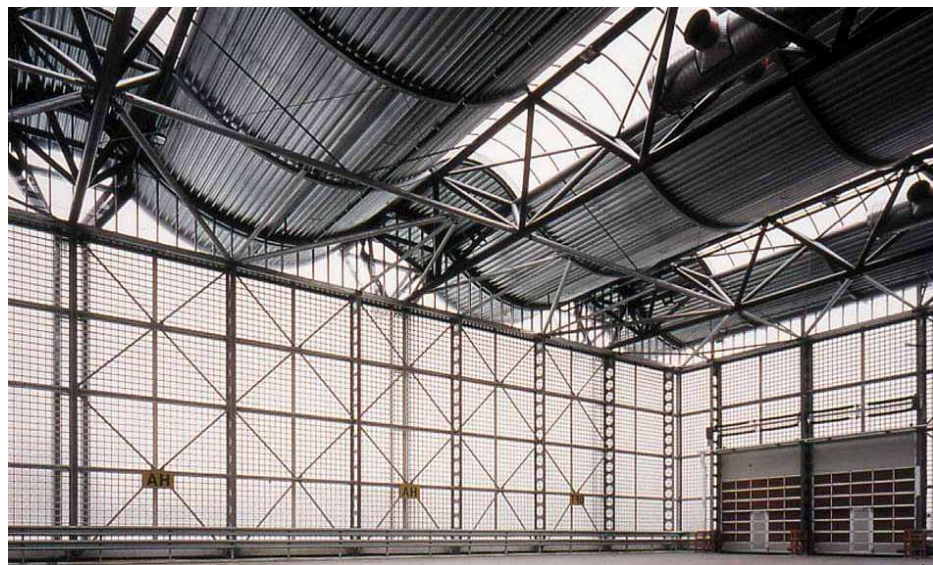
Figure 3.19 Cercha tridimensional sustentando una cubierta
