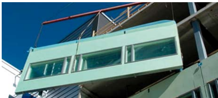
Abbildung 4.5 Vorgefertigte Wandelemente mit Außenhülle und Fenstern Ruukki
