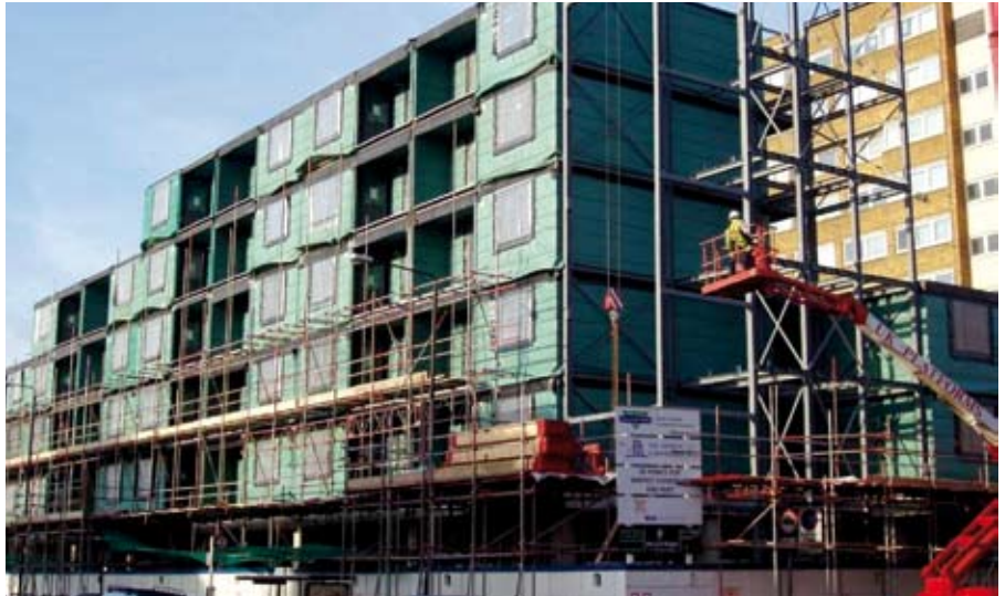
Abbildung 6.6 Gebäude in Modulbauweise auf einem stählernen Sockel mit aussteifendem Treppenkern
