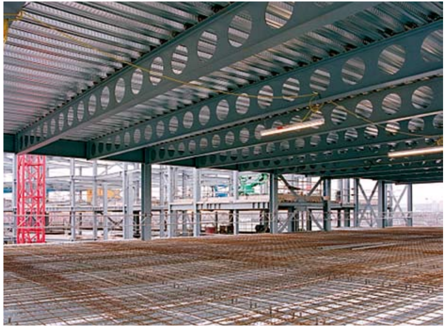
Abbildung 5.3 Verbunddecken und Verbundträger aus Cellform-Profilen
