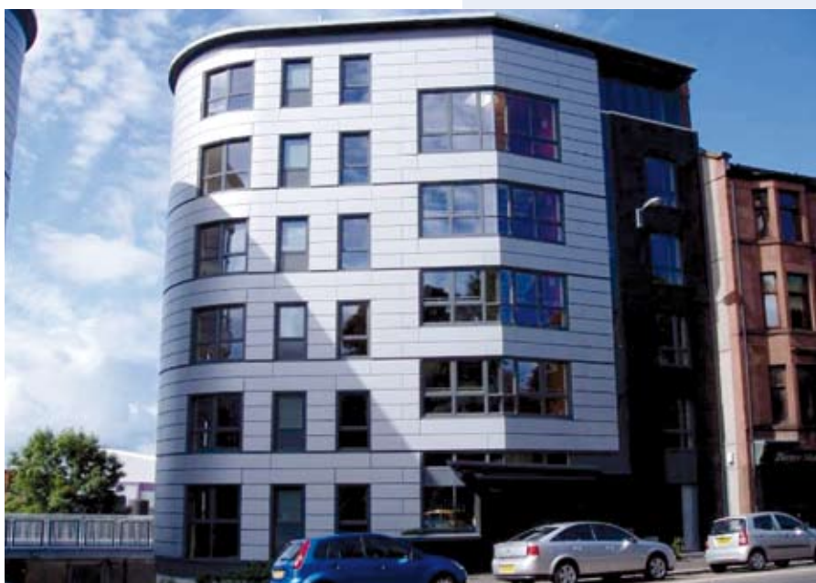
Abbildung 7.1 Wohngebäude in Stahlleichtbauweise mit Metallfassade in Glasgow Peck and Reid Architects & Metsec
