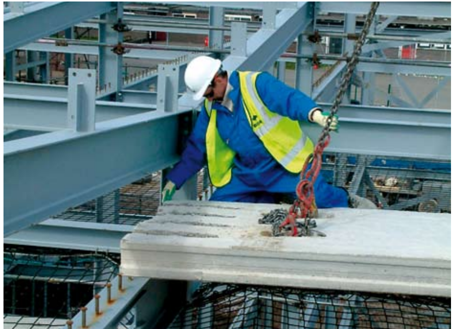
Abbildung 5.2 Montage von Betonfertigteilen auf Stahlträgern
