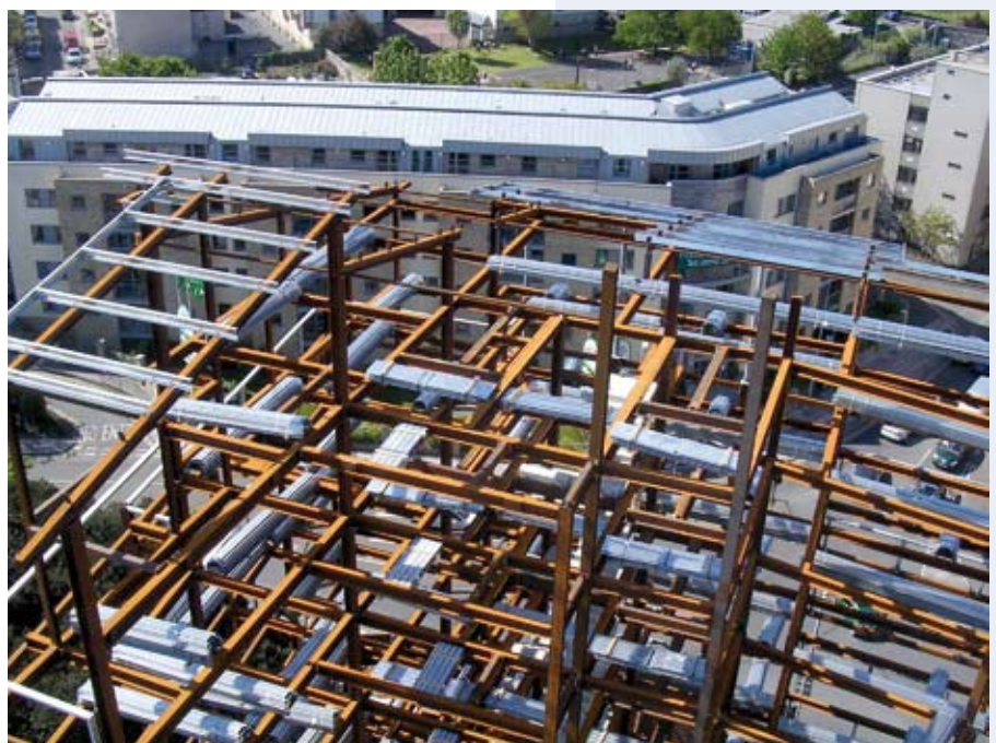
Abbildung 5.1 Stahltragwerk mit ASB-Profilen und Verbundrippendecken im Bauzustand
