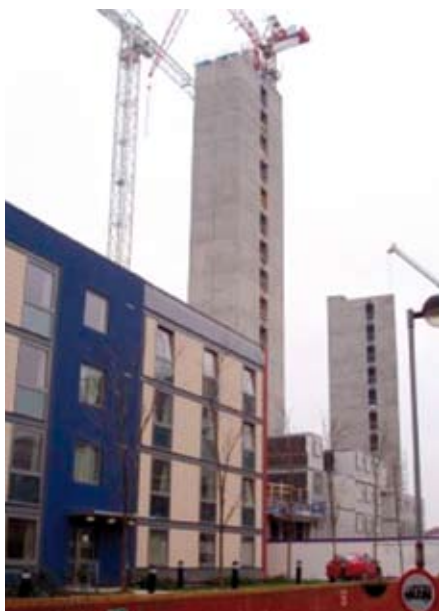
Module und aussteifender Betonkern
