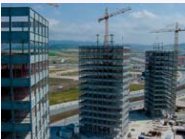
Bioclimatic Towers im Bau
