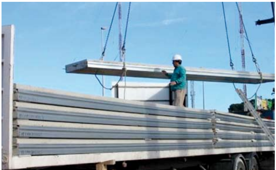
Abbildung 8.13 Cofradal – Typischer Querschnitt und Elemente während der Montage
