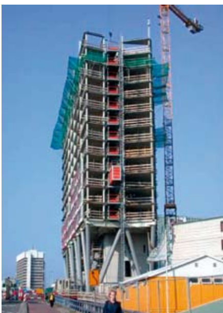
(oben) Gebäude in der Bauphase
