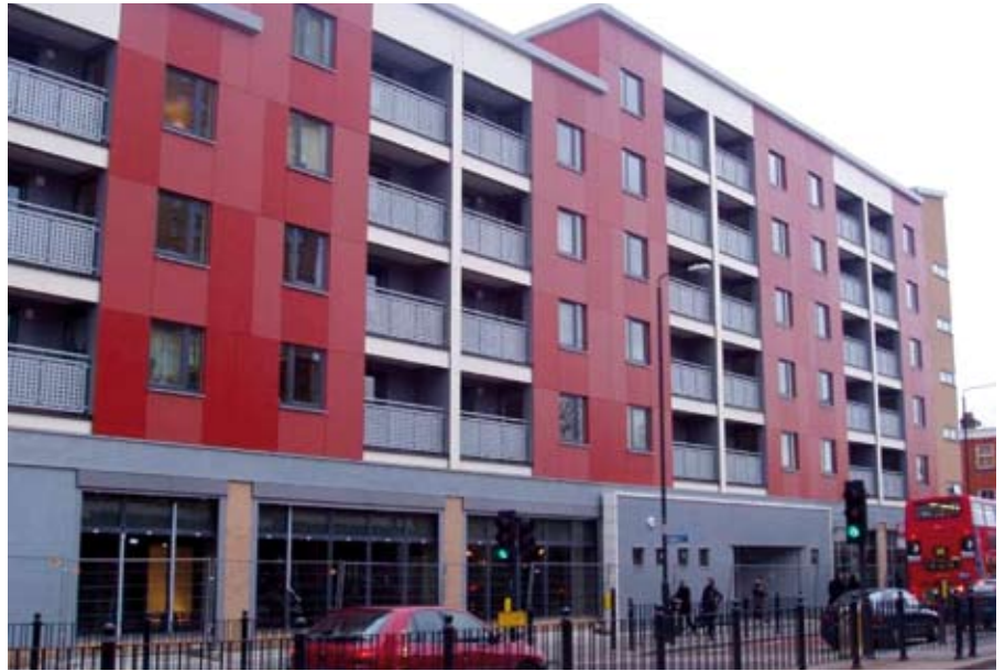
Abbildung 6.7 Fertiggestelltes Gebäude aus Abbildung 6.7
