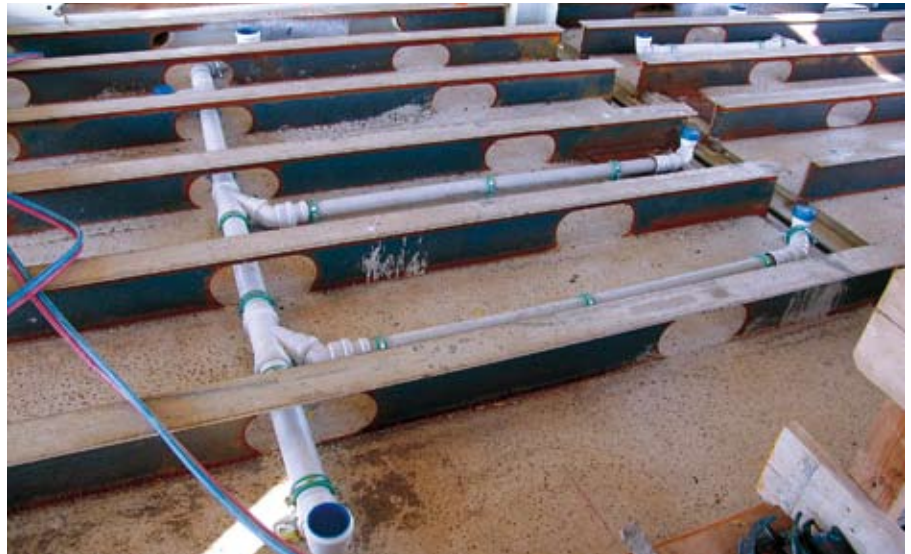
Abbildung 5.5 „Umgekehrte“ Stahlträger (Slimline)
