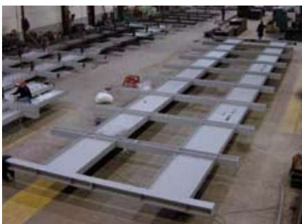
Werkstattfertigung der tragenden Fassadenelemente
