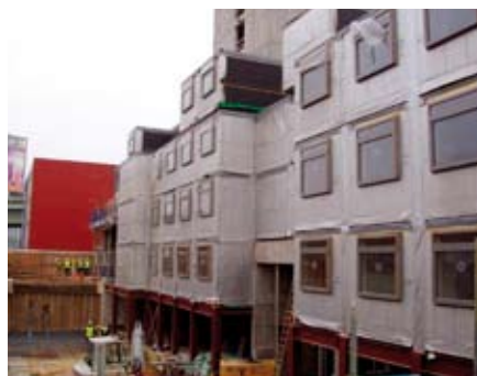
Montage der Module auf Stahlsockel
