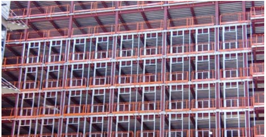
Abbildung 4.4 Nichttragende Außenwände aus Stahl in einer Verbundkonstruktion
