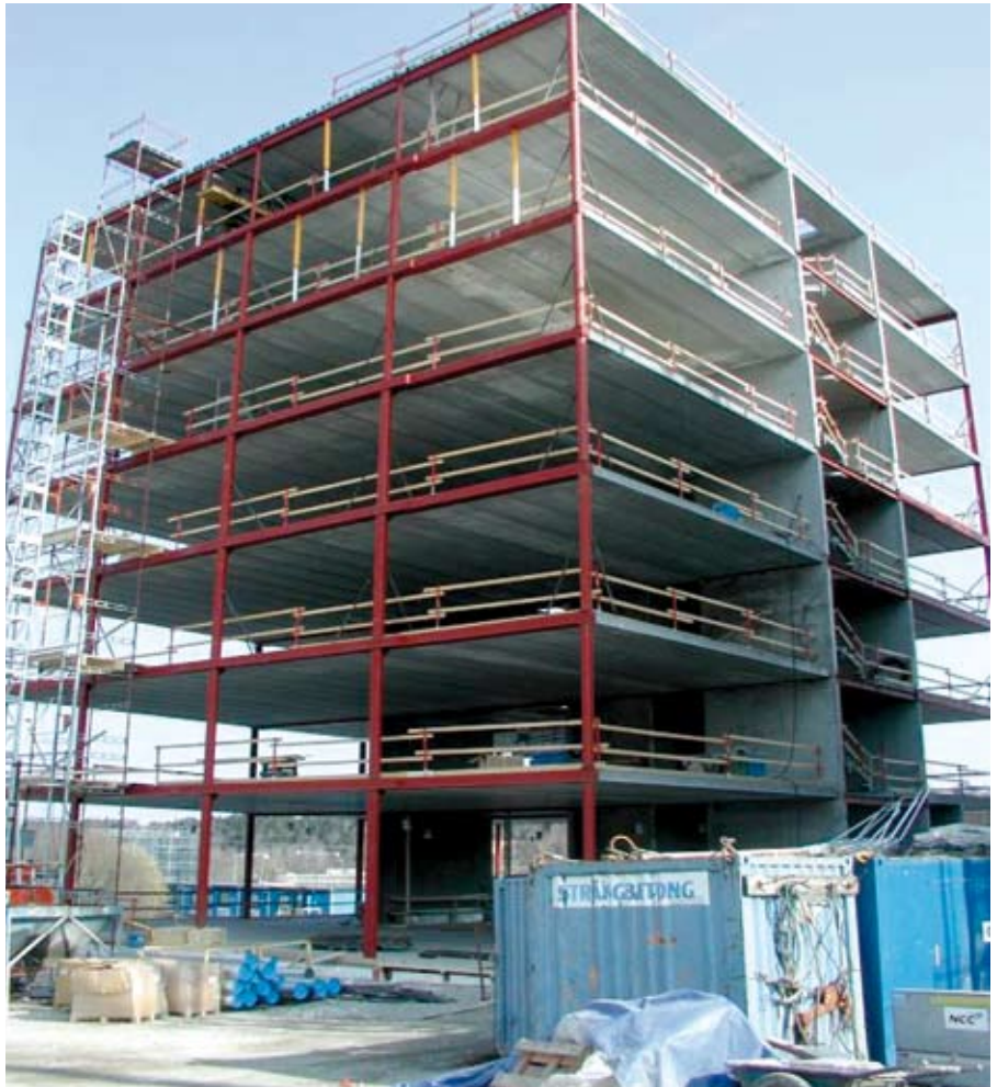
Abbildung 8.15 Beispiel für ein 7-geschossiges Wohnhaus mit Slim-Floor-Decken in Schweden
