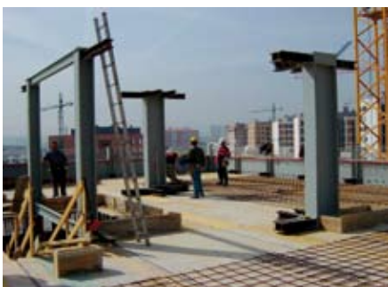
Baufortschritt mit Innenstützen aus Stahl
