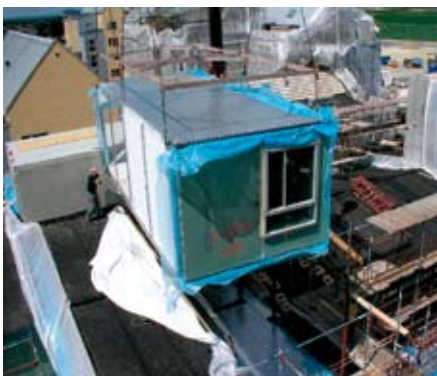
(oben) Montage eines Moduls
