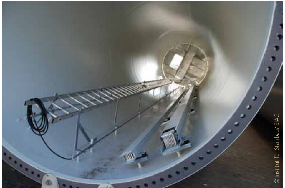
Abbildung 7: Innenansicht eines Turms
