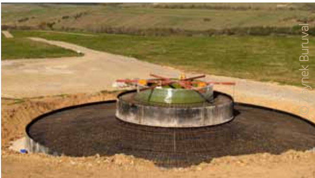
Abbildung 2: Bewehrungsstäbe für Landfundamente
