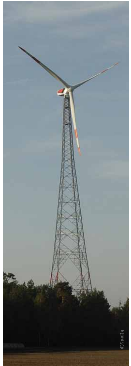
Abbildung 4: 160-m-Windturbine in Laasow (Fuhländer)
