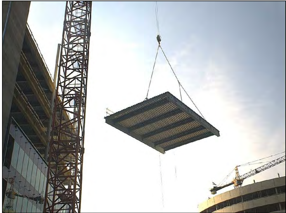
Rysunek 3.9 System prefabrykowanych kaset stropowych
