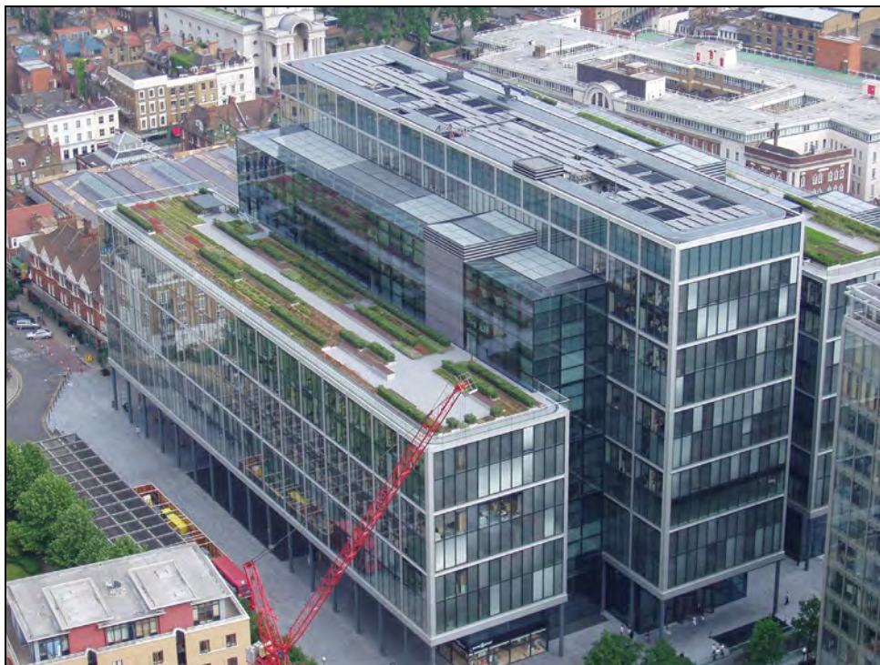
Rysunek 1.6 „Zielony” dach oraz panele fotowoltaiczne zamontowane na biurowcu w centrum miasta
