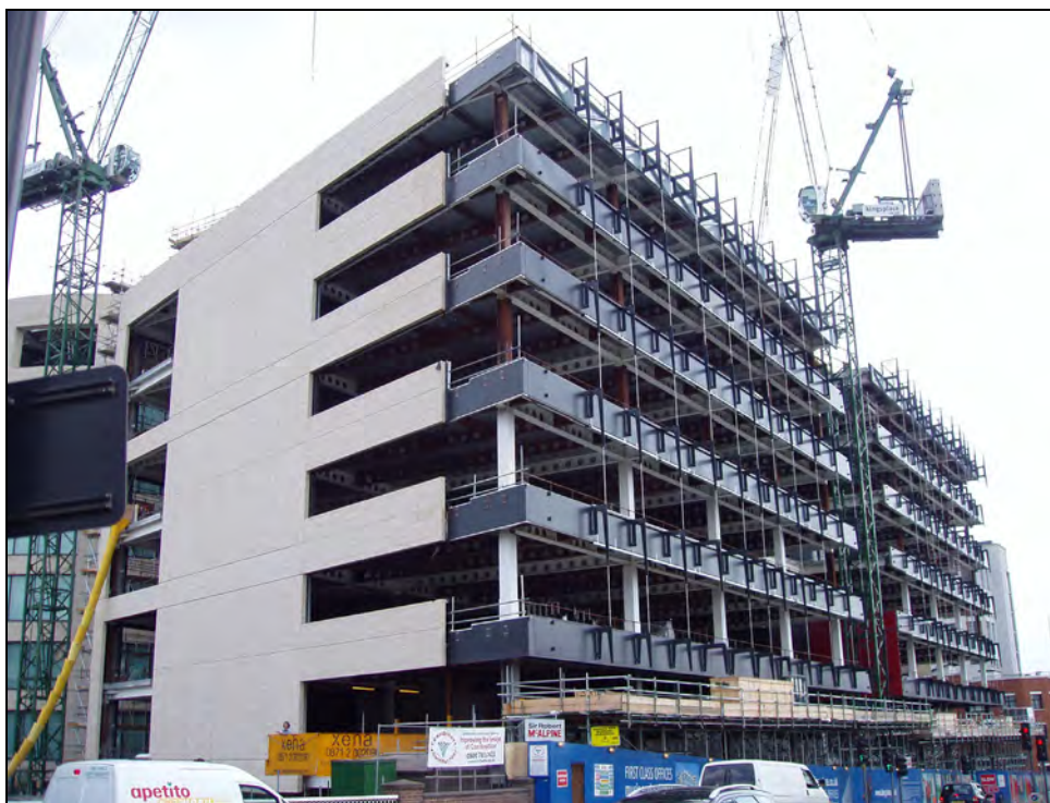
Rysunek 3.6 Kings Place w trakcie budowy
