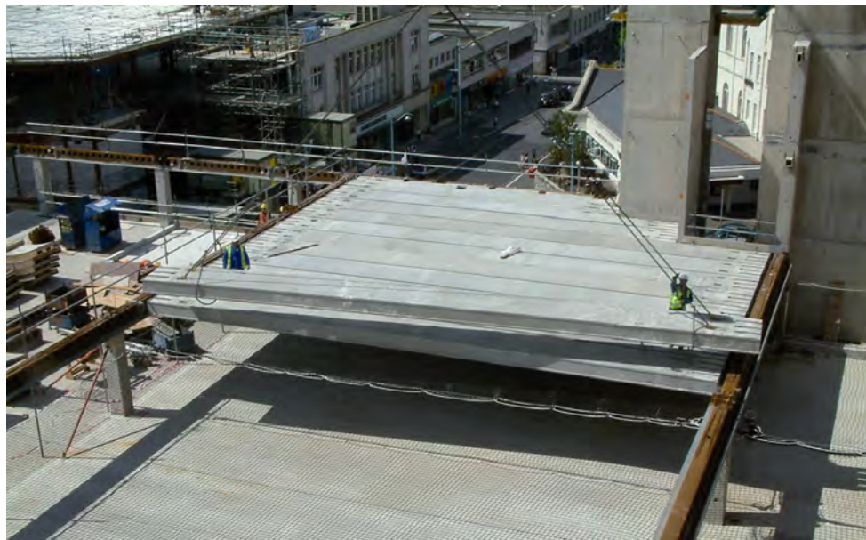
Rysunek 5.13 Prefabrykowane płyty betonowe o dużej rozpiętości umieszczane na konstrukcji stalowej
