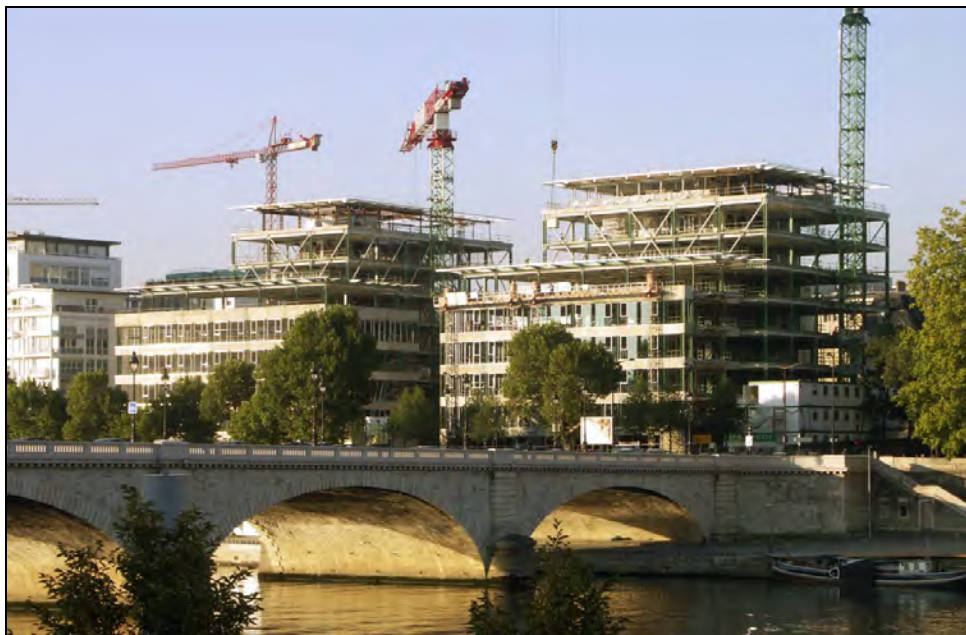
Rysunek 3.3 Budynki Le Sequana, Paryż, w trakcie budowy
