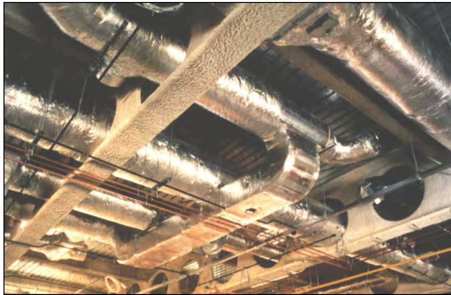
Rysunek 1.3 Instalacje zintegrowane z ażurową belką stropową
