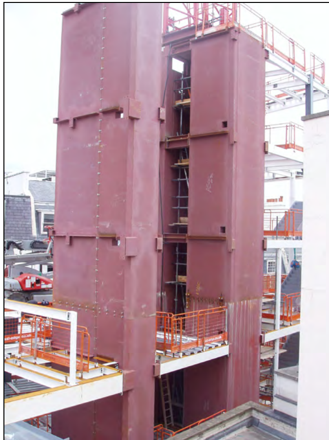
Rysunek 4.4 Rdzeń stalowo-zespólny przyspiesza proces budowy
