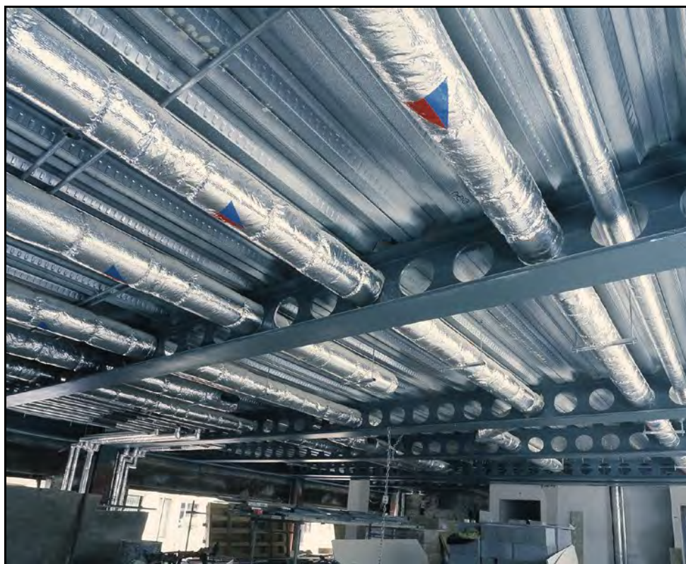
Rysunek 5.8 Ażurowe belki drugorzędne o dużej rozpiętości z regularnymi okrągłymi otworami
