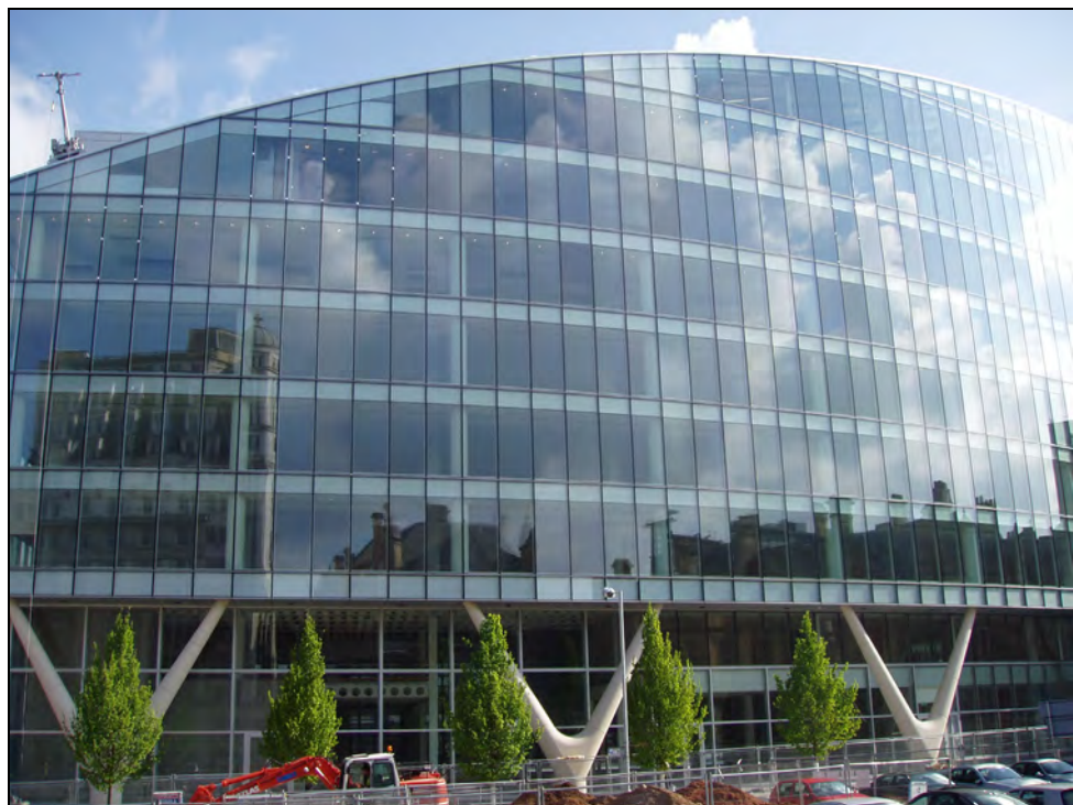
Rysunek 6.4 Potrójnie szklona ściana wielokondygnacyjnego budynku handlowego
