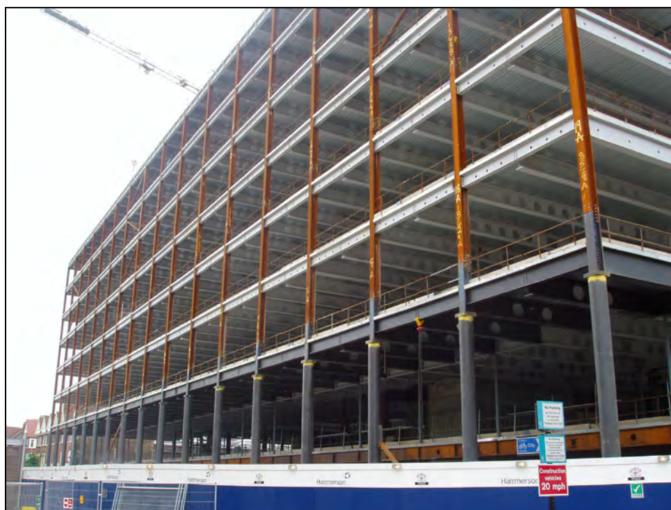
Rysunek 3.2 Widok ażurowych belek o dużej rozpiętości w budynku Bishop's Square
