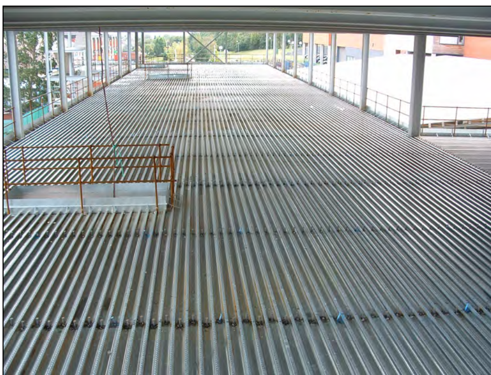
Rysunek 4.11 Stropy zespolone stanowią bezpieczną platformę roboczą podczas budowy
