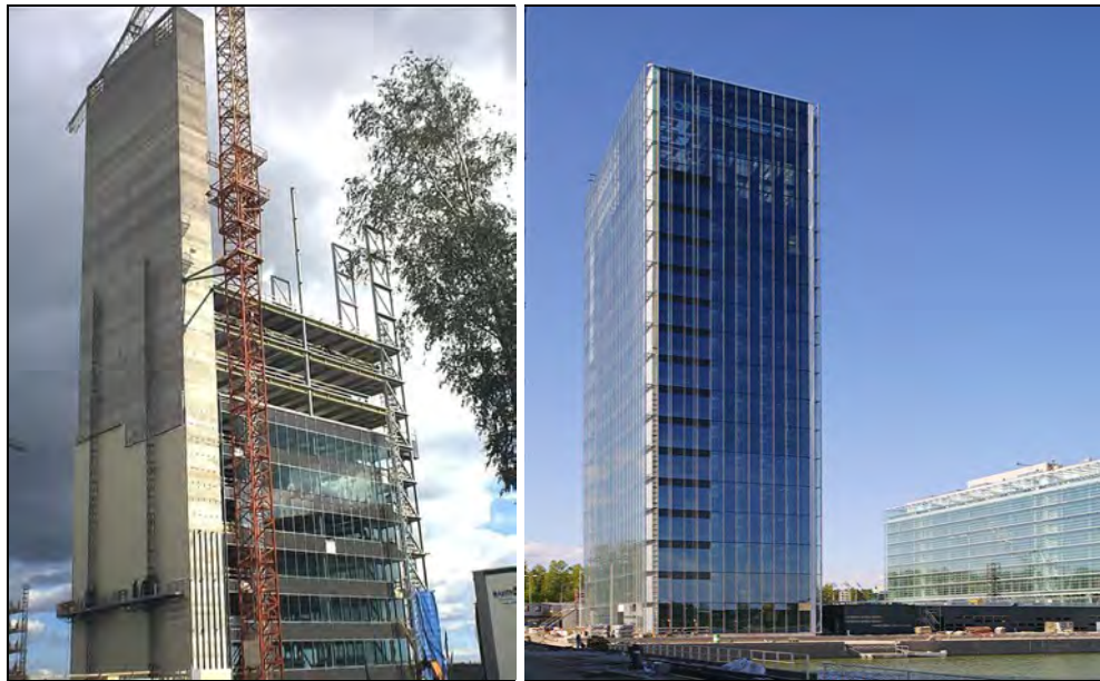
Rysunek 3.8 Budynek firmy Kone w trakcie i po zakończeniu budowy
