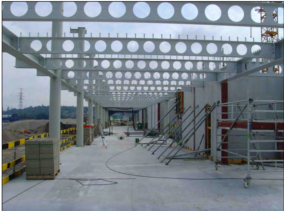
Rysunek 3.10 Budynek AM podczas prac budowlanych z pokazanymi belkami ażurowymi
