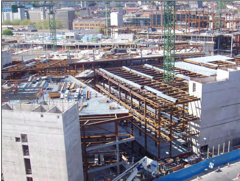
Rysunek 2.1 Szybki montaż konstrukcji stalowej oraz blach stalowych przyspiesza proces budowlany
