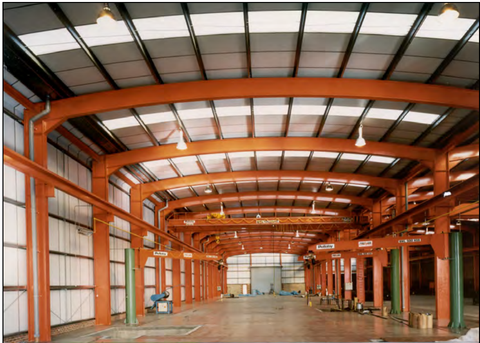
Rysunek 3.22 Belki łukowe zastosowane w ramie portalowej
