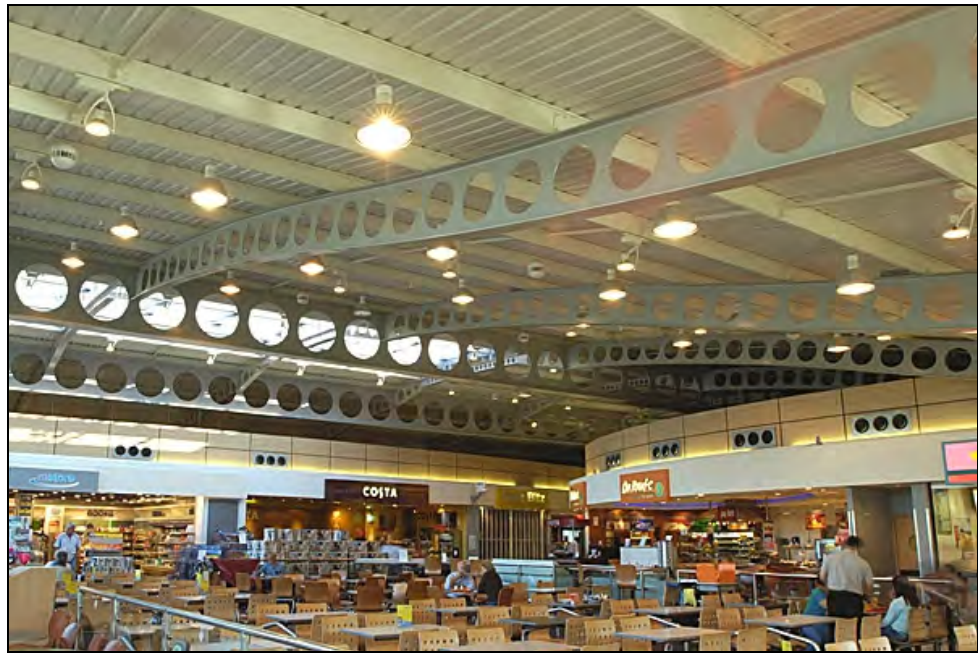
Rysunek 2.4 Belki ażurowe o podwójnej krzywiźnie i belki główne
