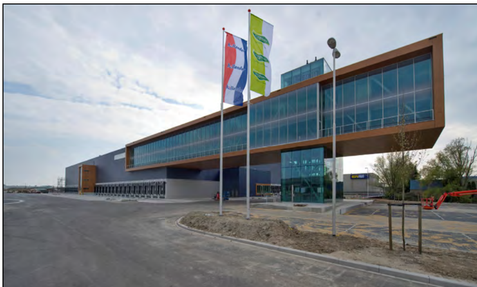
Rysunek 2.7 Centrum dystrybucyjne, Barendrecht, Holandia — konstrukcja biura z wspornikiem stężonym
