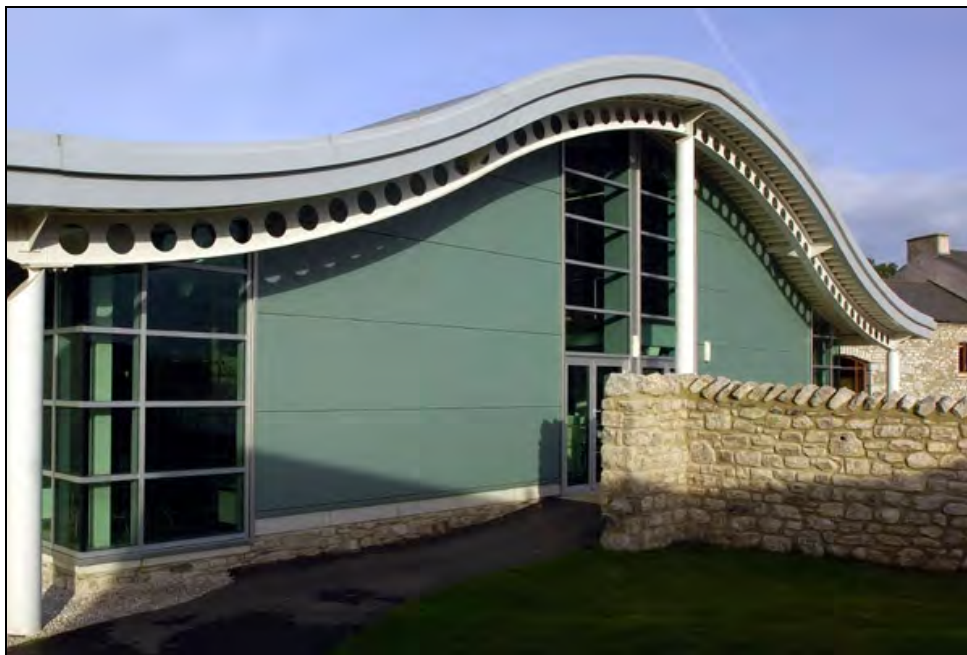
Rysunek 1.5 Łukowe belki ażurowe zastosowane w centrum rekreacji
