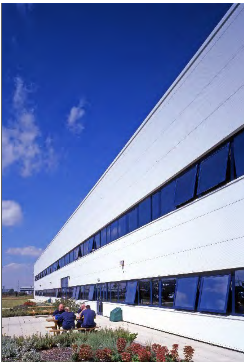
Rysunek 1.9 Poziome panele kompozytowe i okna wstęgowe
