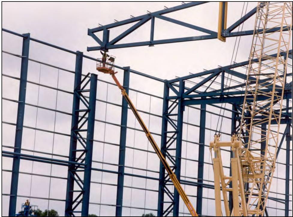
Rysunek 1.4 Kratownice dachowe i słupy złożone
