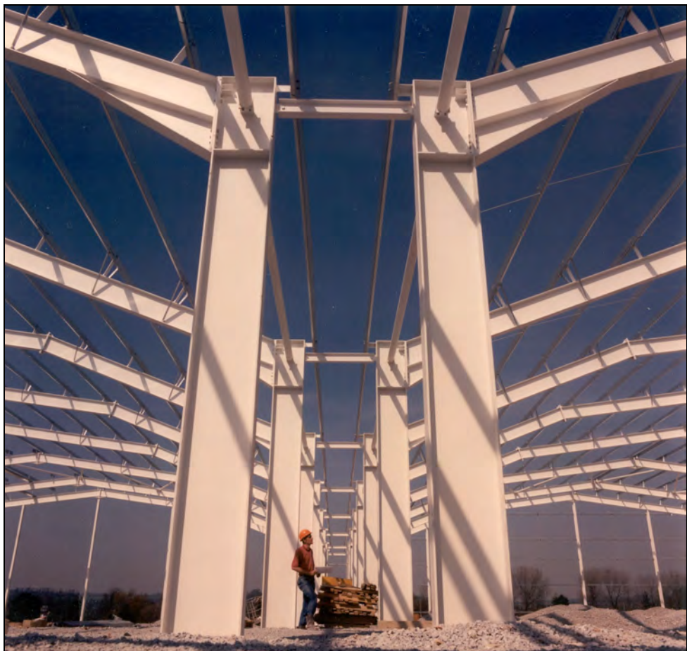
Rysunek 1.2 Wielonawowa konstrukcja ramy portalowej
