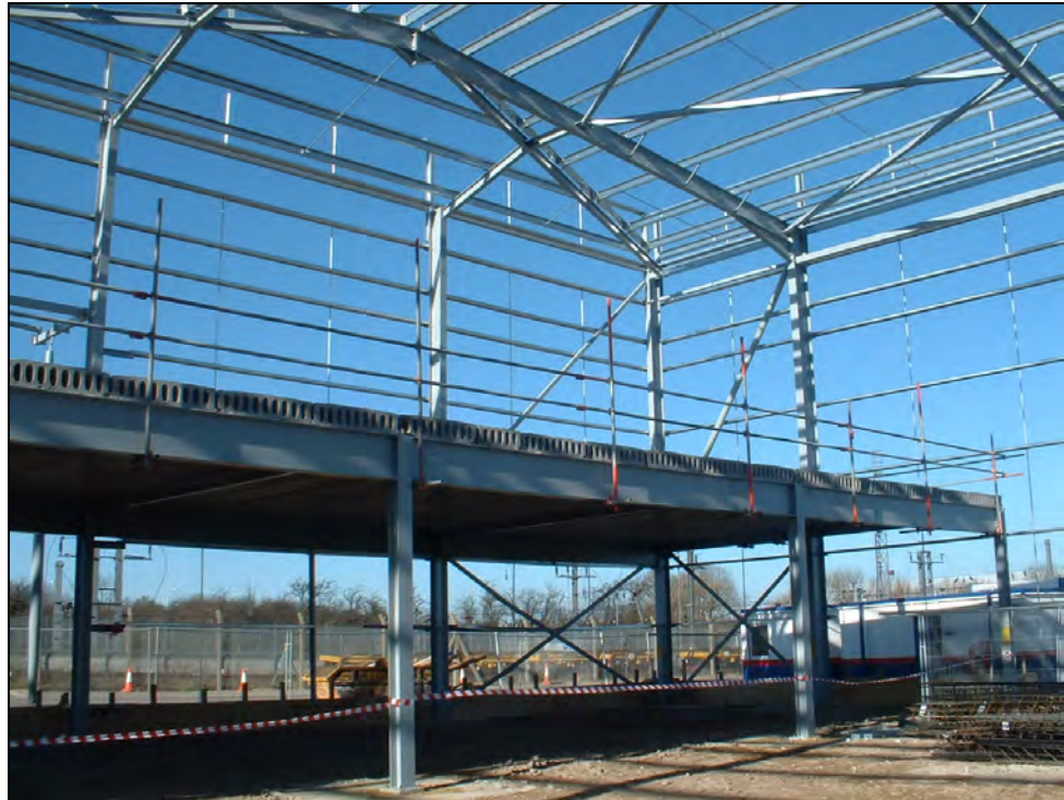
Rysunek 3.17 Rama portalowa ze stropem pośrednim
