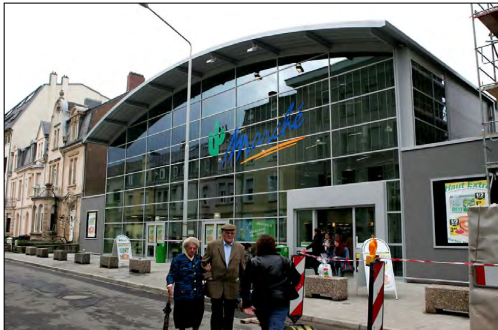
Rysunek 2.2 Supermarket w mieście Esch w Luksemburgu — zastosowanie łukowych belek ażurowych
