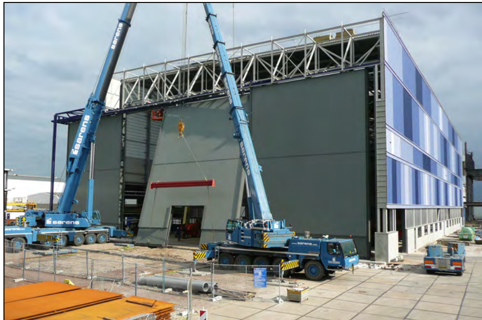
Rysunek 2.6 Montaż drzwi w budynku firmy Hollandia w mieście Krimpen aan den IJssel
