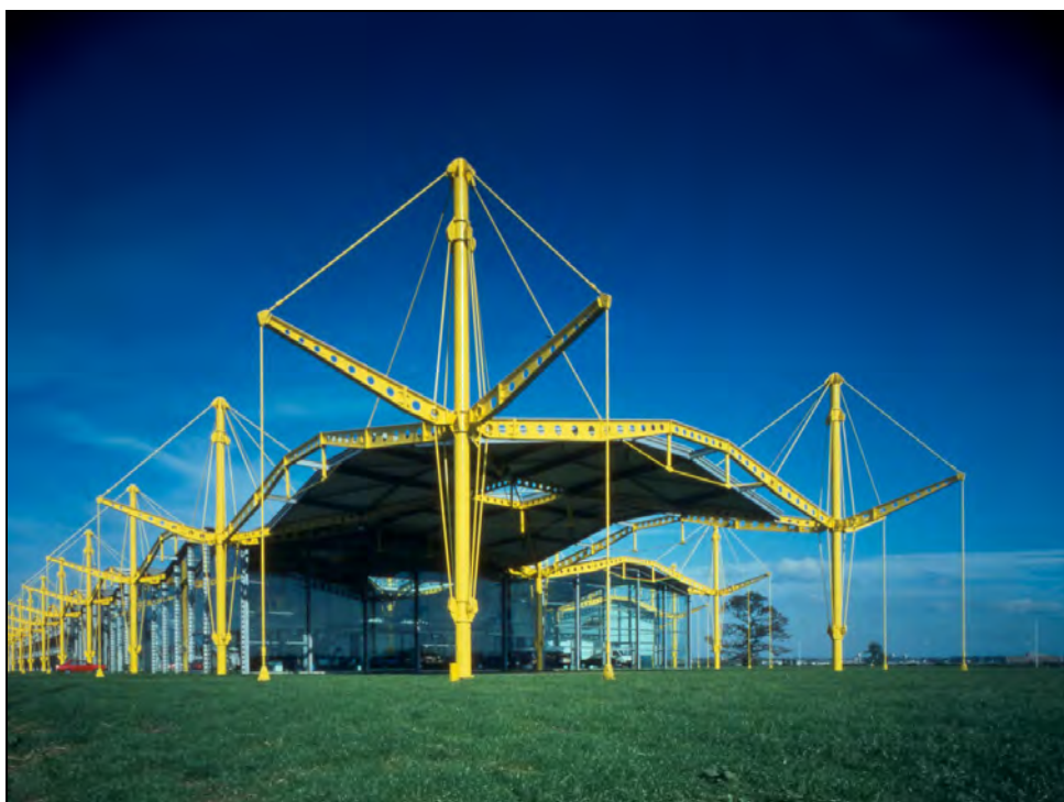
Rysunek 1.6 Konstrukcja zewnętrzna podpierająca budynek jednokondygnacyjny
