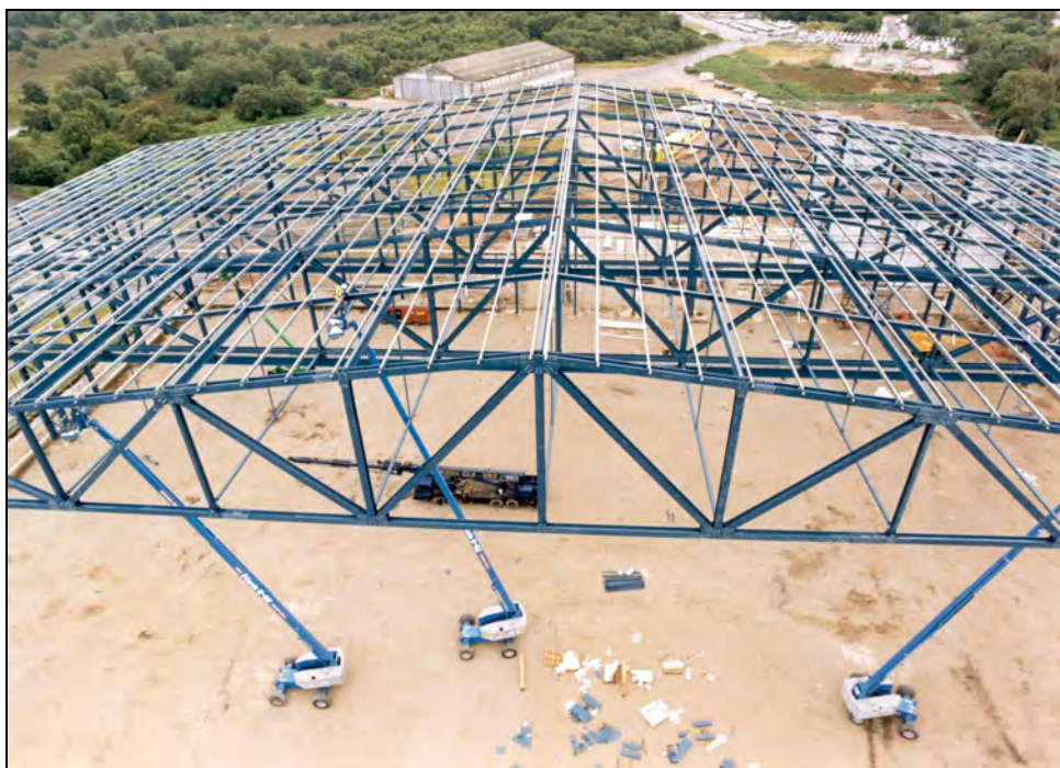
Rysunek 4.3 Kratownica wykonana z kształtowników walcowanych
