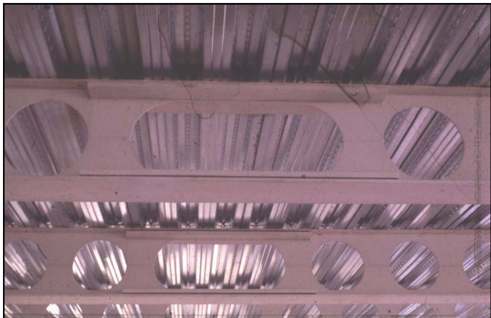
Figura 4.13 Aperturas alargadas con rigidizadores horizontales
