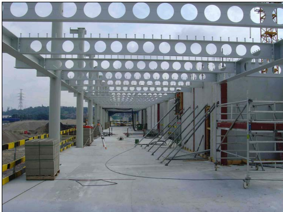
Figura 3.10 El edificio de AM durante la fase de construcción donde se pueden ver las vigas alveolares
