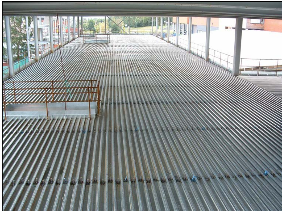
Figura 4.11 Los forjados colaborantes ofrecen una plataforma de trabajo segura durante la fase de construcción
