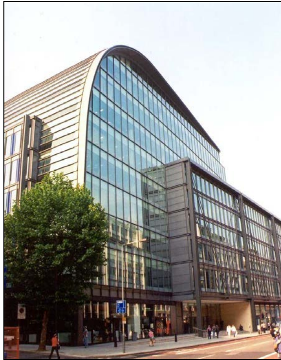
Figura 1.1 Edificio comercial moderno en acero
