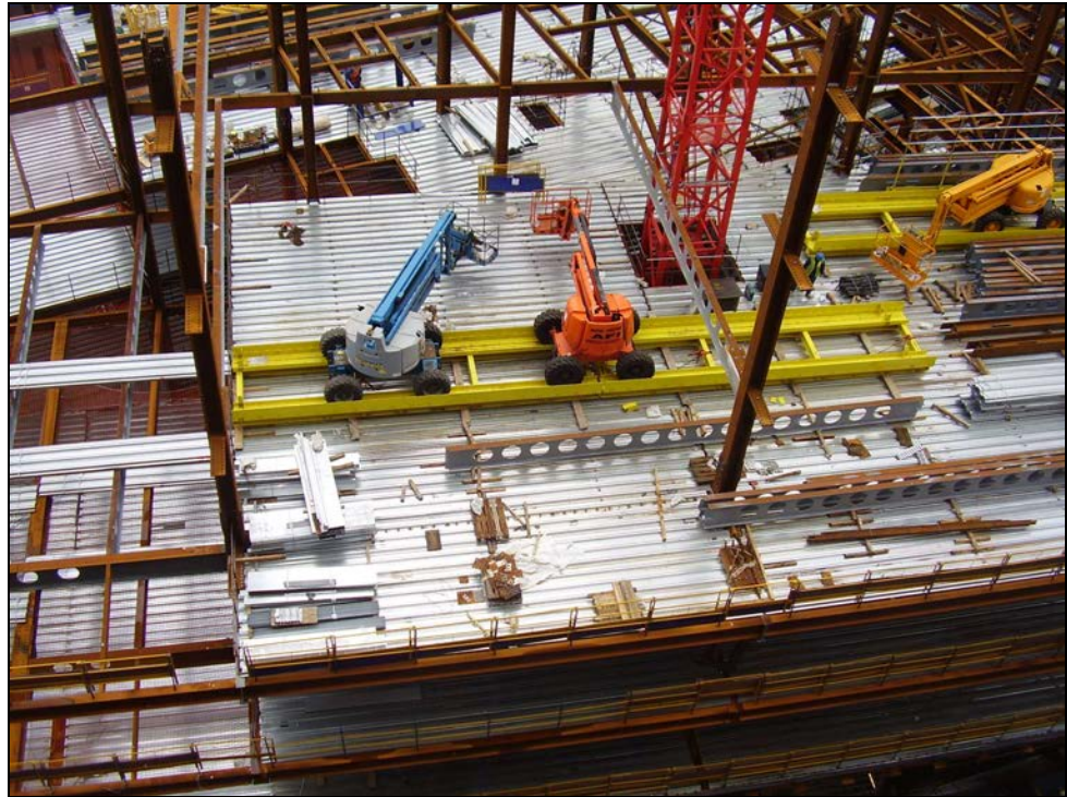
Figura 2.2 La instalación rápida y segura de la estructura y el forjado de acero desde una plataforma de montaje móvil acelera el proceso de construcción
