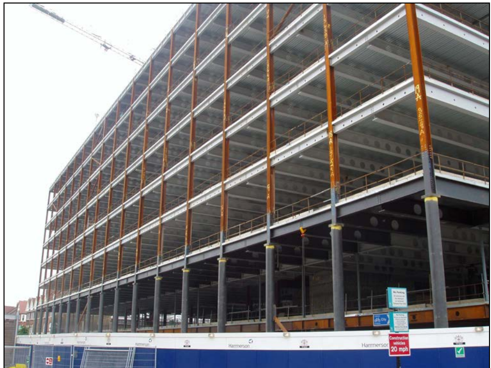
Figura 3.2 Vista de las vigas alveolares de gran luz en el proyecto de Bishop's Square
