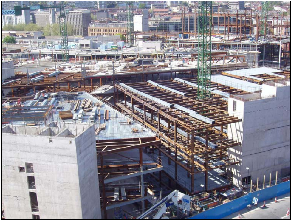
Figura 2.1 Instalación rápida de la estructura y forjado de acero acelera el proceso de construcción
