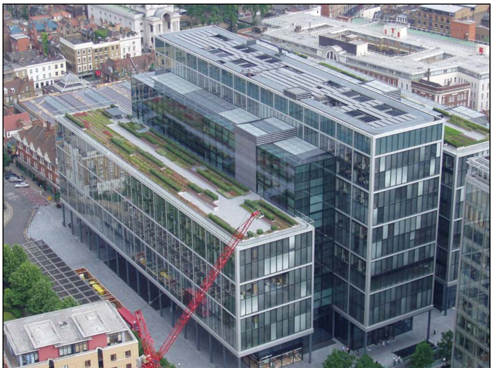
Figura 1.6 Cubierta “verde” y paneles fotovoltaicos en un edificio de oficinas en el centro de la ciudad
