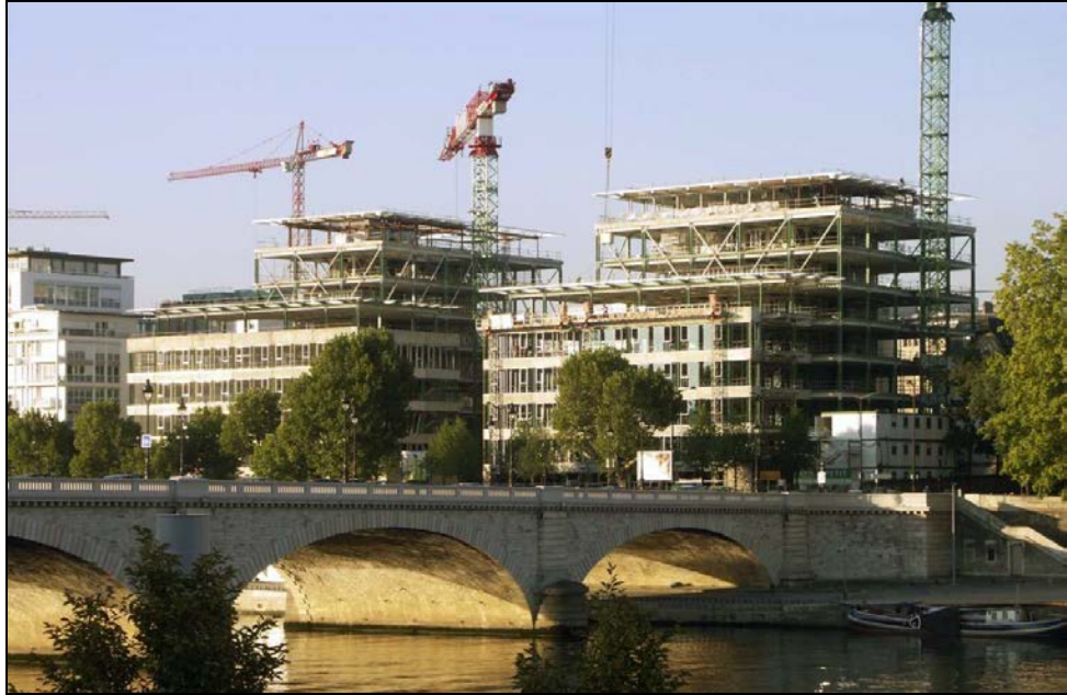
Figura 3.3 Los edificios Le Seguana, en París, durante la fase de construcción
