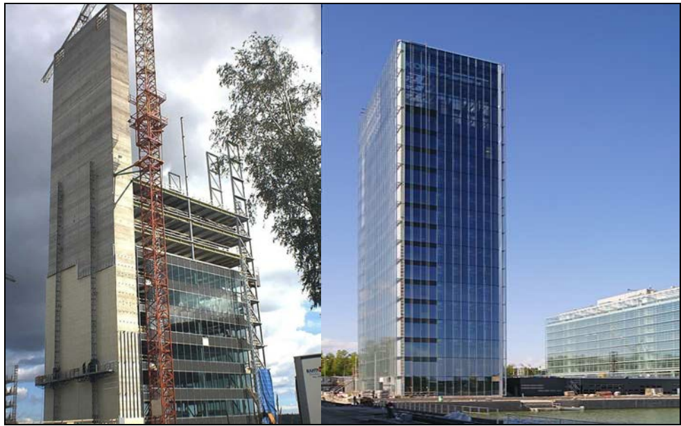
Figura 3.8 El edificio Kone durante la fase de construcción y después de terminado
