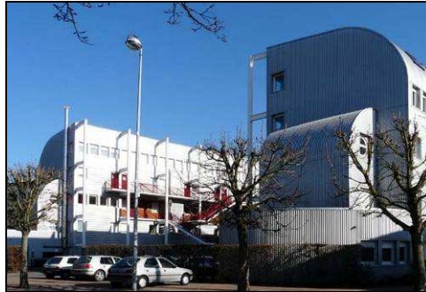
Cerramientos de acero – Montargis (Francia)
