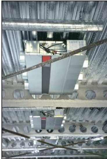
Figura 6.10 Vigas alveolares e integración de servicios
