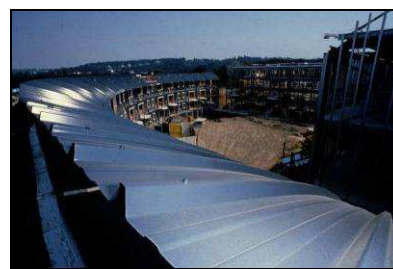
Tejado inclinado instalado
