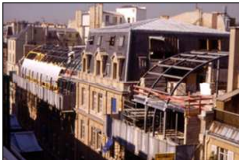
Figura 2.4 Ampliación en altura de un edificio
