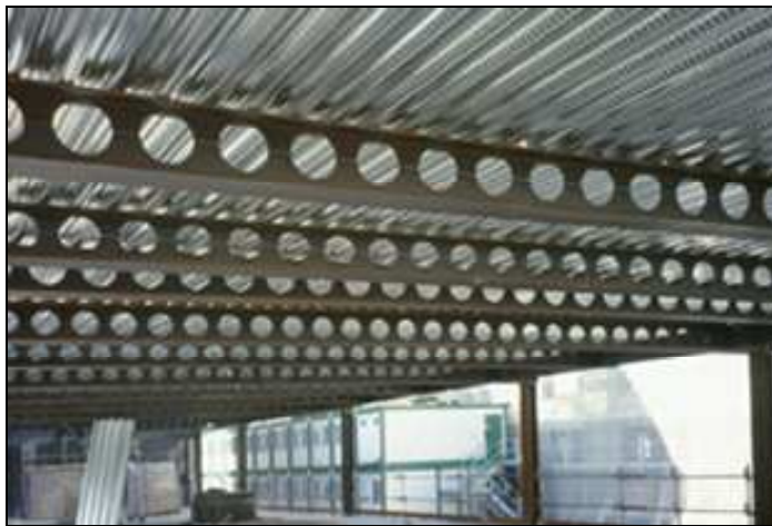
Figura 4.5 Vigas alveolares mixtas con chapa de acero
