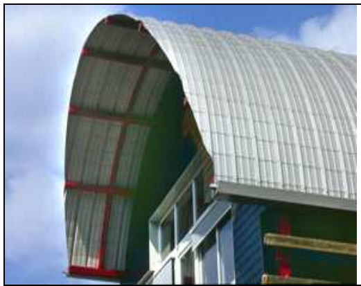
Figura 5.15 Cubierta curva con chapa de acero galvanizado
