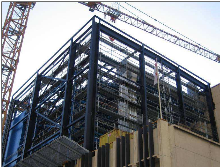
Figura 2.3 Edificio industrial de varias plantas durante su construcción en Mónaco
