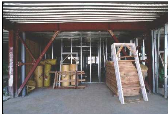
Figura 6.8 Suministros in situ con instalación de placas de pladur – Particiones y techos
