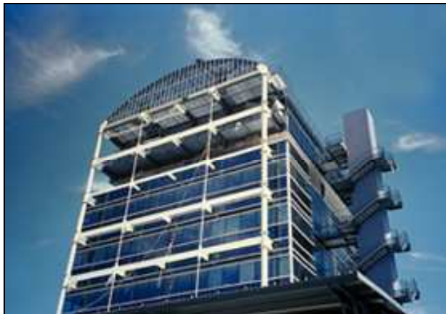
Figura 4.3 Disposición estructural con tirantes
