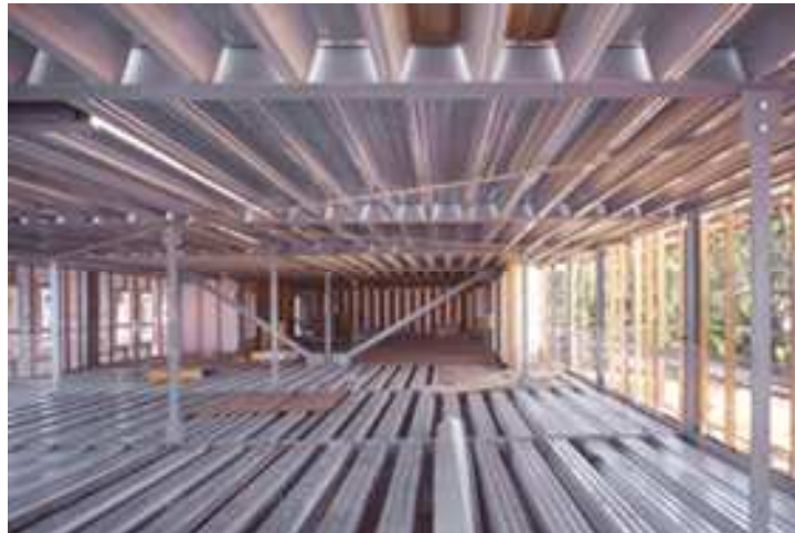
Figura 4.18 Foto de un forjado seco
