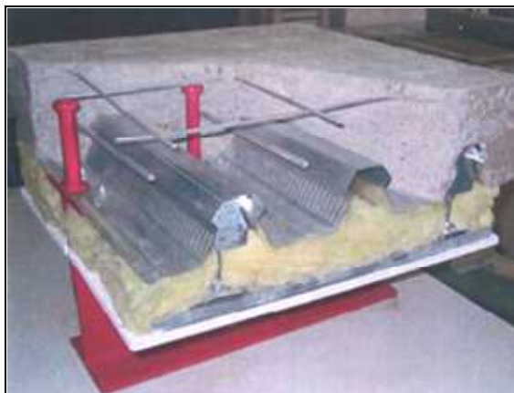
Figura 4.19 Losa mixta con aislamiento térmico
