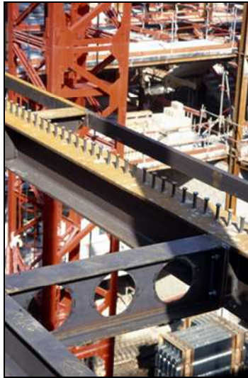
Figura 4.4 Viga mixta con conectores soldados en fase de construcción
