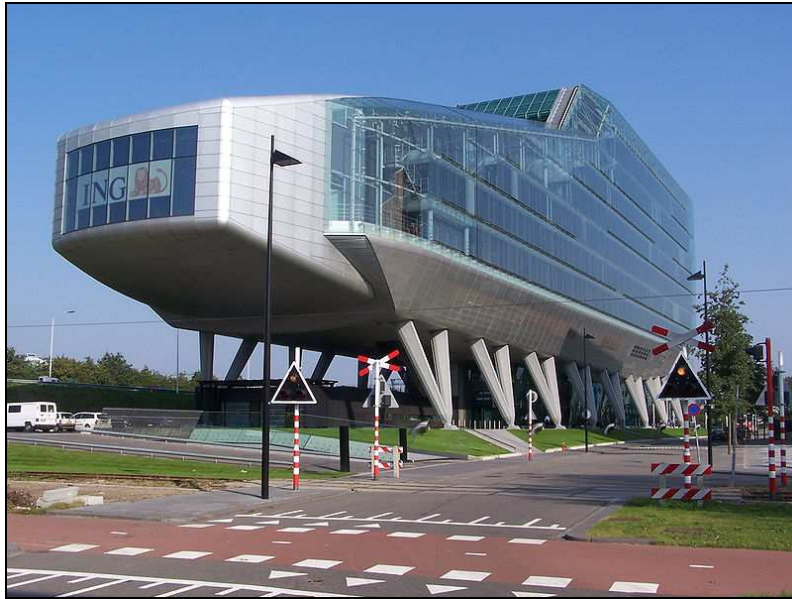
Figura 2.2 Oficina Central de ING Bank en Ámsterdam
