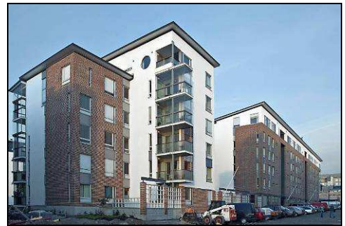
Escayola en muros de carga – Helsinki (Finlandia)
