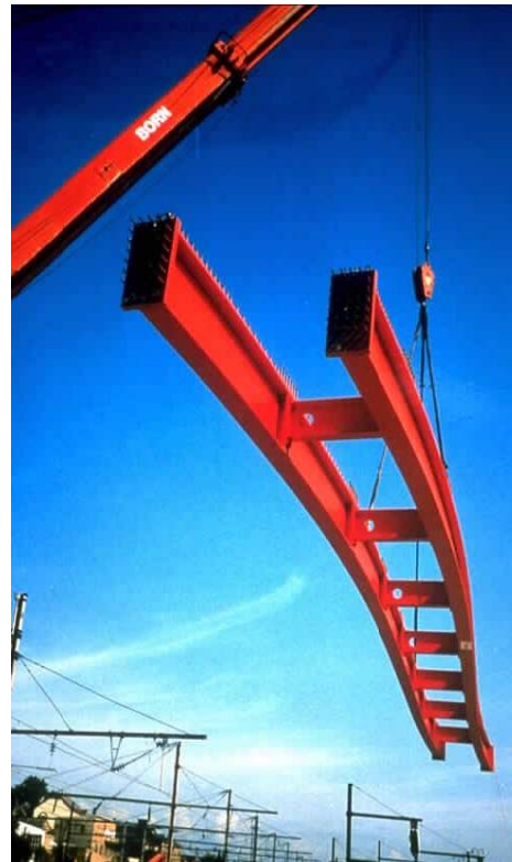
Abbildung 14-1: Überhöhung von Stahlträgern, Endprodukt (Hechler, 2010)
