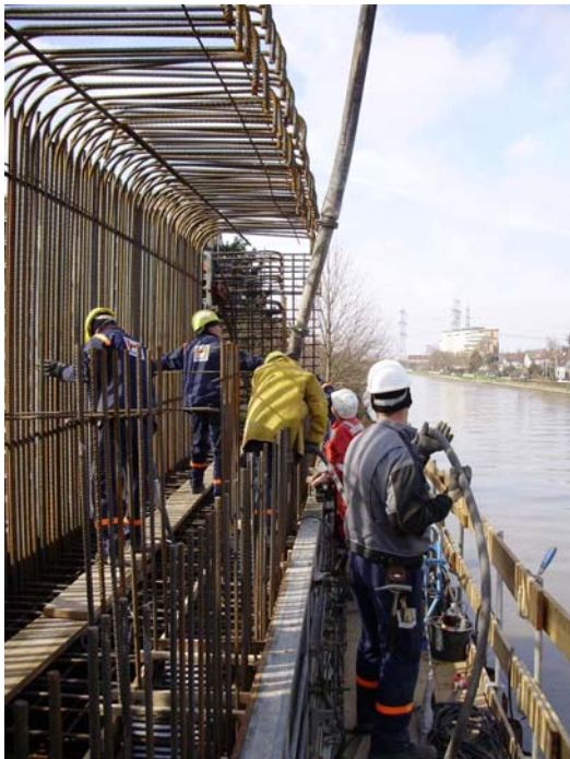
Abbildung 13-3: Verlegung der Bewehrung
