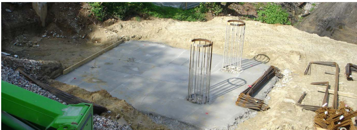
Abbildung 5-3: Betonpfähler der Entenpfuhler Brücke (Aachen) (Anschlussbewehrung)
