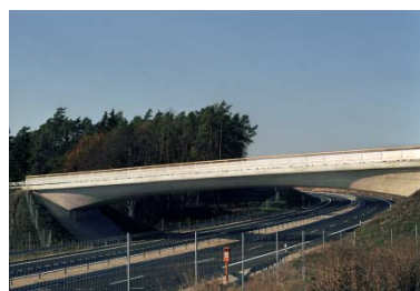
Abbildung 1-8: Rahmenbrücken mit geneigten Widerlagern
