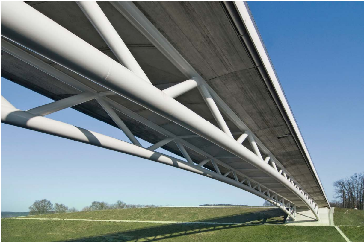
Abbildung 1-2: Verbundbrücke mit integralen Widerlagern von SSF, A73 (München)
