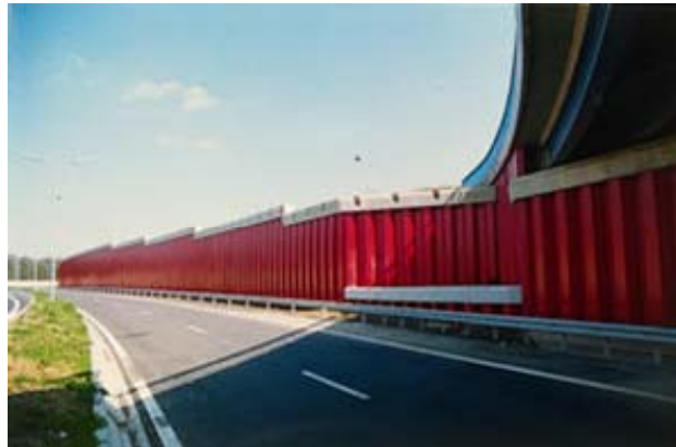
Abbildung 9-6: Soleuvre-Brücke, Südautobahn, Luxemburg, (herkömmliche Brücke) (ArcelorMittal Long Commercial, 2003)
