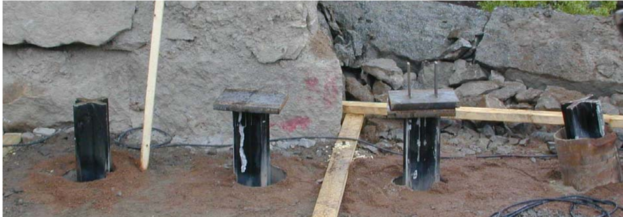
Abbildung 5-2: X-Pfähle für die Leduån Brücke in Schweden, umgeben von lockerem Sand
