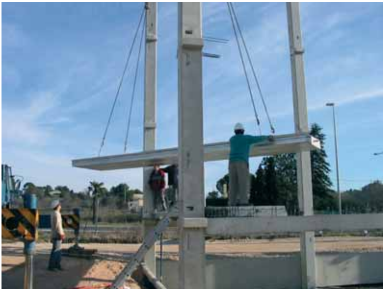
Colocación de un suelo prefabricado
