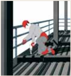
Fijación y unión de la chapa de forjado
