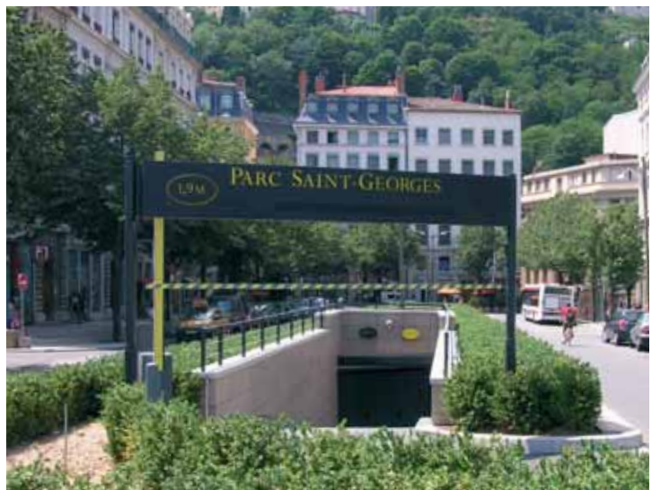
Foto superior: Aparcamiento Lazare Goujon , Villeurbanne (Francia) ARQUITECTOS: Demichel & Dordilly
