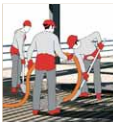
Echando el hormigón
