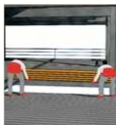
Colocación de las chapas de forjado
