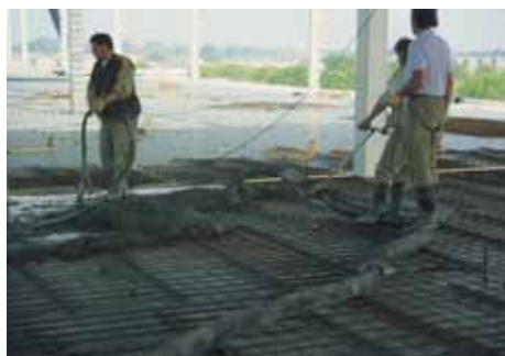
Cubrición de la losa con hormigón en la obra
