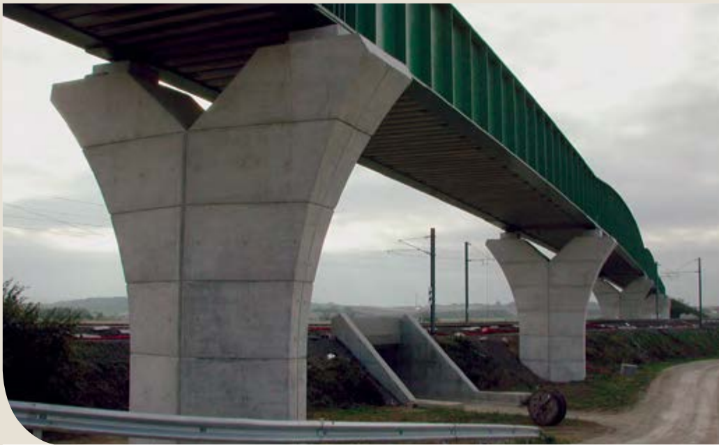
LGV Est bridge, France
