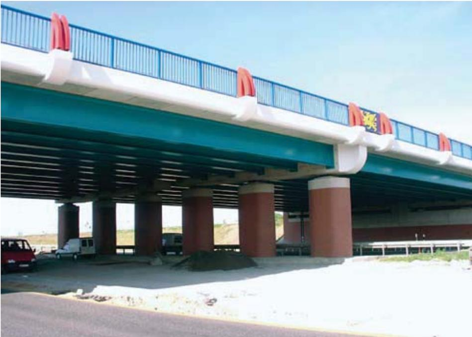
**Verbundbrücke mit Betonquerträgern bei Bentwisch, Deutschland. – Form, Farbe und Detail prägen das Gesamtbild.**
