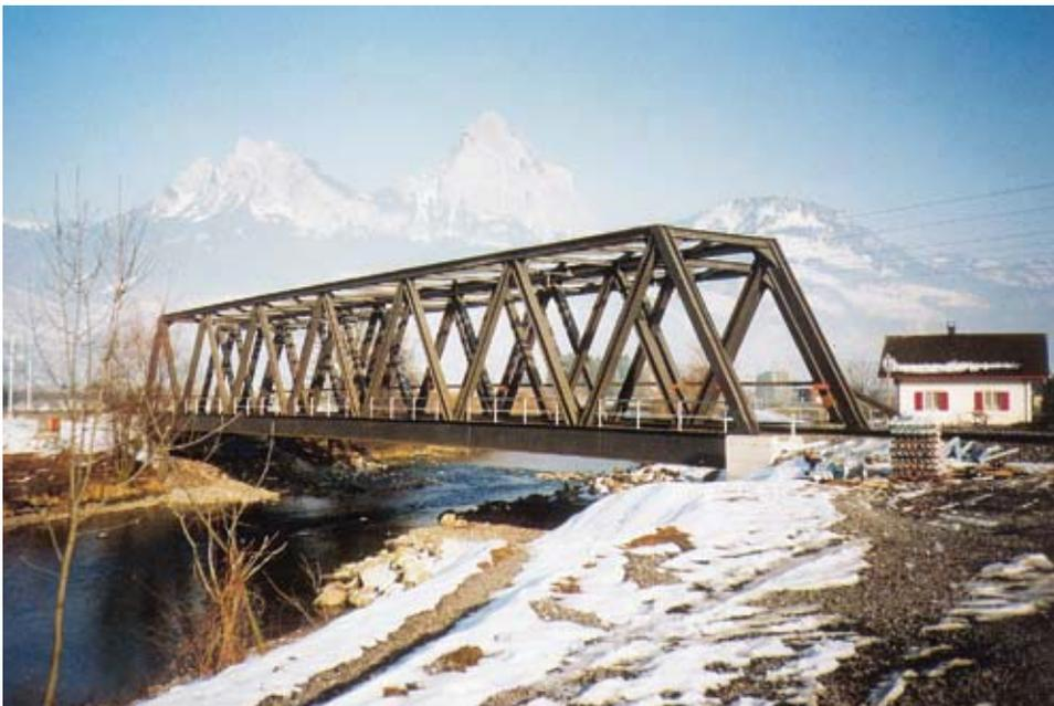
Ersatzneubau einer Muotabrücke an der Gotthardlinie, Schweiz. – Die Diagonalstäbe und Obergurte bestehen aus Walzträgern der Reihen HD und HE. Als Stahl wird wegen der guten Schweiß Eigenschaften eine thermomechanisch gewalzte Güte eingesetzt.
