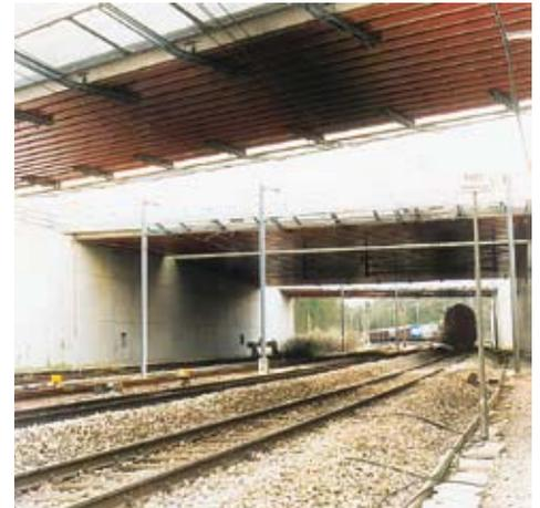
**WIB – Überbau einer verkehrsreichen Eisenbahnstrecke.- Dank einer hochwertigen Oberflächenbehandlung sind die Unterflansche dauerhaft geschützt.**
