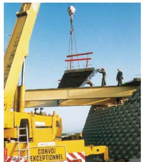
Fahrbahnplatte aus Stahlbetonfertigteilen. – Montage eines Stahlbetonfertigteils
