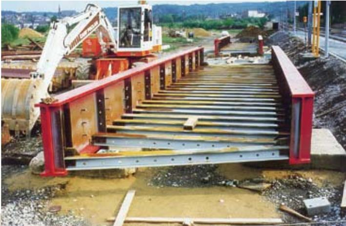
Eisenbahnbrücke über die Emile Mark Straße in Differdingen, Luxemburg. – Der Austausch des alten Brückenüberbaus mit direkter Schienenauflagerung durch eine Fahrbahn mit Schotterbett führt zu einer starken Bauhöhenbeschränkung und der damit verbundenen Wahl von Trogquerschnitten. Das Bild zeigt die neben den Gleisen vormontierte Stahlkonstruktion vor dem Betonieren des Troges.
