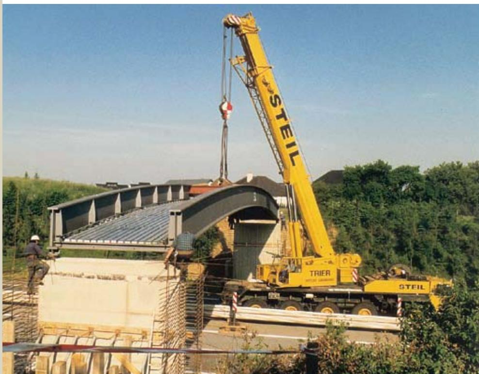
**Montage einer Fußgängerbrücke mit abgesenkter Gehwegplatte. – Das vormontierte Tragwerk mit der befestigten Trapezblechschalung wird von einem Autokran eingehoben.**
