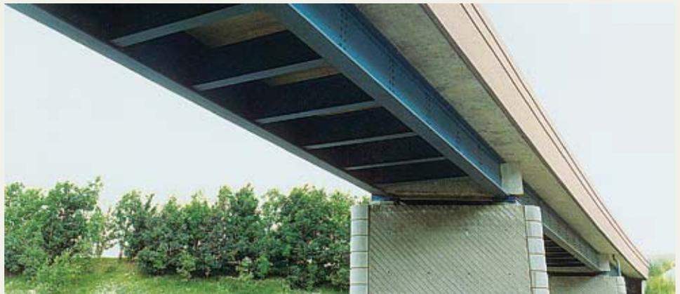
**Eisenbahnbrücke über die Autobahn A23 in Fretin, Frankreich. - Vierfeld-Verbundüberbau mit Stützweiten von 16,9 - 21,9 - 23,0 - 17,8 Metern. Die zwei durchlaufenden Hauptträger und die Querträger im Feld sind Walzträger; die Querträger über den Auflagern sind als Stahlbetonquerträger ausgeführt.**
