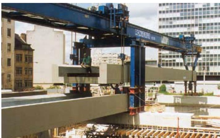
**Ausbau des Bahnhofs Brüssel - Süd für die Eurostar Züge.** – Schnelle Montage mit Hilfe einer Einschubvorrichtung der vorgefertigten Trogüberbauten aus vorgespannten einbetonierten Walzträgern.
