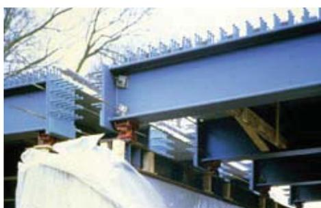
**Brücke in Schwedt, Deutschland. - Betonquerträger als Längsträgerstoß im Bauzustand**
