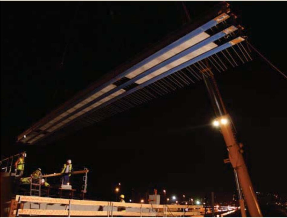
Straßenbrücke bei Sète-Frontignan, Frankreich. – Einhub eines WIB-Brückenelements über die Gleise der zu querenden Bahntrassen.
