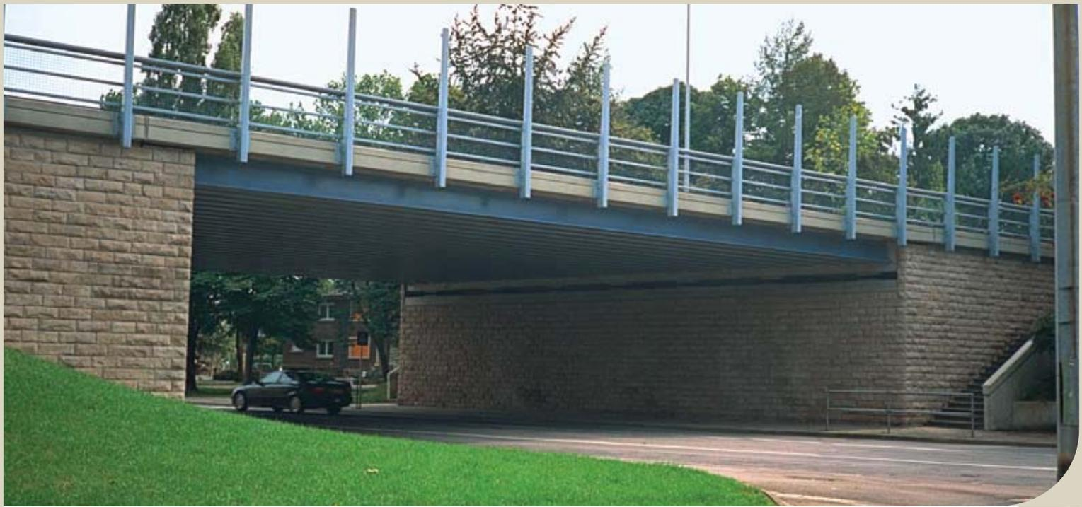
**WIB-Strassenbrücke in Esch-sur-Alzette, Luxemburg – Stützweite 19 m; Bauhöhe 0,65 m.**
