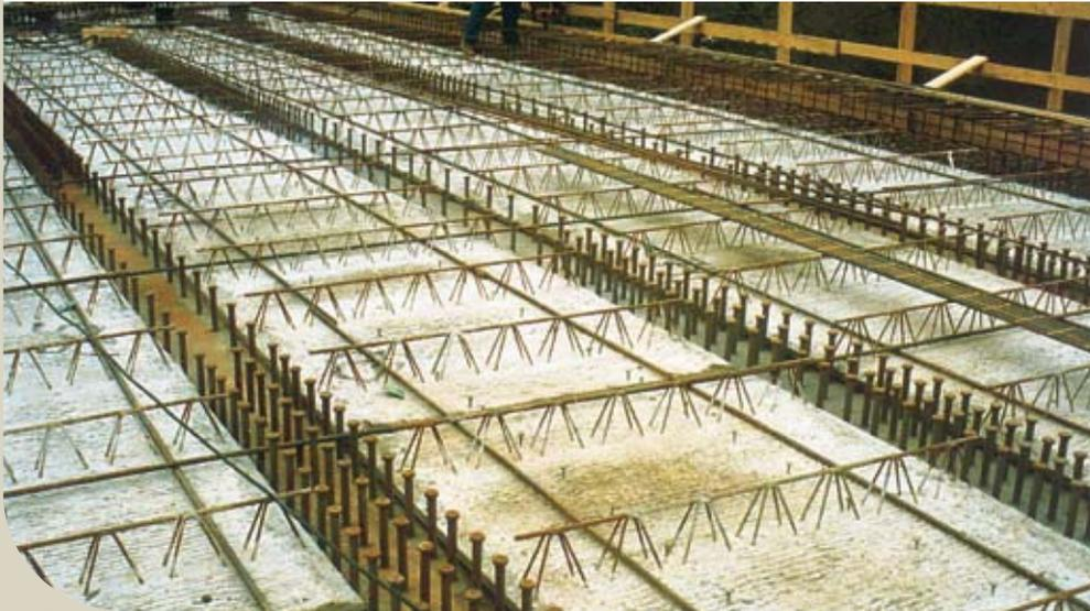
Gitterträgerbewehrte Betonfertigteileplatten einer Verbundbrücke.
