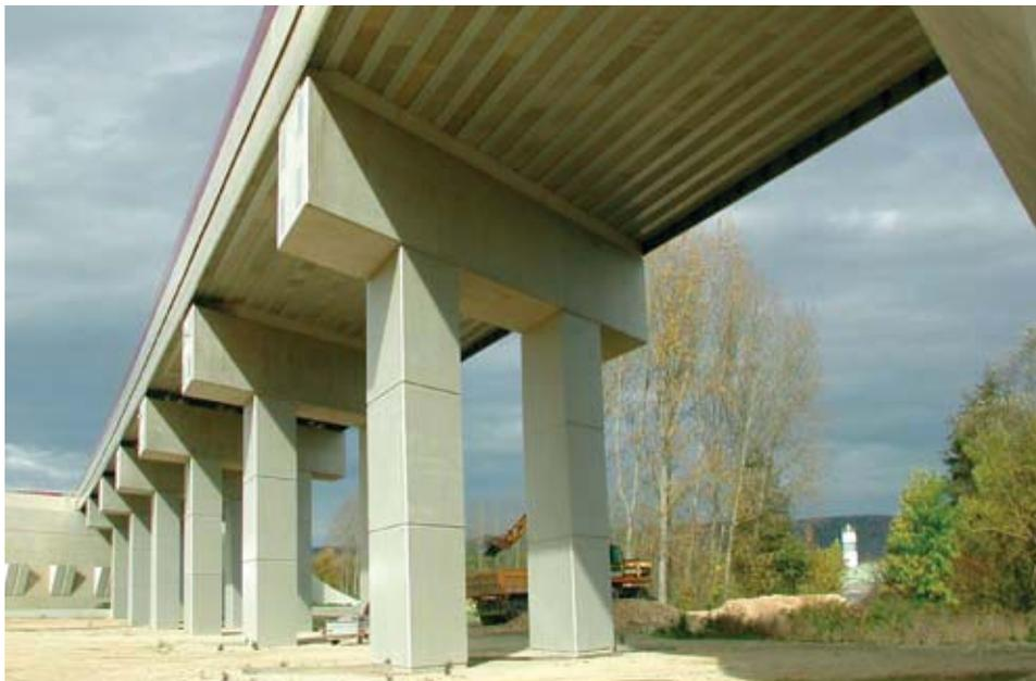
Mehrfeldrige WIB-Brücken als Vorlandbrücken zur Moselquerung der LGV Est Hochgeschwindigkeitsbahnstrecke, Frankreich.
