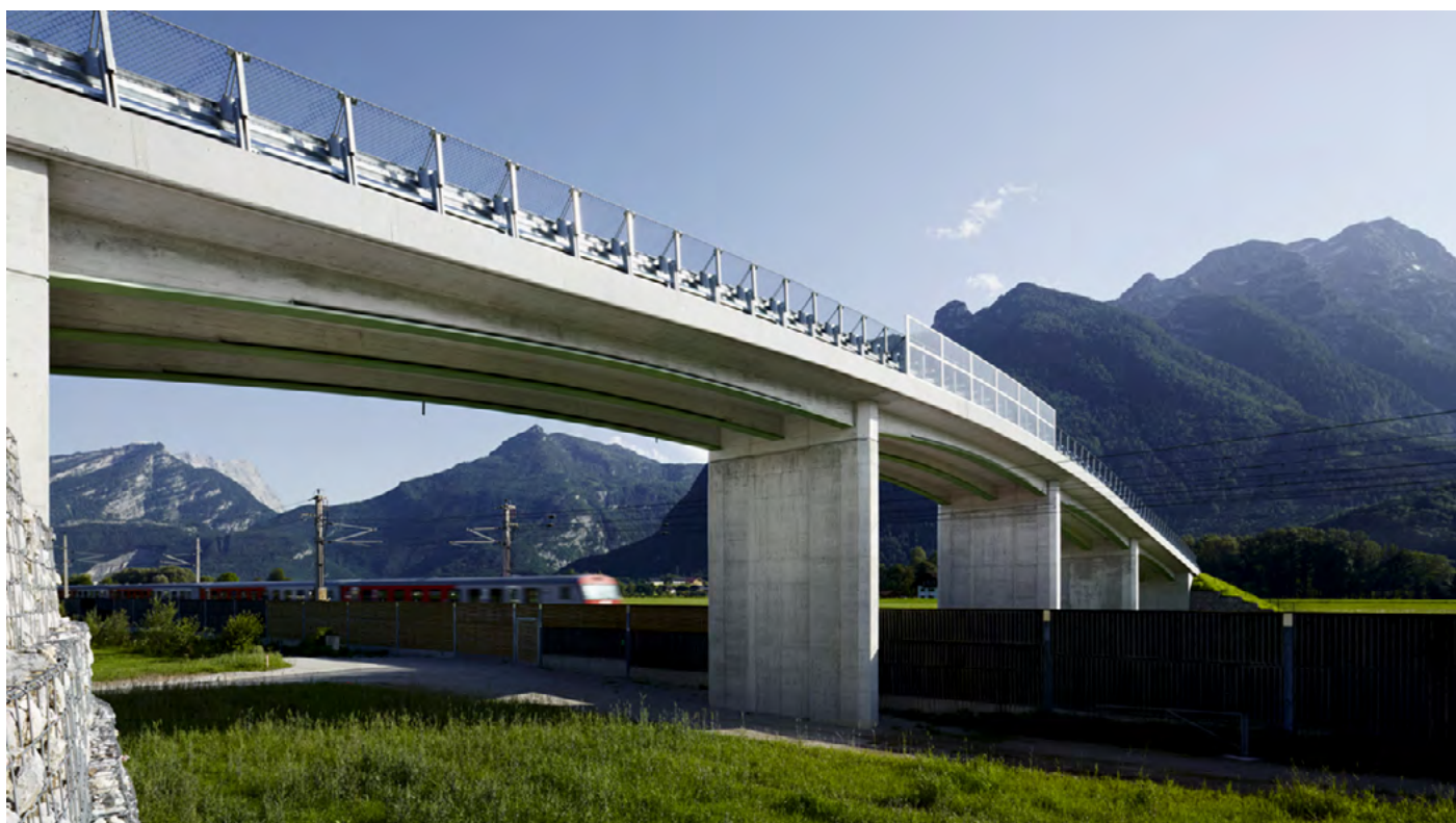
Passage supérieur sur la ligne ÖBB, Kratzerau, Autriche (©: SSF Ingenieure)
