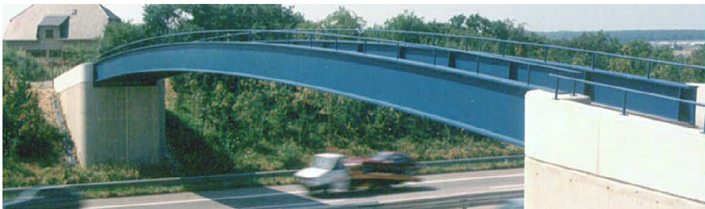
Pont sur l'A3 à Bettembourg, Luxembourg
