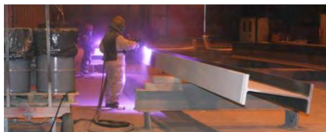
Application manuelle d'une couche de zinc vaporisé
