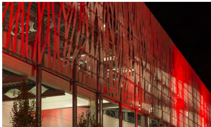
Parking Géric à Thionville, France
