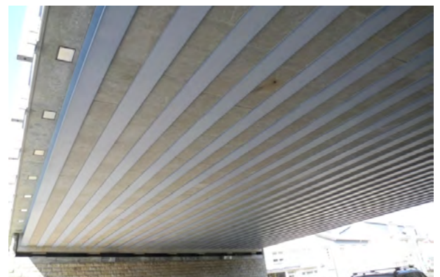
Pont à poutrelles enrobées pour l'accès de l'A4 à Esch-sur-Alzette, Luxembourg
