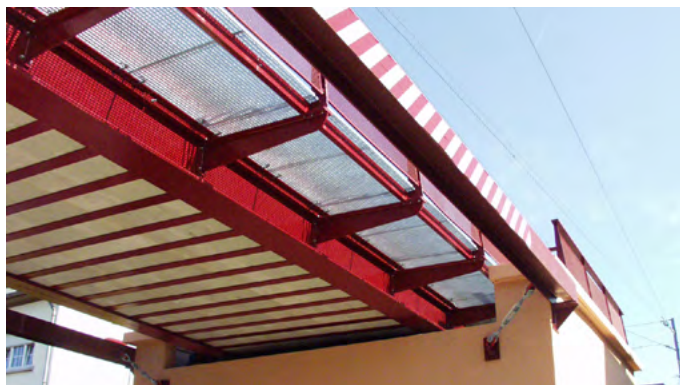
Ponts à poutres latérales à Dudelange, Luxembourg
