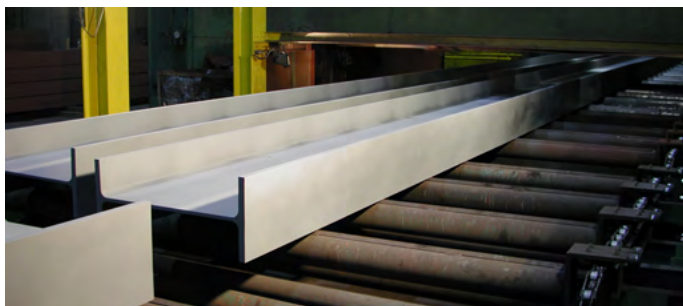
Grenaillage automatique aux nuances Sa 2.5 ou Sa 3.0 et application de primer
