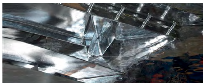
Galvanisation à chaud (collaboration avec partenaires de longue date à travers toute l'Europe)
