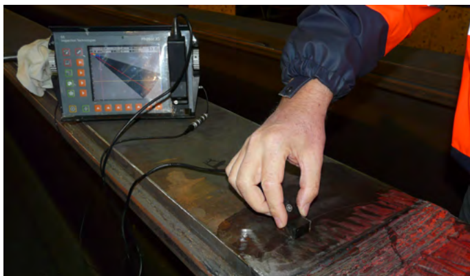
Essais non destructifs sur les détails soudés
