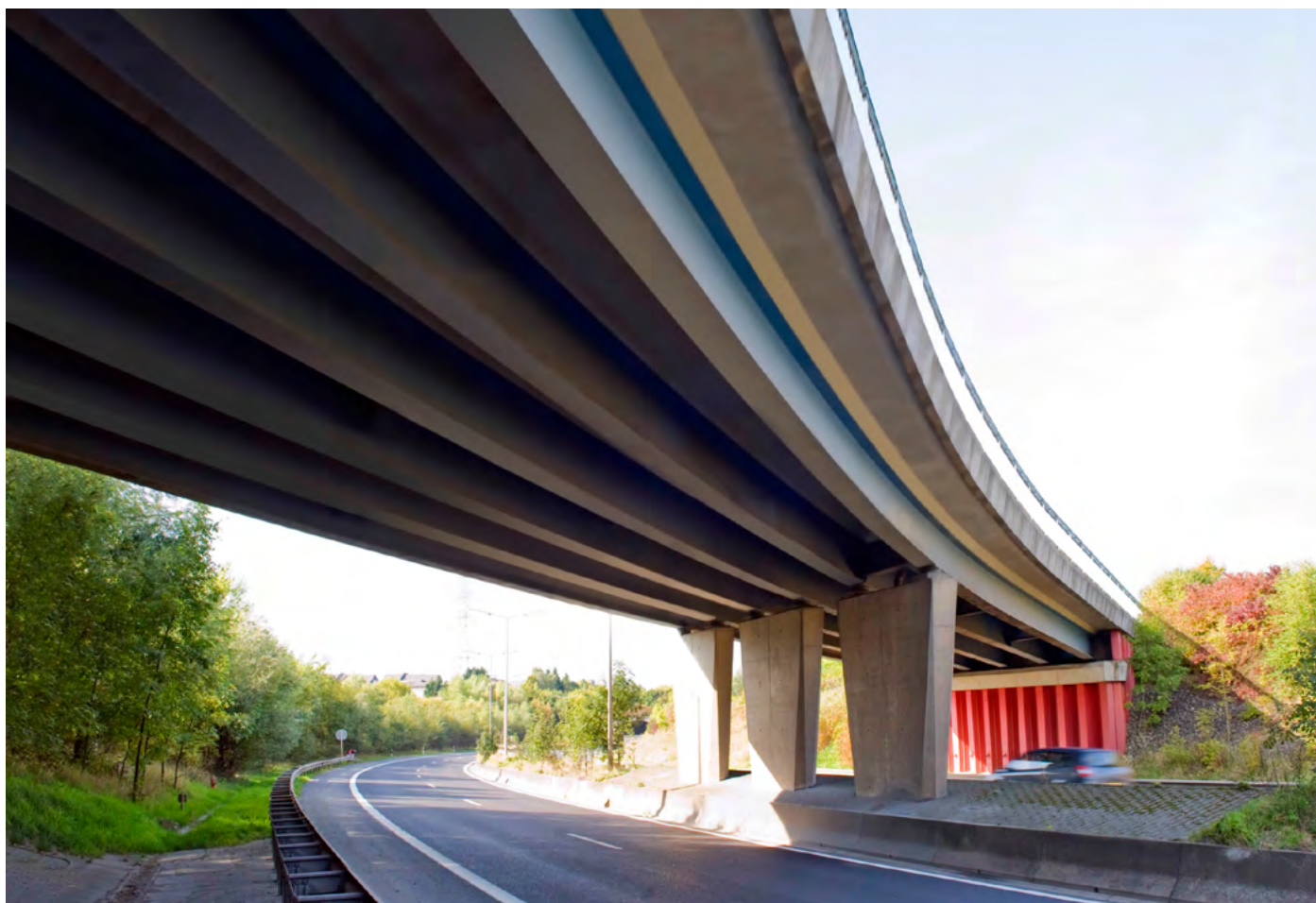
Pont-mixte en profilés laminés, Soleuvre, Luxembourg
