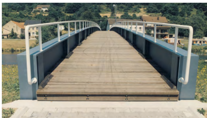
Passerelle à Sheinheim, Allemagne
