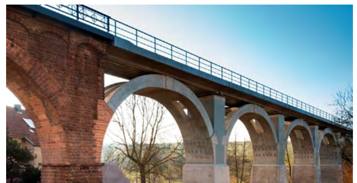
Viaduc Eiweiler, Saarland, Allemagne
