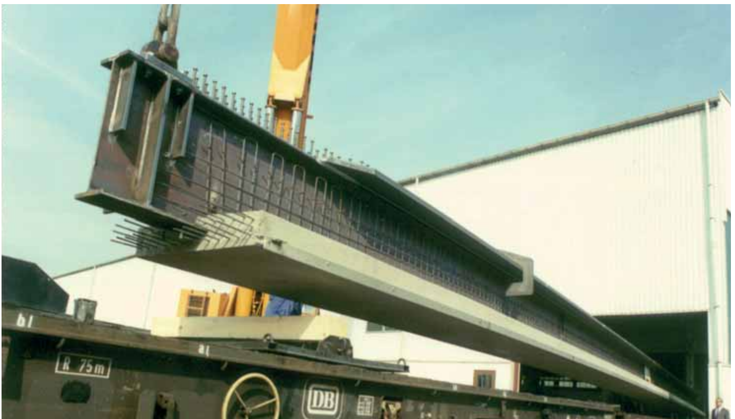
PreFlex-Träger für eine Brücke in Kerpen Horrem, Deutschland
