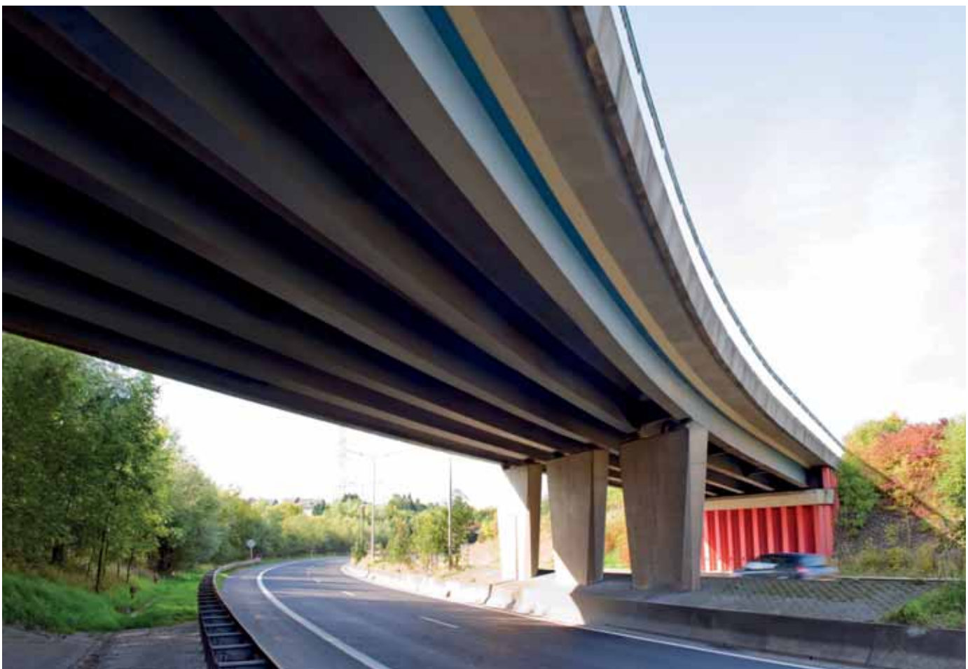
Mehrstegige Verbundbrücke mit Walzprofilen, Zolwer, Luxemburg
