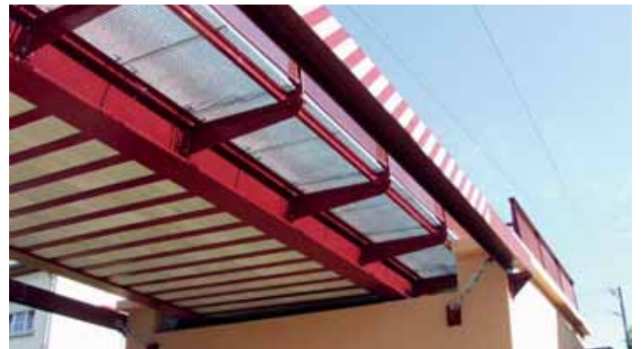
Trogbrücke in Düdelingen, Luxemburg
