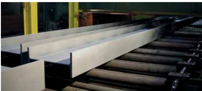
Automatisches Strahlen Reinheitsgrad Sa 2,5 oder 3 und Auftragen eines Shopprimers
