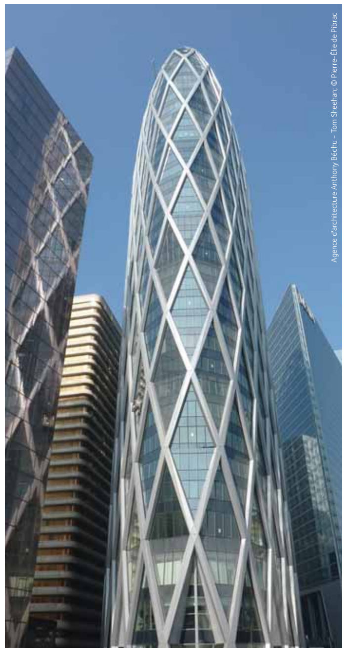
Büroturm D2 in Paris, Frankreich, ein herausragendes Beispiel für Hochhäuser in Stahlrahmenbauweise
