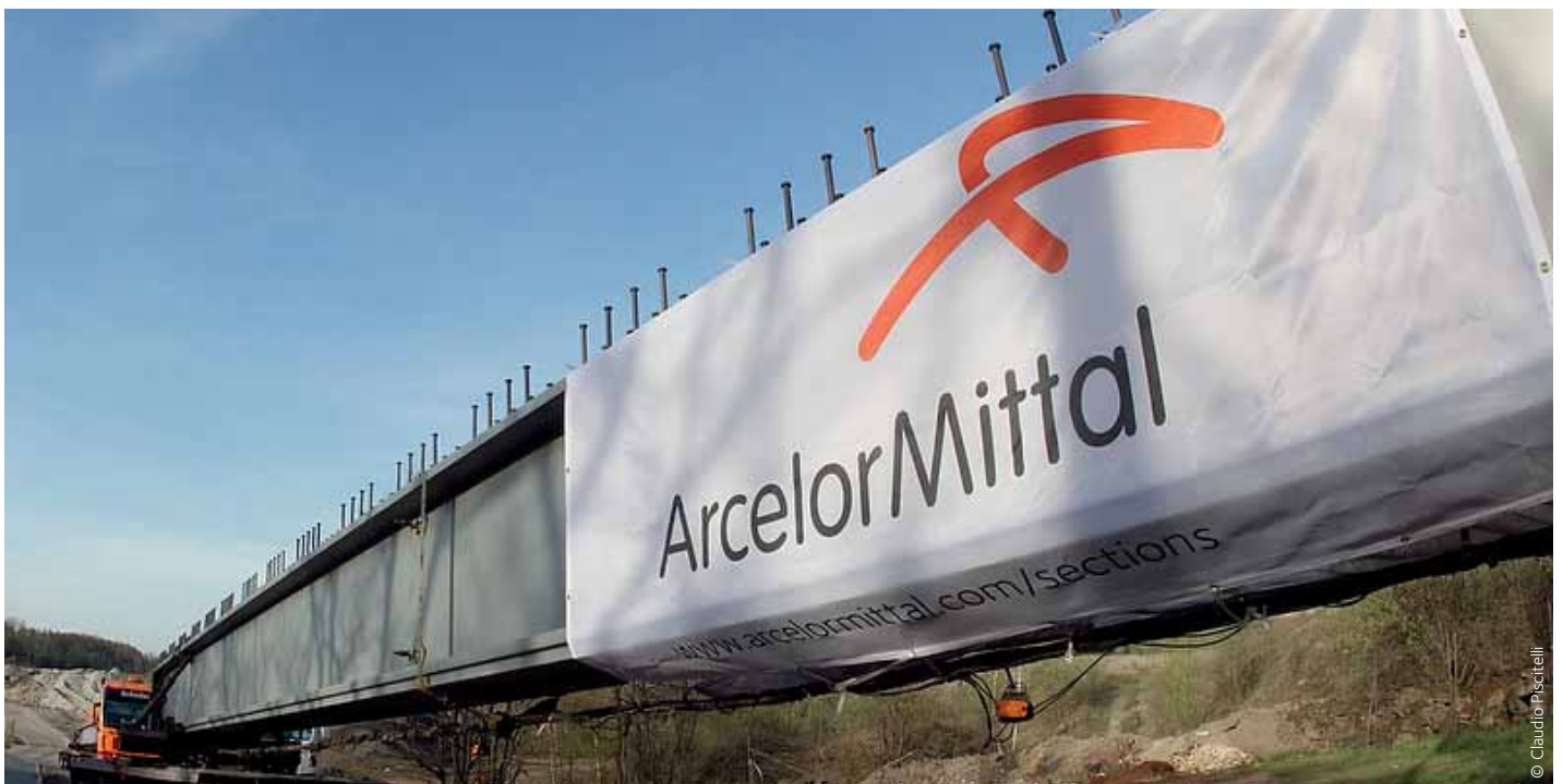
Lieferung von 41,7 m langen baustellenfertigen Trägern für eine Brücke im Zuge der B6n in Bernburg, Deutschland
