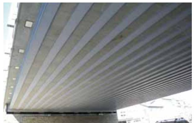
WIB-Brücke für den A4-Zubringer in Esch-sur-Alzette, Luxemburg
