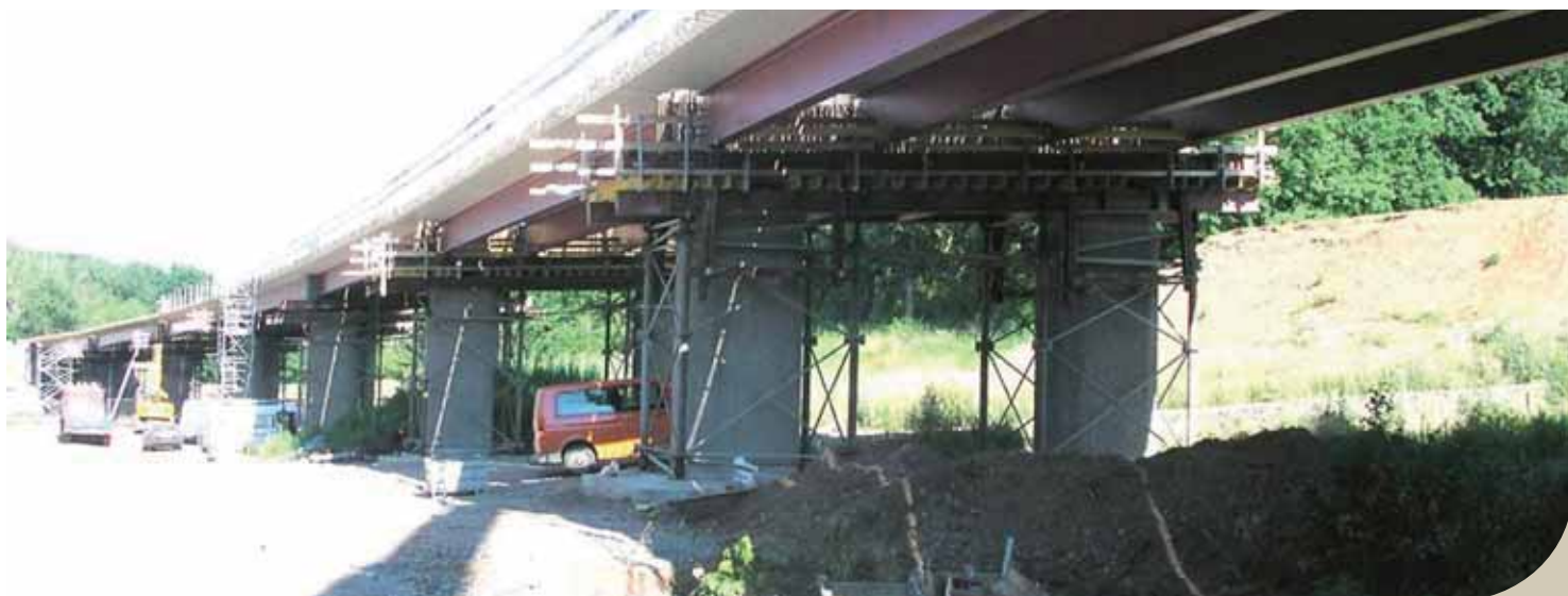
Cet exemple montre le pont à 8 travées Horlofftal à Hungen en Allemagne, construit en 2006. Sur 5 de ces travées, la poutraison est constituée de gros profilés laminés en qualité S460.
