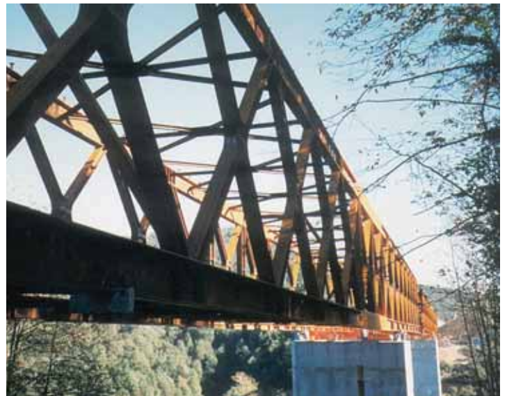
Viaduc routier de Costa Martina, Espagne. – Structure treillis en profilés laminés, continue sur 3 travées de 60,6 - 121,2 - 60,6 mètres. La photo montre le pont avant le montage des éléments en béton armé préfabriqués de la dalle.
