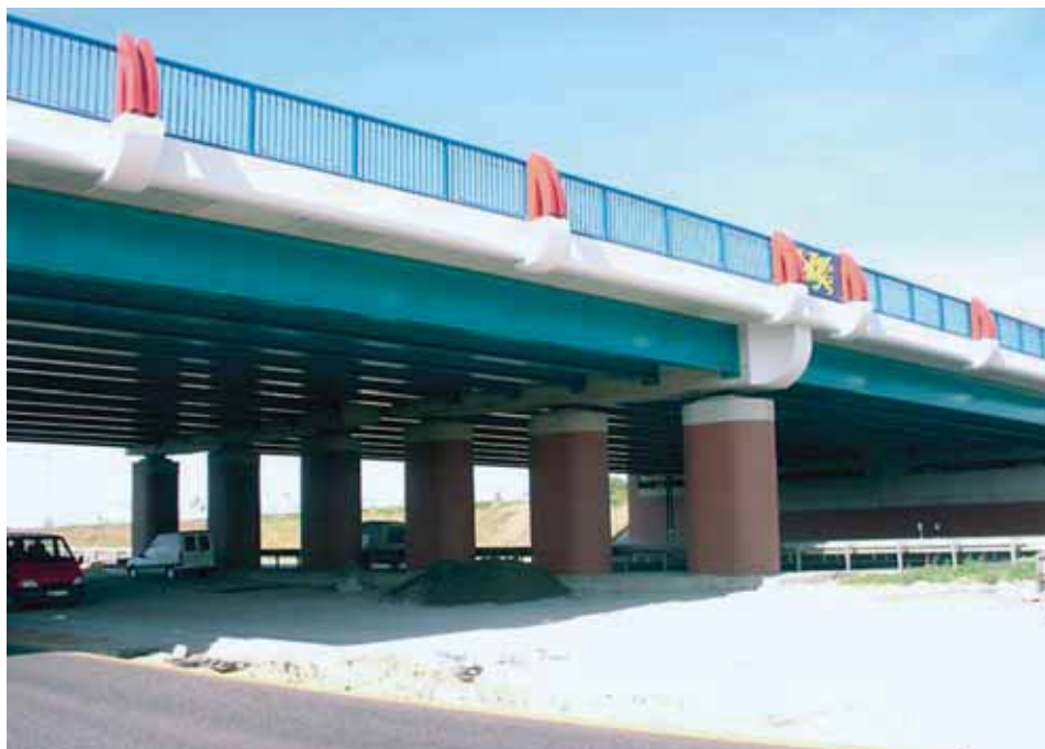
Pont mixte avec des entretoises en béton à Bentwisch, Allemagne, A noter la mise en valeur de l'acier par le choix de couleurs vives
