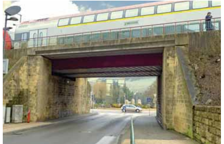
Nouveau franchissement de la rue Emile Mark à Differdange, Luxembourg – Le choix d'un Pont Rail à Poutres Latérales pour chacune des deux voies uniques s'est imposé par sa hauteur de construction très faible.
