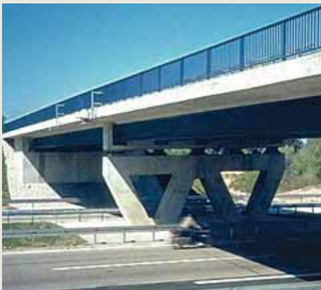
Pont-route à Bremgarten, Allemagne – avec entretoises en béton et support indirect
