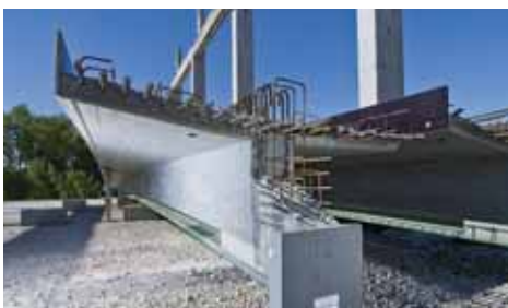
Utilisation de PreCoBeam pour un pont à Vigaun, Autriche
