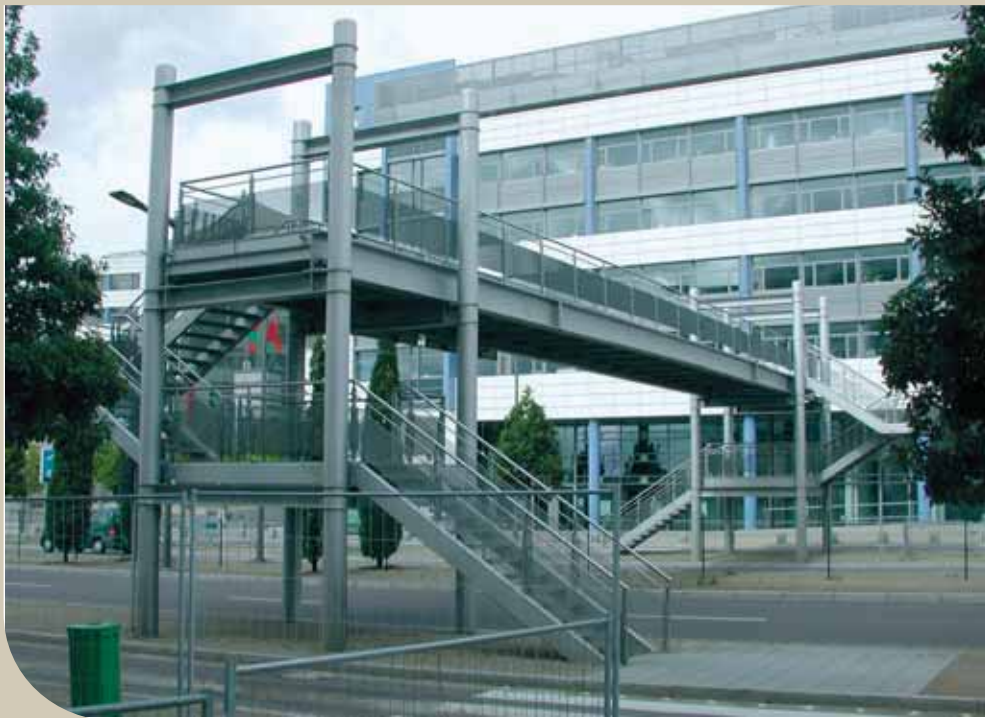
Passerelle pour piétons au Kirchberg, Luxembourg
