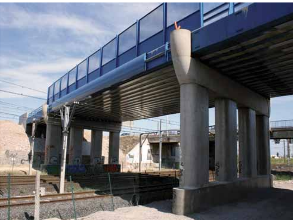
Ouvrage ferroviaire à Frontignan - Sète, France
