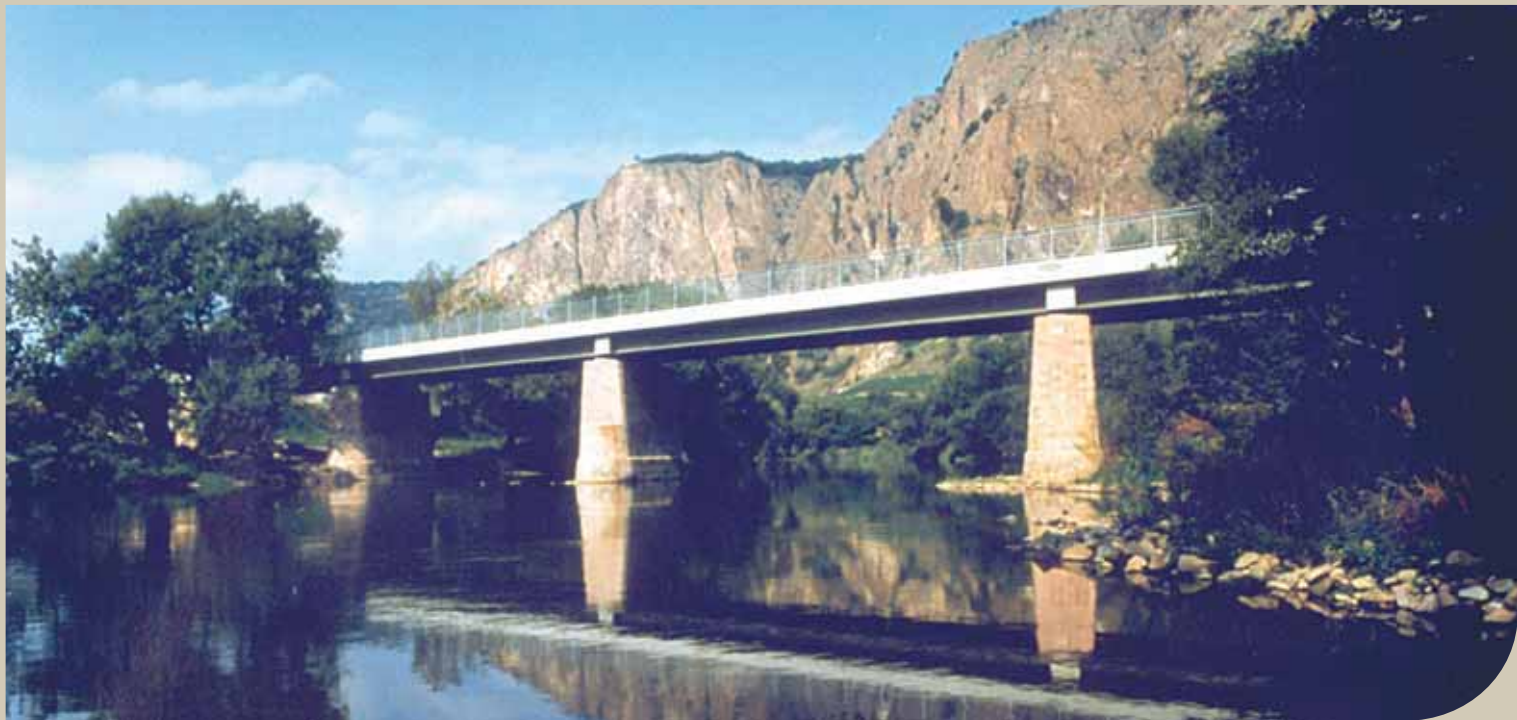
Reconstruction du pont sur la Nahe près de Bad Münster am Stein, Allemagne – Ce pont se situe dans une réserve naturelle. Un tablier mixte a été posé sur les piles existantes.
