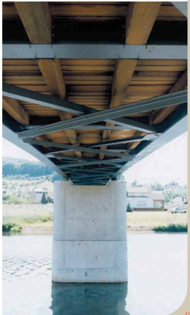
Vue de dessous montrant les pièces de pont et contreventements du pont de Steinheim, Luxembourg
