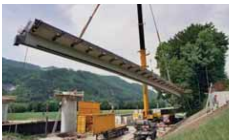
Levage d'une poutre PreCoBeam sur le site de Vigaun, Autriche
