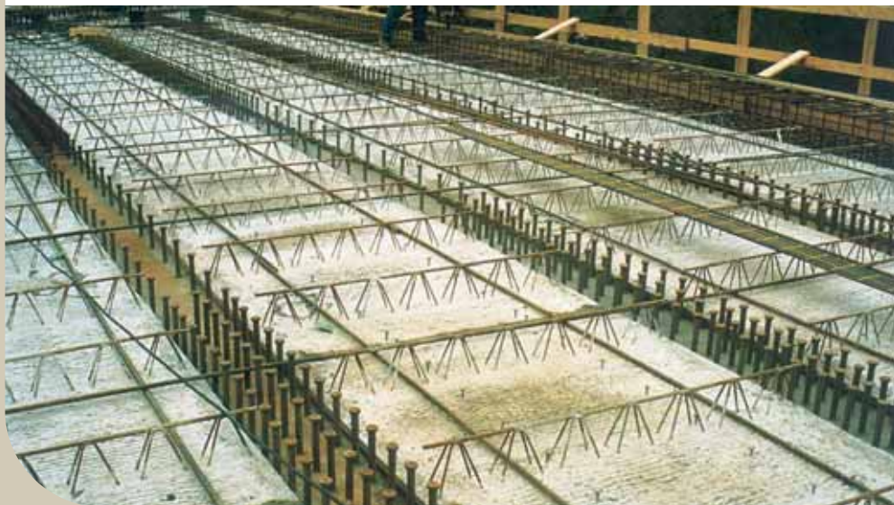
Coffrage en prédalles.
