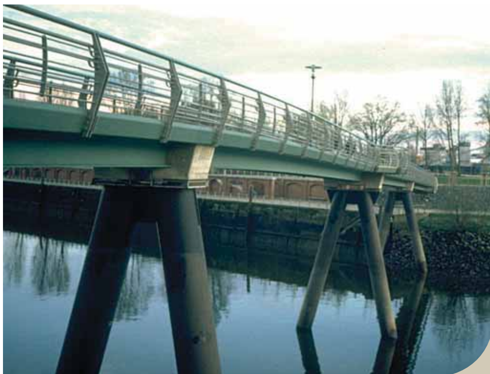
Passerelle piétons sur le Haken à Hambourg (D) tablier mixte avec 4 travées de 25m
