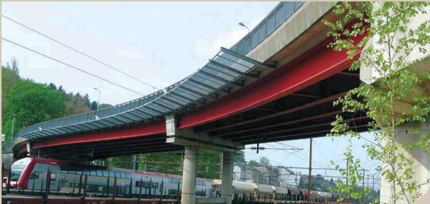
Pont route à Differdange- Pont avec une importante courbure suivant l'axe faible (voir montage des deux poutres maitresses à la page 7)
