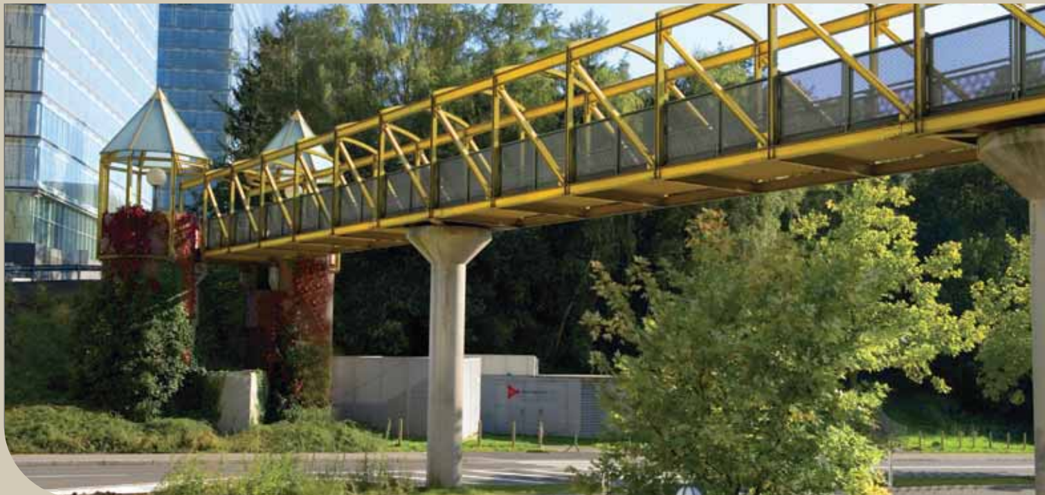
Passerelle d'accès au bâtiment de la Cour de Justice des Communautés Européennes à Luxembourg. – conçue sous la forme d'un treillis
