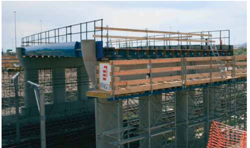
Assemblage de la première travée au dessus d'une voie existante.
