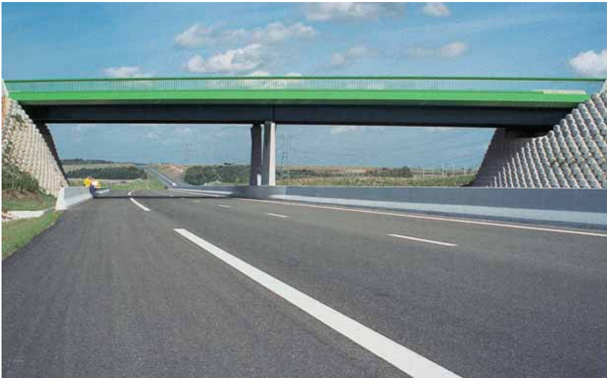
Passage supérieur de l'autoroute A16, France. - Tablier mixte de 2 x20m formé de deux poutres HL1100 en acier S460M à haute limite d'élasticité.
