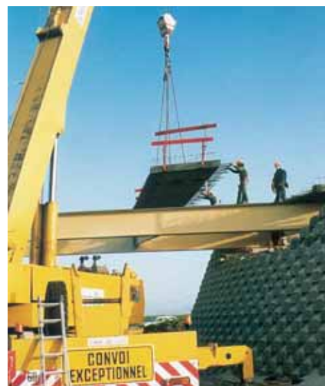
Tablier préfabriqué. - Montage d'une dalle en béton préfabriquée.
