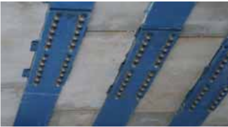
Connexion rigide par éclisses boulonnées
