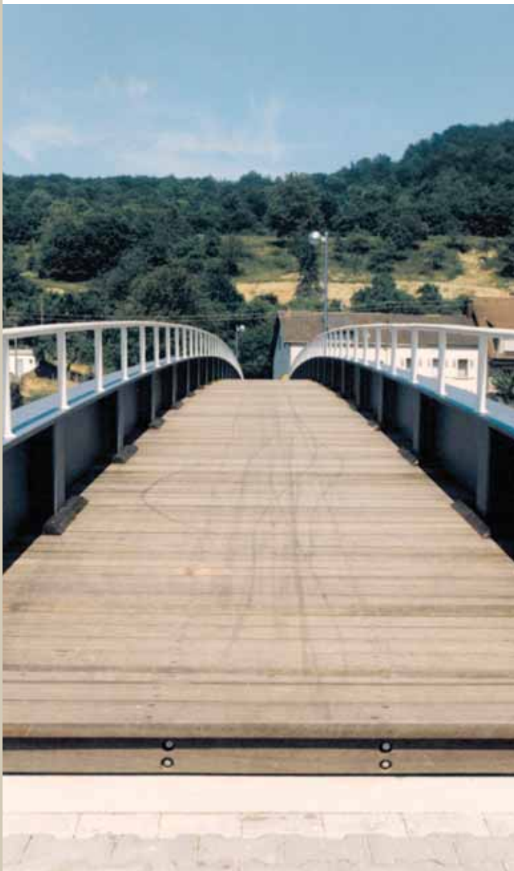
Vue du platelage en bois du pont à poutres latérales en profilés laminés de Steinheim, Luxembourg
