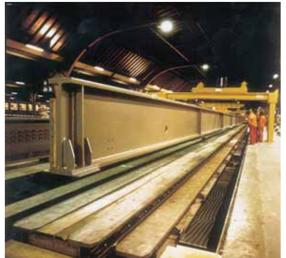
Transformation des quais de la gare centrale de Zurich. – Les anciens tabliers sont remplacés par des tabliers à poutres latérales continues sur 5 travées. Une cuve en béton armé maintient la voie ballastée. Les poutrelles assemblées en longueurs de 69 m sont montées avec un portique de manutention dans un temps très court et un espace réduit.
