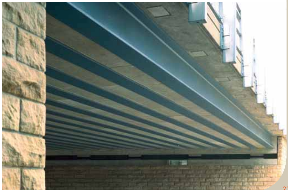
Vue de dessous d'un tablier à poutrelles enrobées. – Seules les ailes inférieures des poutrelles sont visibles.
