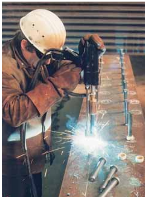
Atelier de parachèvement – Soudage de goujons
