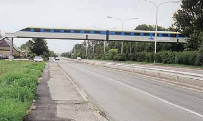
Passerelle pour les visiteurs d'un parc d'attractions à Wavre, Belgique. – Structure métallique avec couverture et habillage figuratif.
