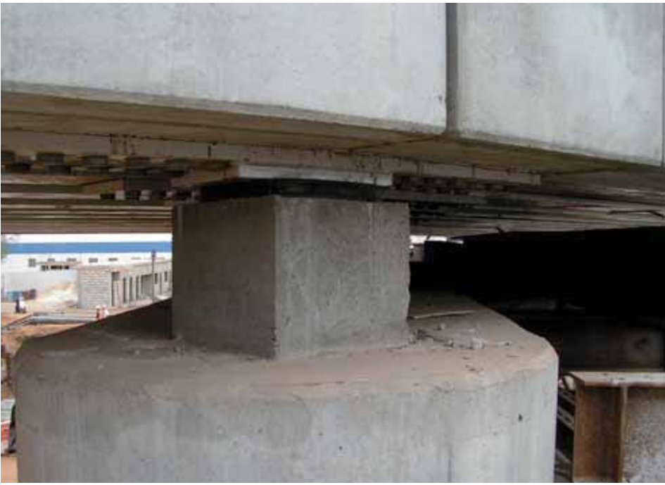
Pont de Cyrnos à Dakar au Sénégal détail de l'appui
