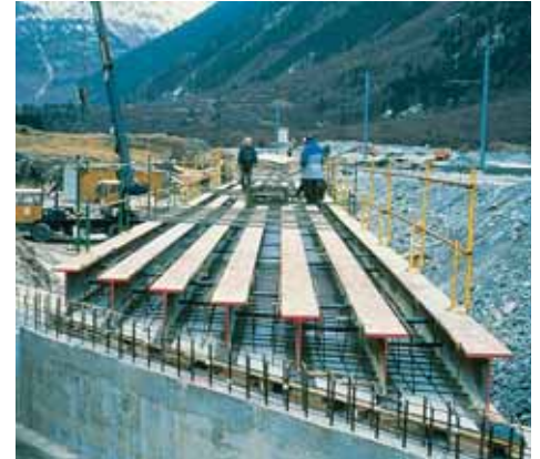
Construction d'un pont-rail à poutrelles enrobées dans le cadre de la réalisation du tunnel routier du Puyomons entre la France et l'Espagne.
