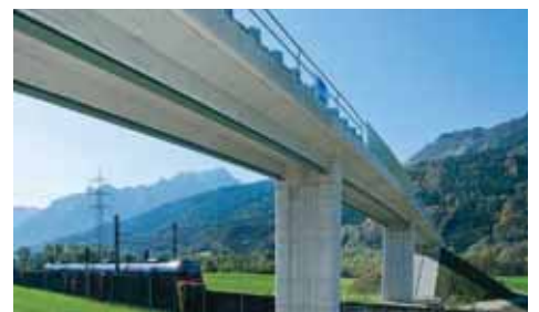
Vue du pont de Vigaun en PreCoBeam constitué de 3 travées de 26,15 m avec un élanement de 1/23.
