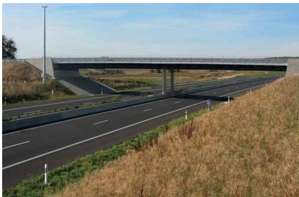
Pont à deux travées (de 23,90m) sur l'autoroute A13 vers la Sarre, Luxembourg - Le pont mixte est un bipoutre formé de caissons constitués de deux poutres laminées soudées entre elles longitudinalement.
