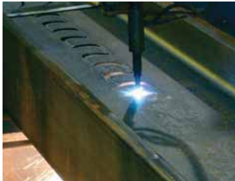
Oxycoupage avec la forme en aileron de requin d'un profilé laminé (HD400x42) 1 en S460 pour le pont PreCoBeam de Vigaun, Autriche.
