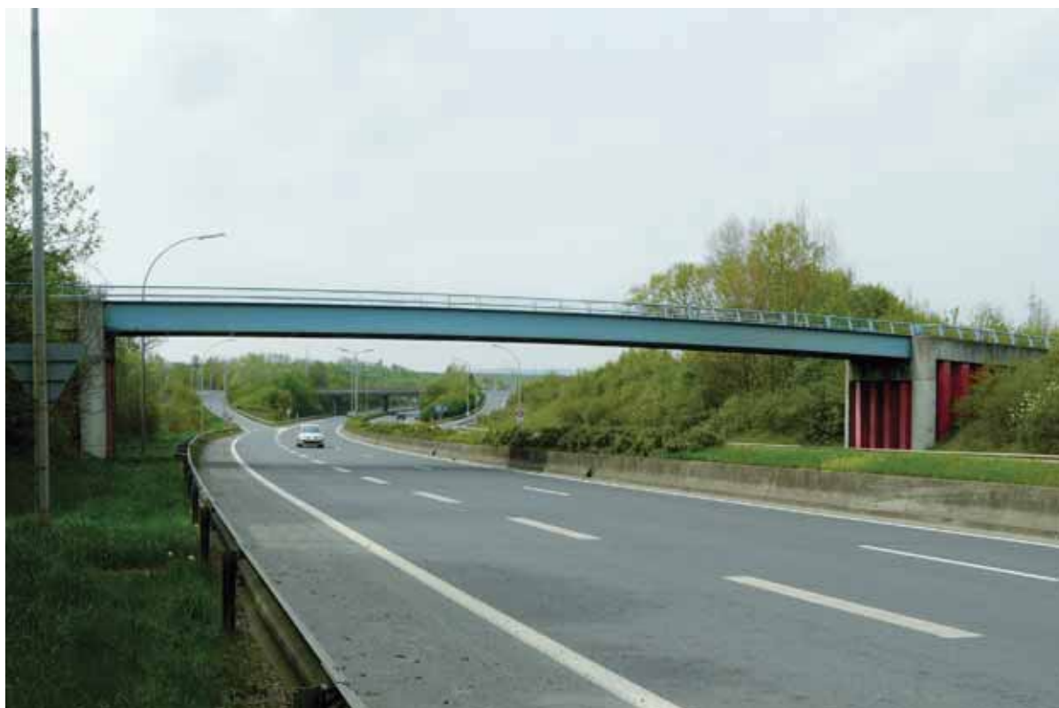
Passerelle franchissant la voie express A13 à Soleuvre, Luxembourg - Mise en valeur de l'acier par la couleur.
