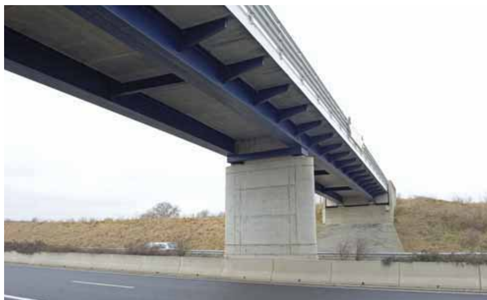
Pont sur la liaison vers la Sarre, Luxembourg - Le porte-à-faux important est étudié pour supporter les éléments préfabriqués en béton sans échafaudages pendant la construction, les caissons étant conçus pour résister au moment de torsion résultant.
