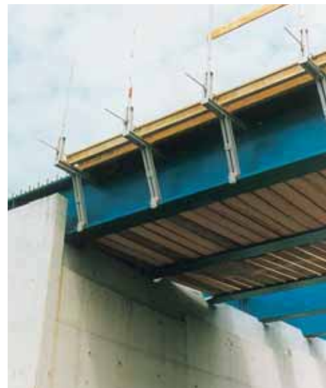
Exemple d'un support du coffrage de l'encorbellement.
