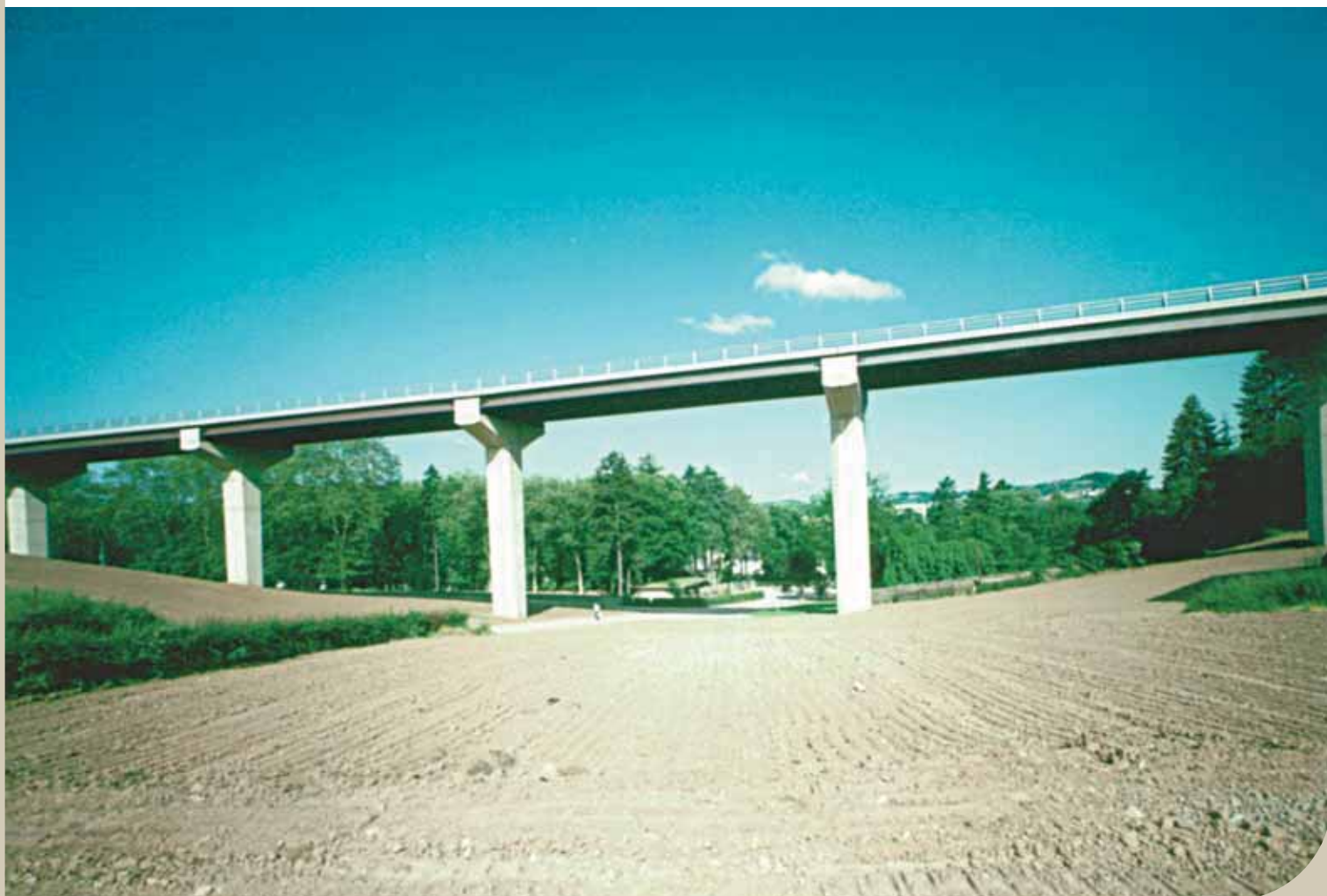
Viaduc multi-travées à Ditgesbaach, Luxembourg
