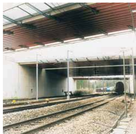
Franchissement des voies ferrées d'une ligne à fort trafic. - Les semelles inférieures des poutrelles enrobées sont durablement protégées par un traitement anticorrosion à hautes performances.
