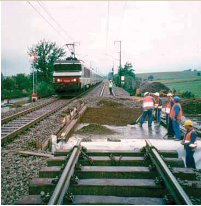
Ouvrage ferroviaire à Berchem au Luxembourg. Mise en place le long des voies d'un demi-ouvrage préfabriqué, sous circulation (en parallèle) à vitesse réduite.
