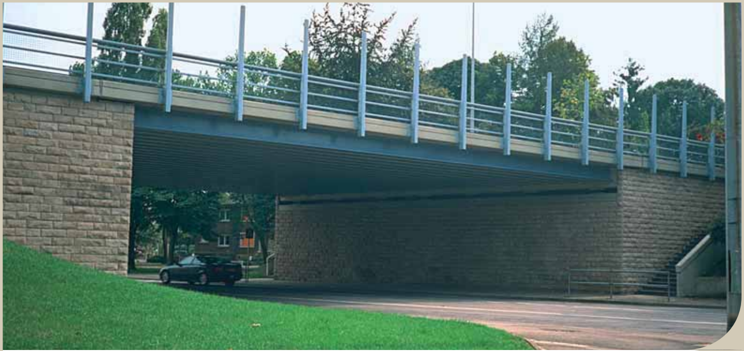
Pont-route à poutrelles enrobées à Esch-sur-Alzette, Luxembourg. – Portée 19 m; hauteur de construction 0,65 m. Pour des raisons architecturales, les poutres de rive ne sont pas enrobées laissant visible leur face extérieure.
