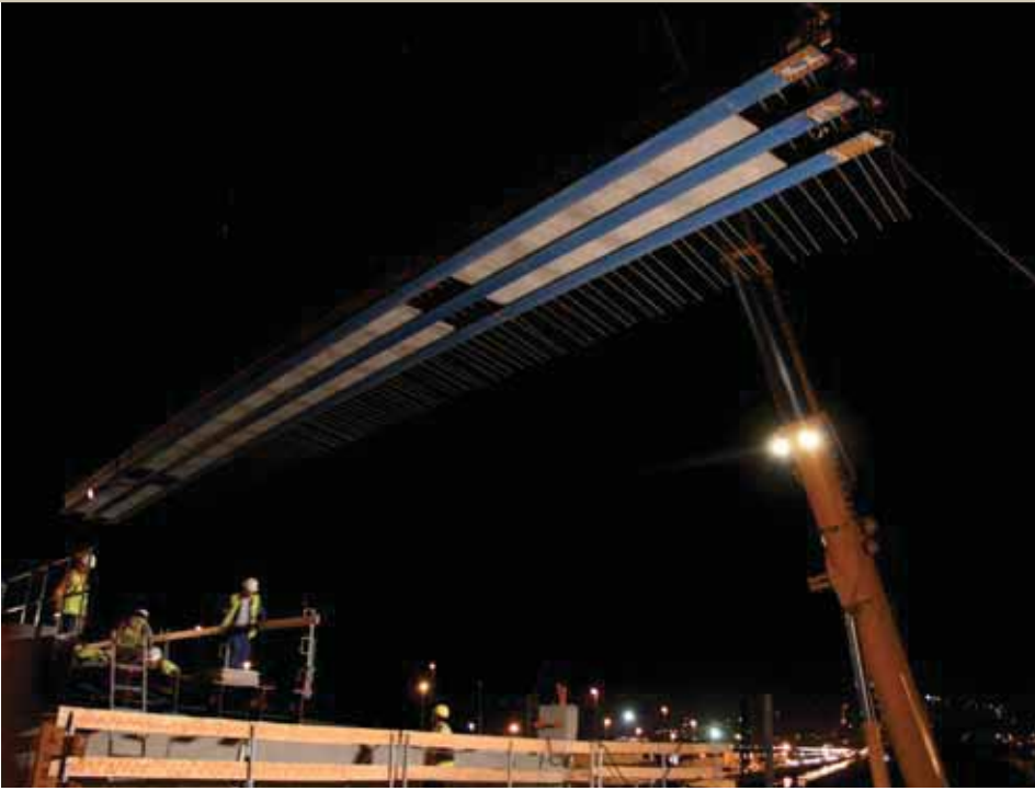
Levage d'un ensemble pré-assemblé au dessus d'une voie existante.
