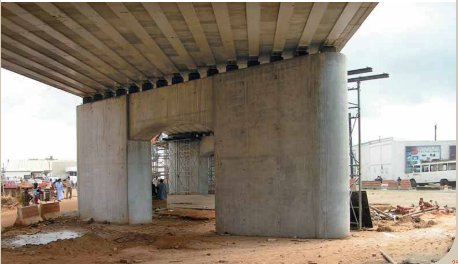
Pont de Cyrnos à Dakar au Sénégal vue de la sous-face et d'une pile intermédiaire
