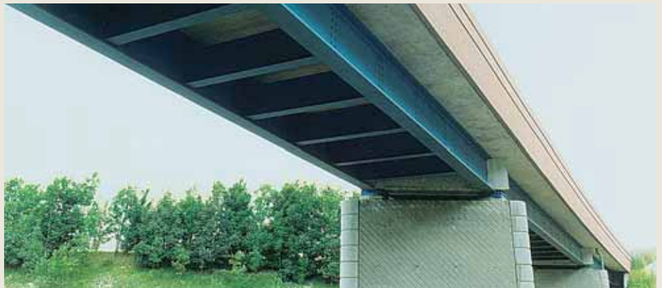
Pont de la ligne TGV Nord sur l'autoroute A23 à Fretin, France. - Tablier mixte à quatre travées de 16,9 - 21,9 - 23,0 - 17,8 mètres. Les deux poutres maîtresses et les entretoises en travée sont des poutrelles laminées; les entretoises sur appui sont en béton armé.
