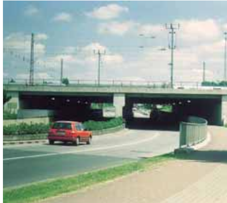
Pont de chemin de fer à plusieurs voies à Nienburg, Allemagne. - Les profils en long des voies ferrées et de la route limitent fortement l'épaisseur du tablier.
