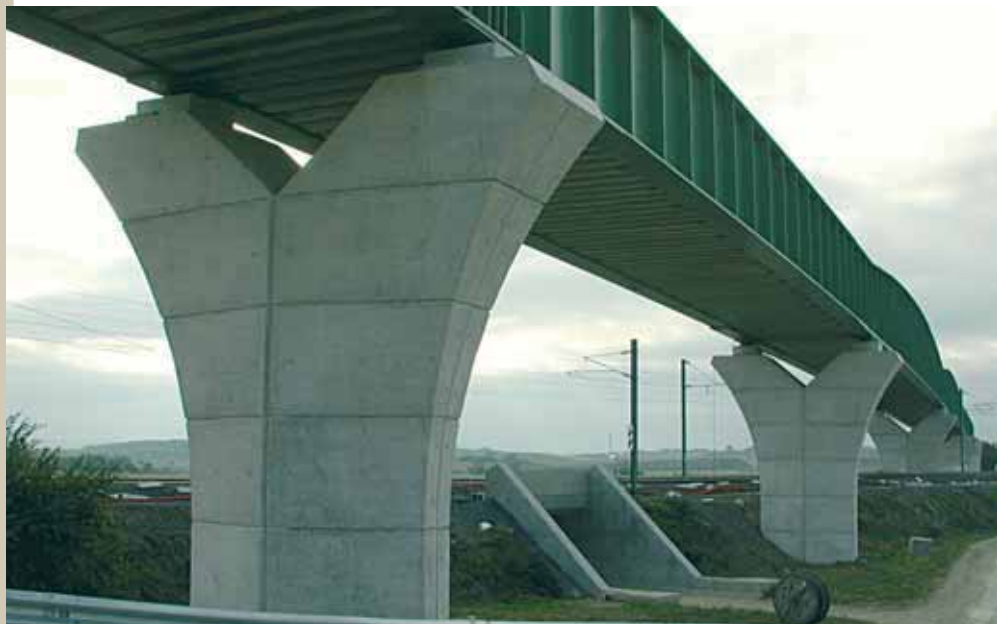
Pont de la LGV Est, France
