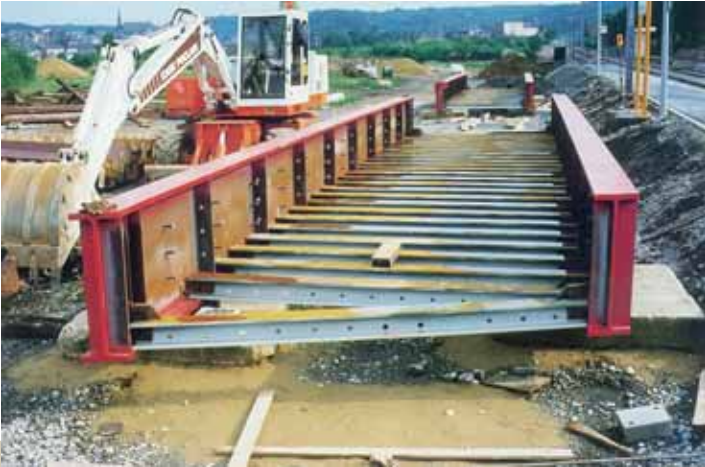
Franchissement de la rue Emile Mark à Differdange, Luxembourg – Remplacement de deux tabliers à pose directe des rails par deux tabliers intégrant une voie ballastée ce qui a considérablement réduit la hauteur de construction disponible, justifiant le choix d'un pont RAPL. La photo montre l'ossature d'un des 2 ponts, assemblée par boulonnage sur une aire de préfabrication, avant son bétonnage.
