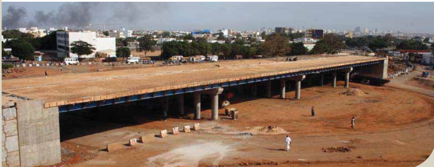
Brücke von VDN in Dakar, Senegal.
