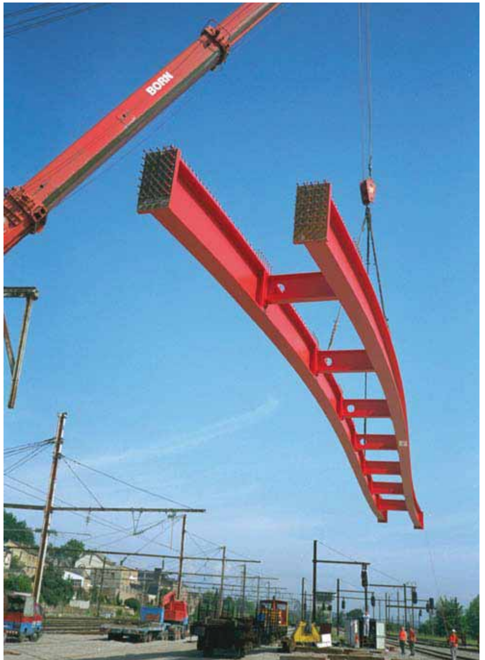
Straßenbrücke in Differdingen, Luxemburg. – Kranmontage der Hauptträger, welche zur Anpassung an die Geometrie der Straßentrasse um beide Querschnittsachsen gebogen wurden.
