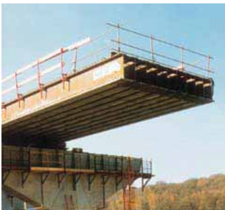
Eisenbahnbrücke der Hochgeschwindigkeitsstrecke TGV Atlantique in Massy, Frankreich. – Längseinschieben der Träger über die Zufahrtsstraßen der Autobahn A10.
