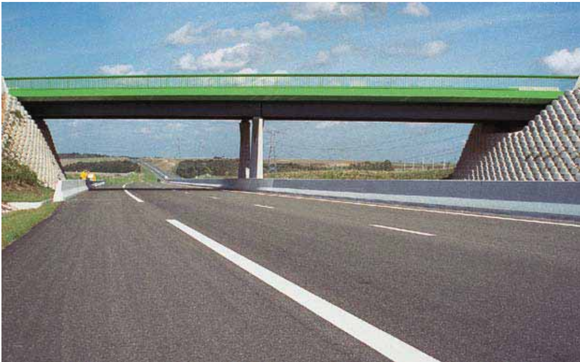
Straßenbrücke über die Autobahn A16, Frankreich. – Verbundüberbau mit zwei Hauptträgern aus hochfestem Stahl S460M.
