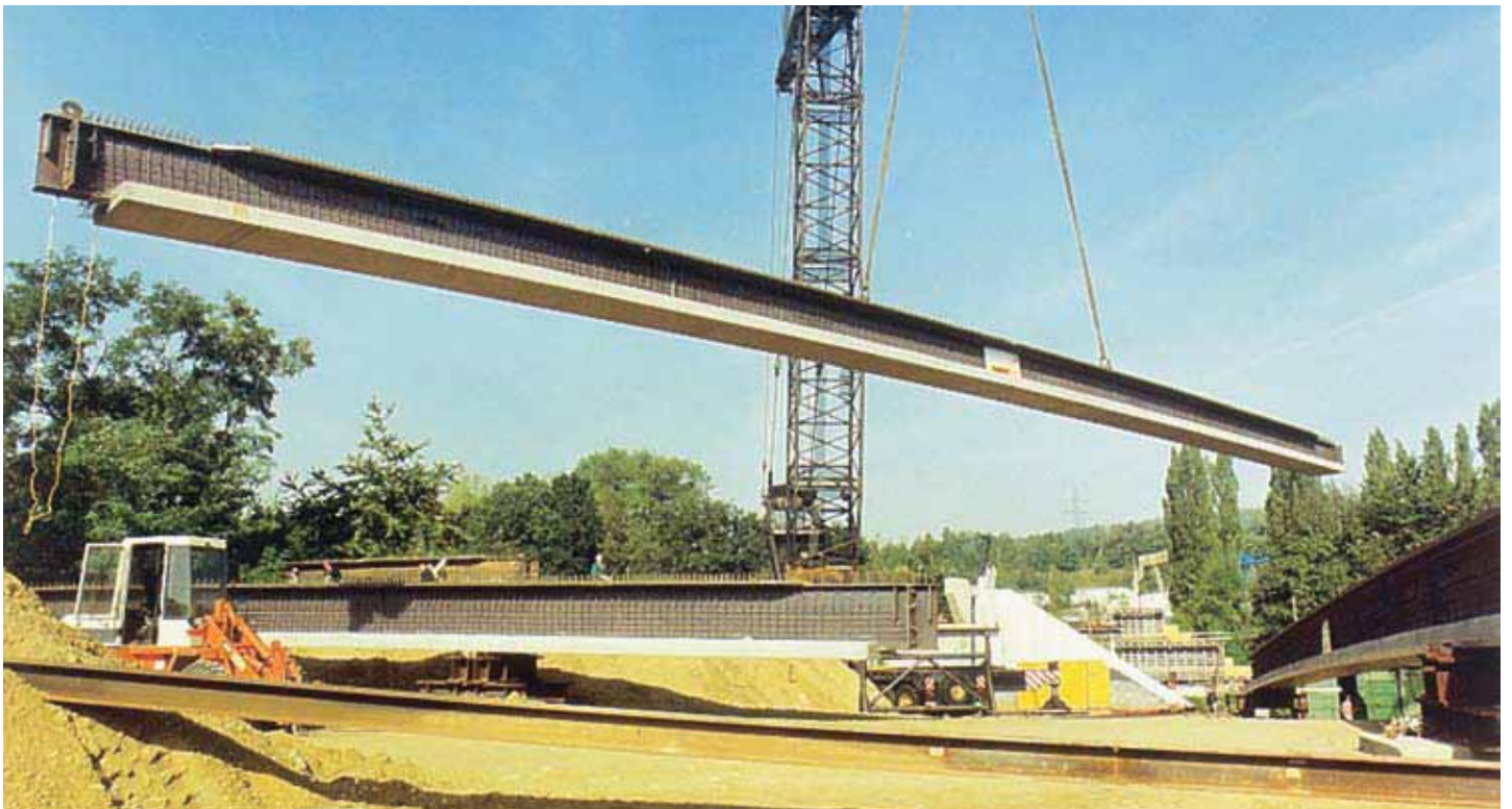
41,25 m lange HEA 1000 Träger mit vorgespannten Betonuntergurt in Preflex-Bauweise für eine Einfeldstraßenbrücke in Kerpen Horrem, Deutschland.
