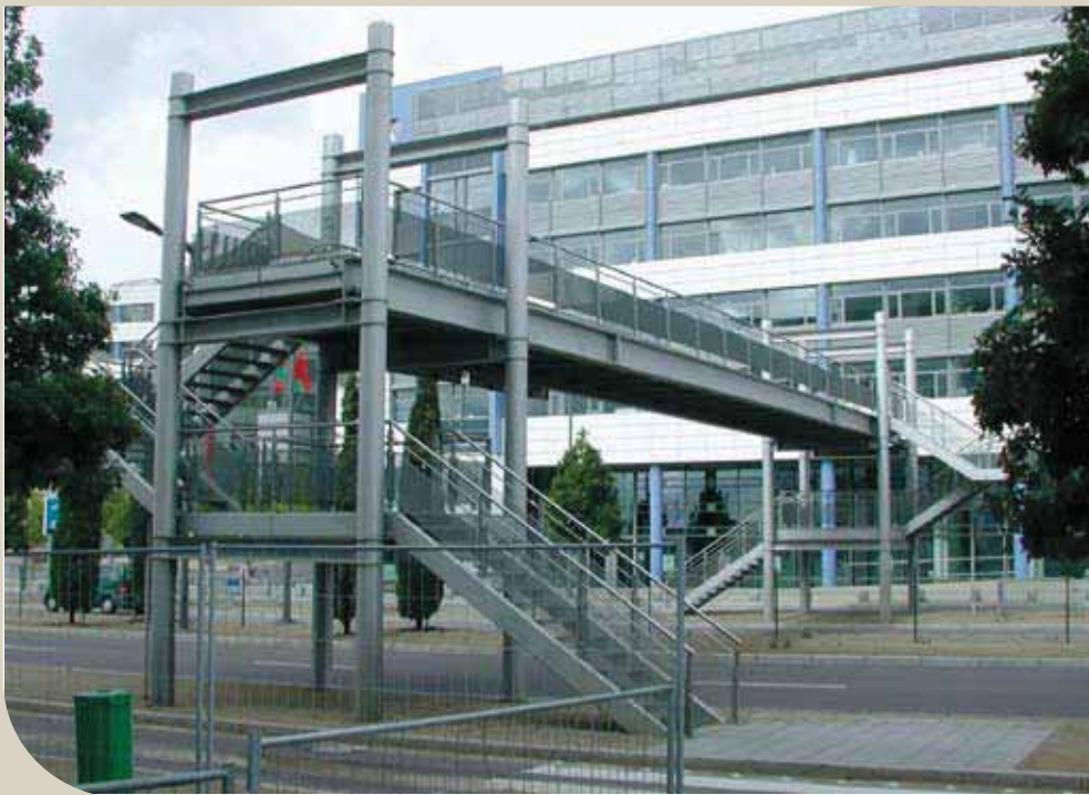
Stählerner Fußgängerüberweg in Kirchberg, Luxemburg.
