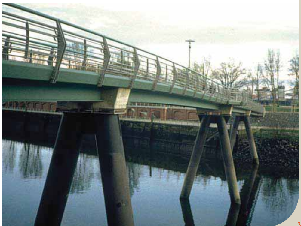
Fußgängerbrücke über den Haken in Hamburg, Deutschland – Schlanke Verbundkonstruktion mit 4 Stützweiten von 25 m.
