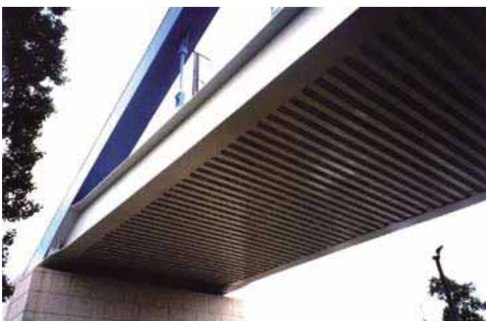
Stabbogenbrücke der LGV Méditerranée Hochgeschwindigkeitsbahnstrecke über die Autobahn A7 bei Avignon, Frankreich. – Eine Walzträger in Beton Lösung wurde in Querrichtung als Trogboden ausgeführt.
