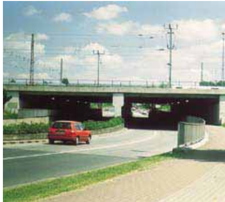
Mehrgleisige Eisenbahnbrücke in Nienburg, Deutschland. – Die Längsprofile der Straße und der Gleise bedingen eine sehr geringe Bauhöhe.
