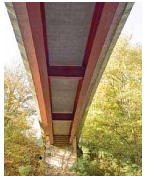
Fußgängerbrücke in Wasserbillig, Luxemburg. - Ausführung in Verbundbauweise mit zwei Hauptträgern und einer oben liegenden Stahlbetonplatte.
