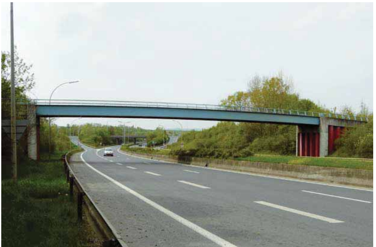
Fußgängerbrücke über die Schnellstraße A13 bei Soleuvre, Luxemburg. – Gestaltung mit Stahl und Farbe.
