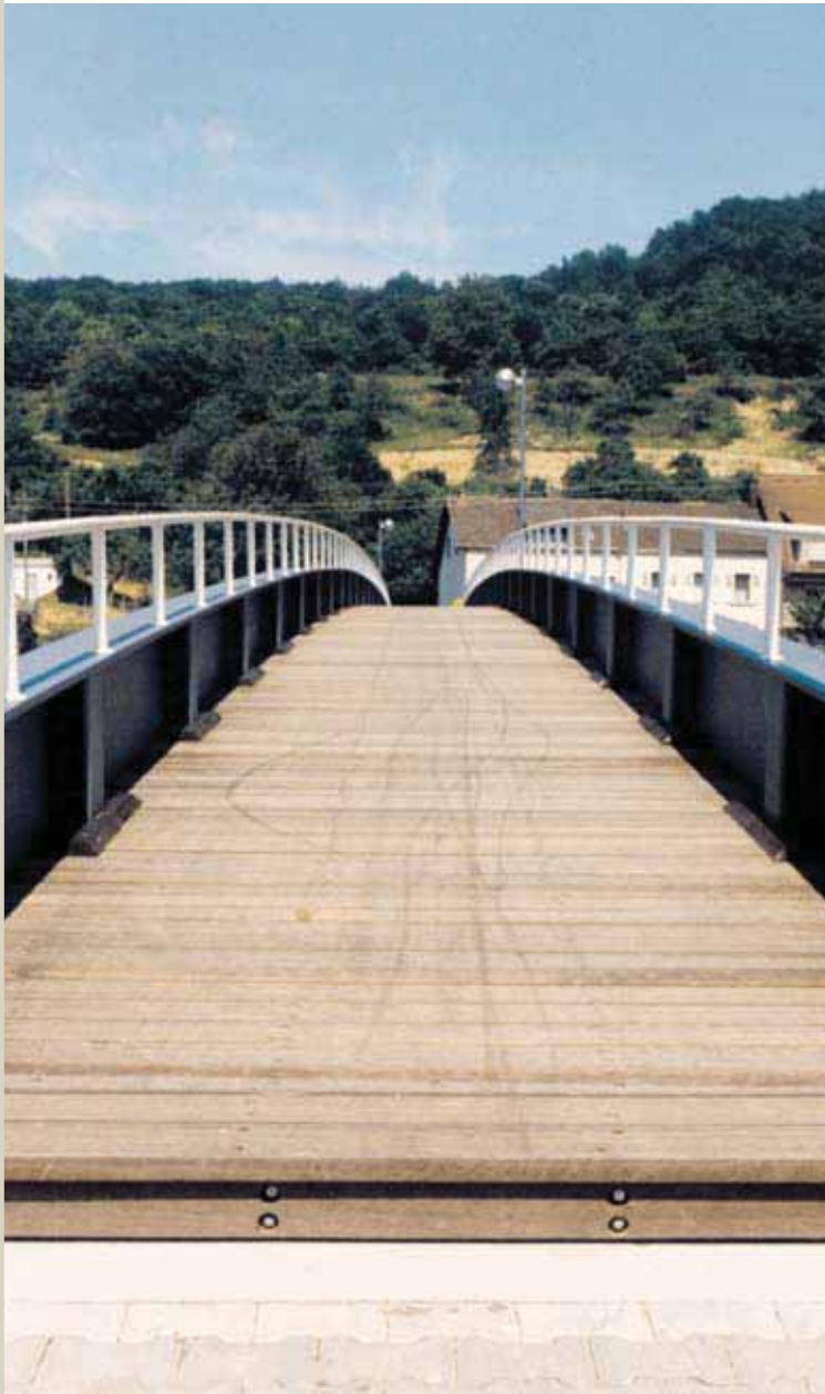
Fußgängerbrücke über die Sauer bei Steinheim, Luxemburg. – Ansicht entlang des Trogquerschnitts mit einem Gehweg aus Holzbohlen
