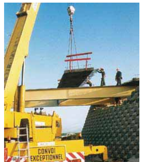
Fahrbahnplatte aus Stahlbetonfertigteilen. – Montage eines Stahlbetonfertigteils
