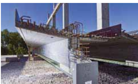
PreCoBeam Element der Verbundfertigteilbrücke mit Walzträgern in Beton bei Vigaun, Österreich.
