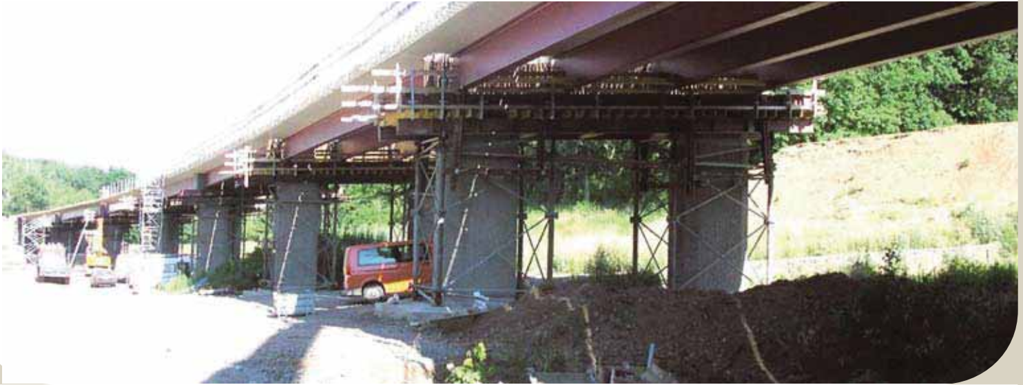
Horlofftalbrücke in Hungen, Deutschland. – Die Straßenbrücke mit 8 Feldern wurde 2006 fertiggestellt - für 5 dieser Felder wurden Verbundfertigteilträger auf Basis schwerer Walzträger in S460 ausgeführt.
