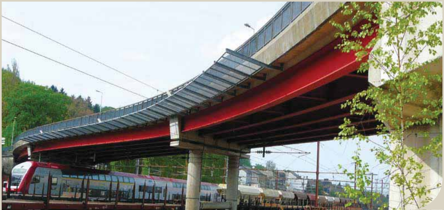
Straßenbrücke in Differdingen, Luxemburg. – Geschwungene Verbundbrücke auf Basis warmgewalzter Hauptträger (auf Seite 7 ist die Montage der Hauptträger abgebildet).
