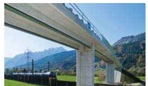
Verbundfertigteilbrücke mit Walzträgern in Beton bei Vigaun, Österreich. – Die Brücke hat drei Stützweiten von 26,15 m und eine Schlankheit von 23.
