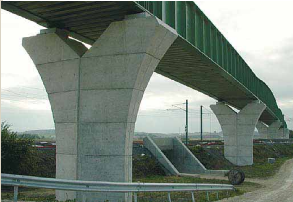
Brücke der LGV Est Hochgeschwindigkeitsbahnstrecke mit Trogquerschnitt und Walzträgern in Beton als Trogboden in Querrichtung.
