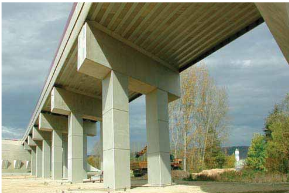
Beispiel eines typischen Querschnittes für eine einleisige Eisenbahnbrücke.
