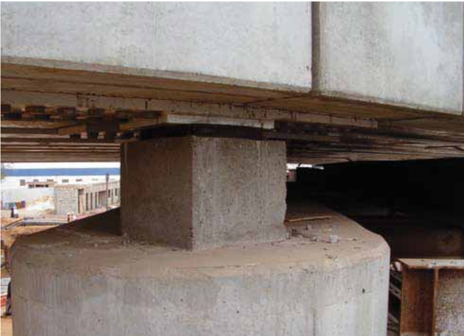
WIB-Brücke Pont de Cyrnos im Senegal. – Detail des Auflagers
