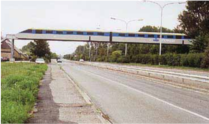
Fußgängerbrücke für Besucher eines Freizeitparks in Wavre, Belgien. – Überdachtes Stahltragwerk mit thematisch gestalteter Verkleidung.
