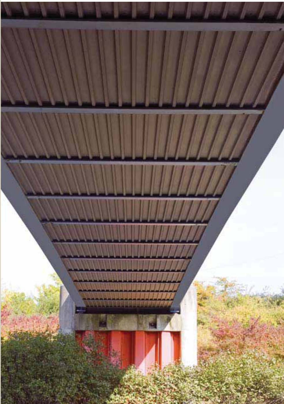
Untersicht Fußgängerbrücke über die Schnellstraße A13 bei Soleuvre, Luxemburg. – Die Auflager sind durch Spundbohlen gesichert
