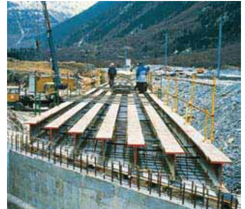
Bau einer WIB Eisenbahnbrücke zum Puymorens - Straßentunnel, der Verbindung zwischen Frankreich und Spanien.
