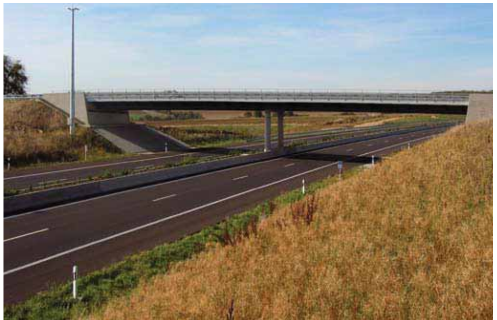
Straßenbrücke über die Autobahn A13, Luxemburg. – Zweifeldbrücke mit als Hohlkasten, längsverweißen Walzträgern als Hauptträger in Verbundbauweise.
