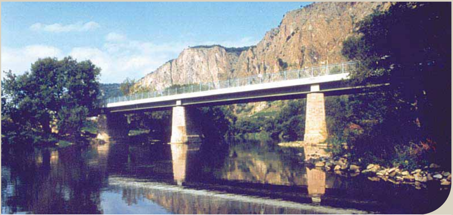
Ersatzneubau der Brücke über die Nahe bei Bad Münster am Stein, Deutschland. – Für diese in einem Naturschutzgebiet liegende Brücke ist ein Verbundüberbau auf den alten Pfeilern errichtet worden.
