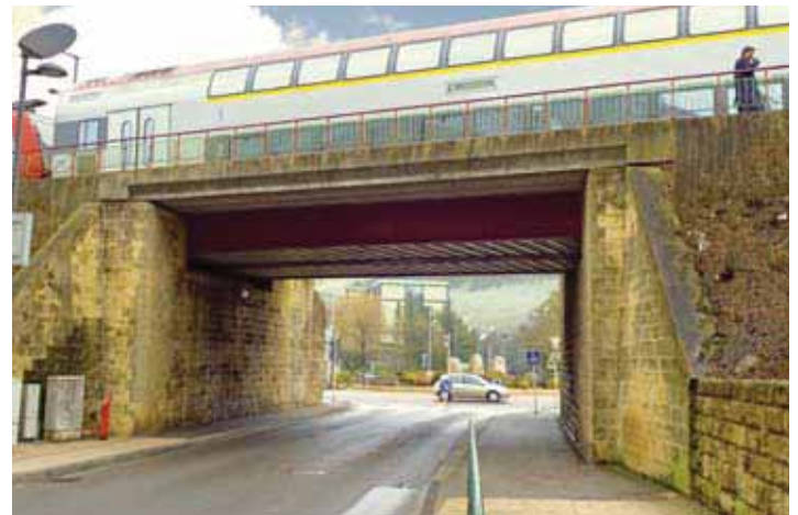
Ersatzneubau der Eisenbahnbrücke über die Emile Mark Straße in Differdingen, Luxemburg. – Bedingt durch den Bauablauf und der eingeschränkten Konstruktionshöhe sind zwei eingleisige Trogüberbauten ausgeführt worden.
