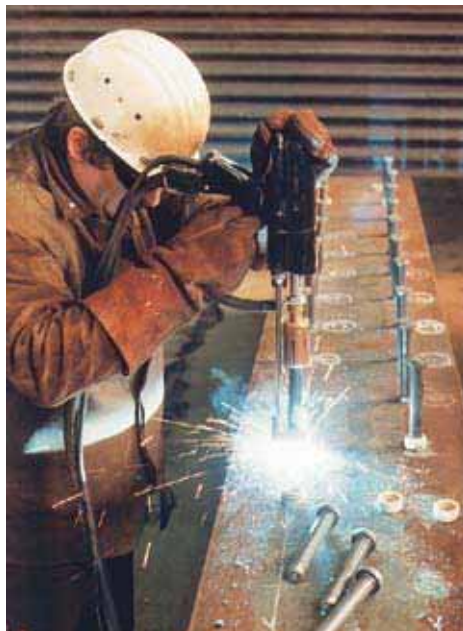
Anarbeitung von ArcelorMittal Commercial Sections Aufschweißen von Kopfbolzendübeln.
