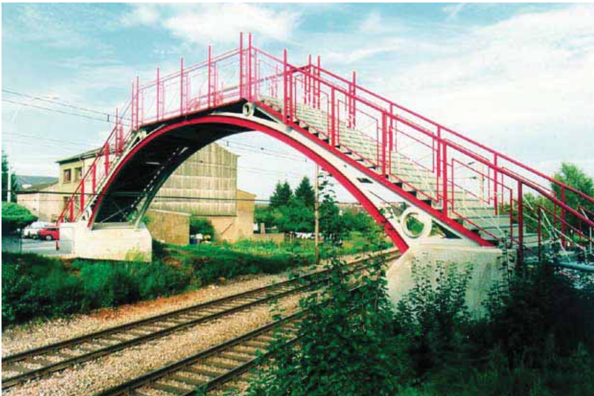
Fußgängerbrücke in Schiffingen, Luxemburg. – Formgestaltung durch stark gebogene, farblich abgesetzte Hauptträger.
