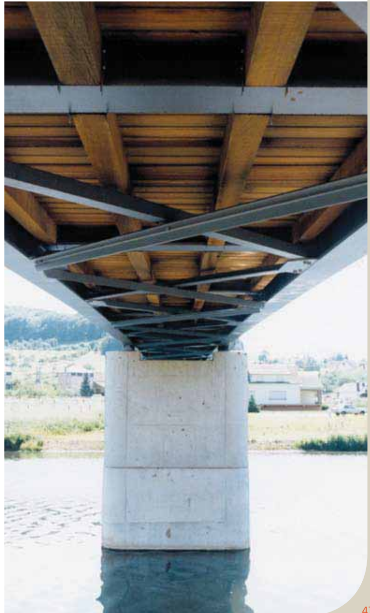
Fußgängerbrücke über die Sauer bei Steinheim, Luxemburg. – Untersicht auf den Windverband.
