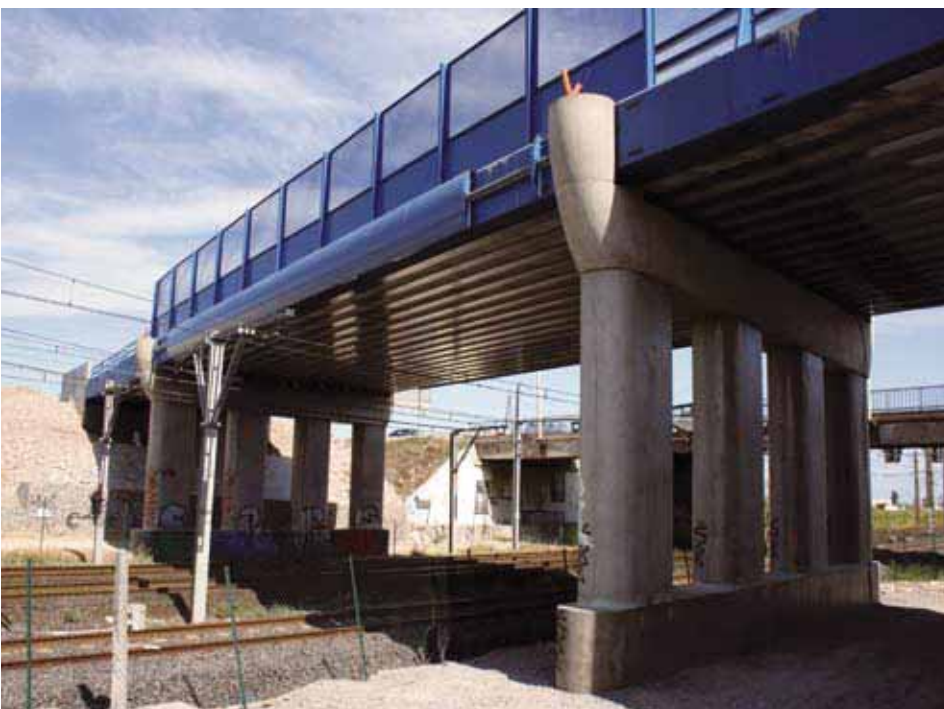
Straßenbrücke bei Sète-Frontignan, Frankreich. – Fertiggestellter Überbau.
