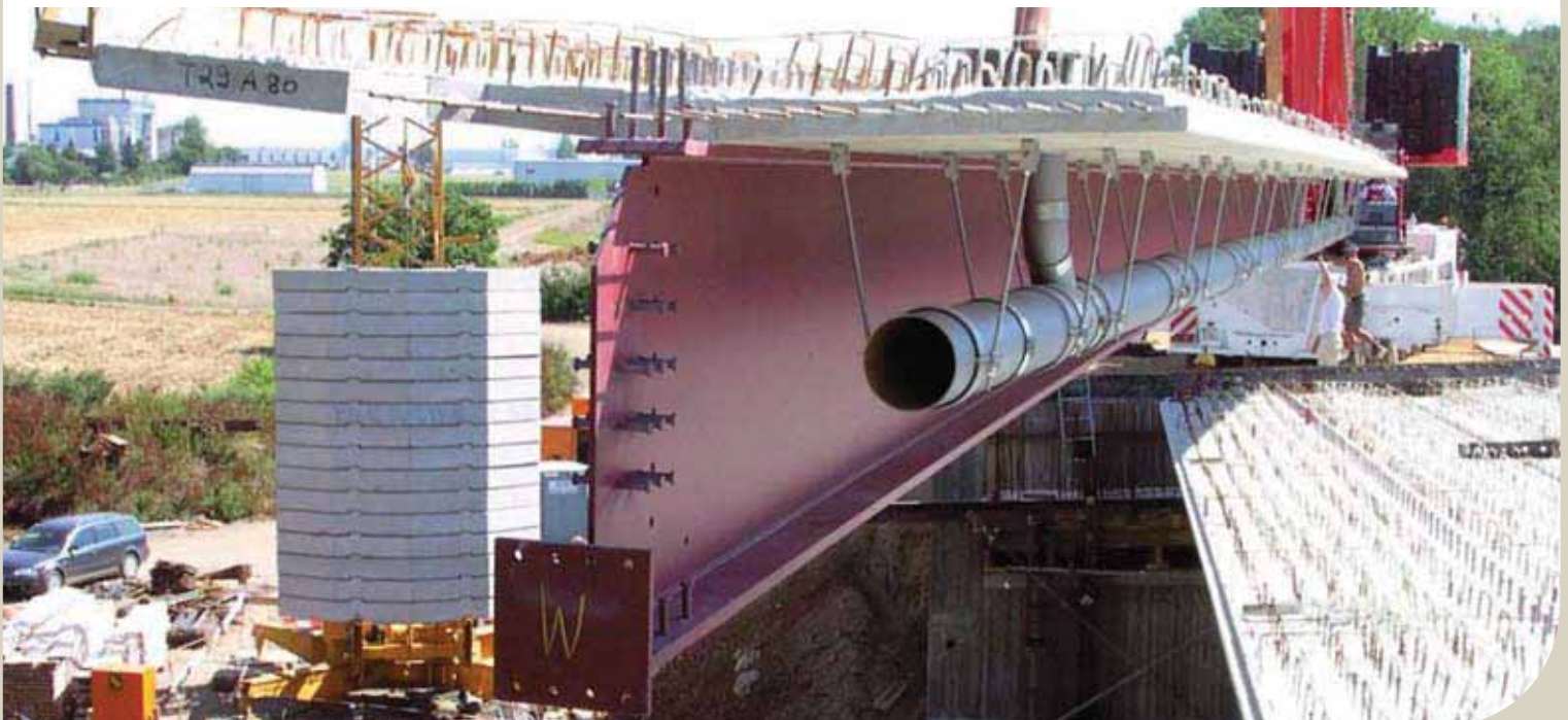
Horlofftalbrücke in Hungen, Deutschland. – Montage eines Verbundfertigteilträgers.
