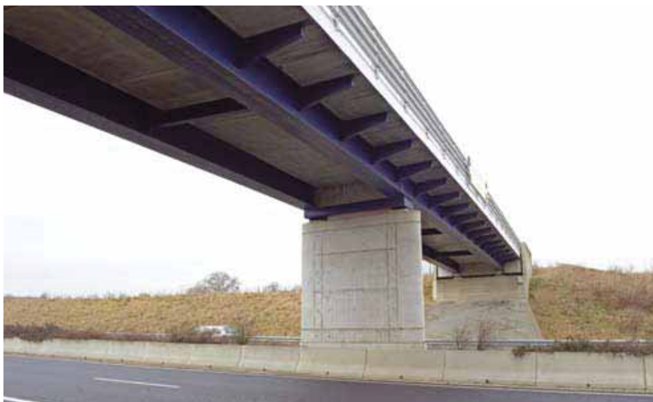
Straßenbrücke über die Autobahn A13, Luxemburg. – Die ausragenden Querträger wurden zur Auflagerung der vorgefertigten Betonfertigteile im Bauzustand ohne Bauwerksunterstützung entworfen, die zwei gruppierten Hohlkastenquerschnitte wurden aufgrund der daraus resultierenden Torsionsmomente gewählt.
