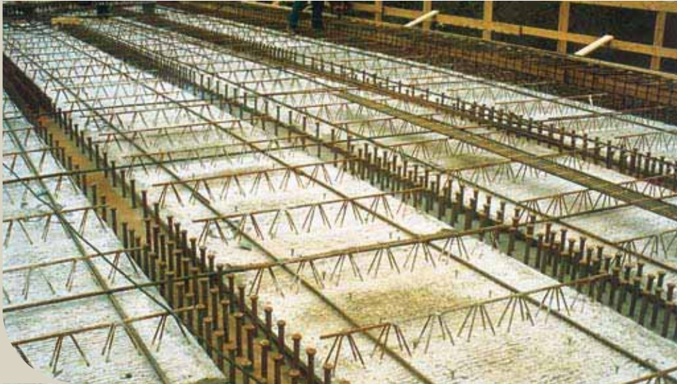
Gitterträgerbewehrte Betonfertigteileplatten einer Verbundbrücke.
