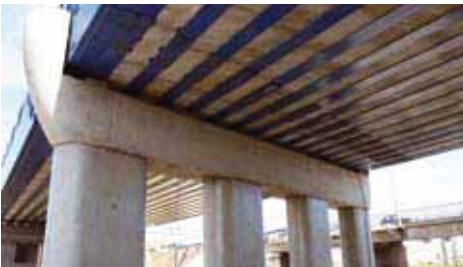
Sicht auf die Auflagersituation.
