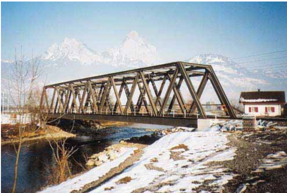
Ersatzneubau einer Muotabrücke an der Gotthardlinie, Schweiz. – Die Diagonalstäbe und Obergurte bestehen aus Walzträgern der Reihen HD und HE. Als Stahl wird wegen der guten Schweißigenschaften eine thermomechanisch gewalzte Güte eingesetzt.
