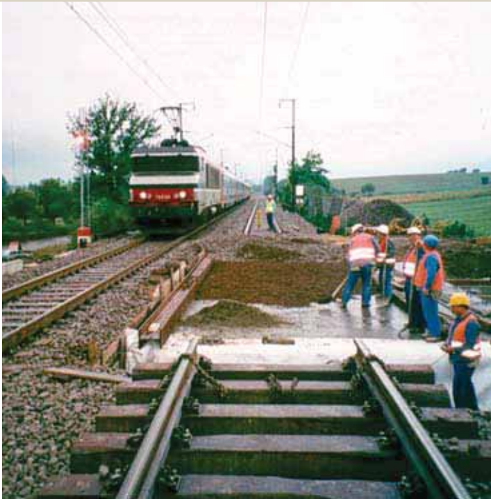
Eisenbahnbrücke bei Berchem, Luxemburg. – Einschub eines vorgefertigten WIB-Überbaus
