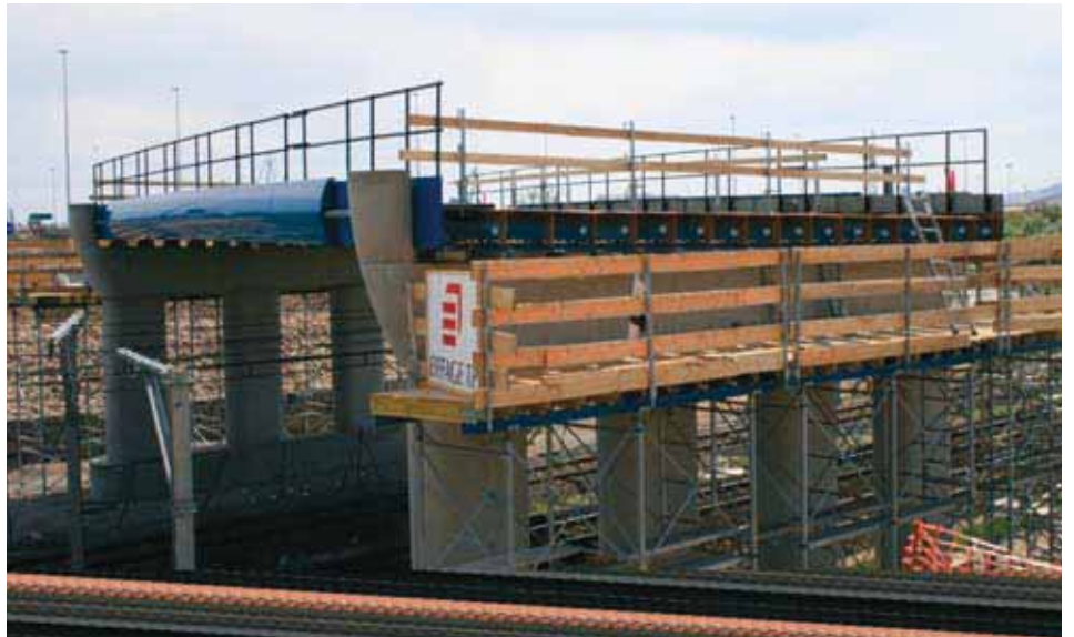
Abschluss des ersten Überbauabschnitts über die bestehende Eisenbahntrasse.
