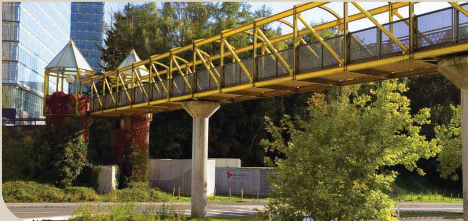
Zugangssteg zum Gebäude des Europäischen Gerichtshofes in Luxemburg. – Entwurf und Gestaltung als Fachwerkbrücke.
