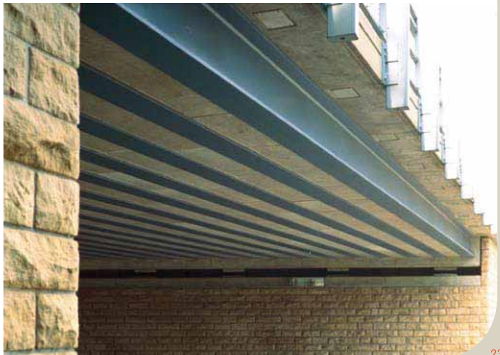
WIB-Strassenbrücke in Esch-sur-Alzette, Luxemburg – Unterseite einer WIB Brückenplatte – Von den Längsträgern sind nur die unteren Flansche sichtbar.
