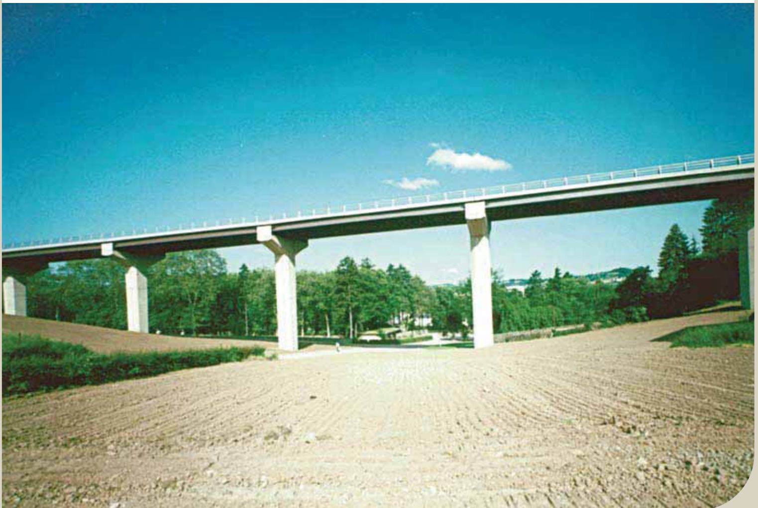
Mehrfeldriges Viadukt in Verbundbauweise bei Ditgesbaach, Luxemburg
