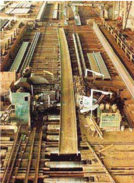
Anarbeitung von ArcelorMittal Commercial Sections Überhöhen von Brückenträgern auf der Presse.
