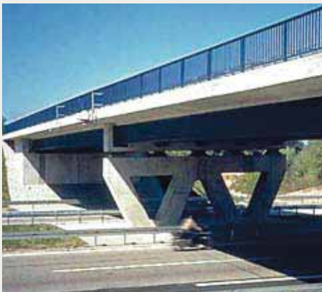
Straßenbrücke bei Bremgarten, Deutschland. - Die Endquerträger sind als Betonquerträger mit indirekter Lagerung ausgebildet.
