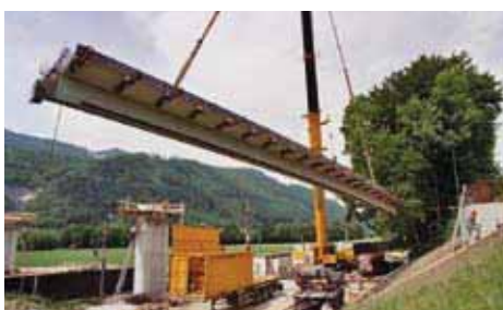
Einbau eines PreCoBeam Elements der Verbundfertigteilbrücke mit Walzträgern in Beton bei Vigaun, Österreich.
